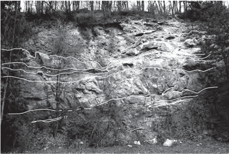
Abb. 19: Mächtigkeitsvariation der Konglomerat-, Brekzien- und Sandsteinlagen im nördlichen (mittleren) Abschnitt des Steinbruchs. Die Zahlen beziehen sich auf die in Abb. 17 dargestellten lithologischen Einheiten.
