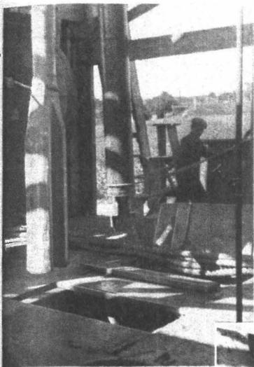
Oben: Schlamm­löffel vor Entleerung. Am Bilde links 16" Bohrmeißel
