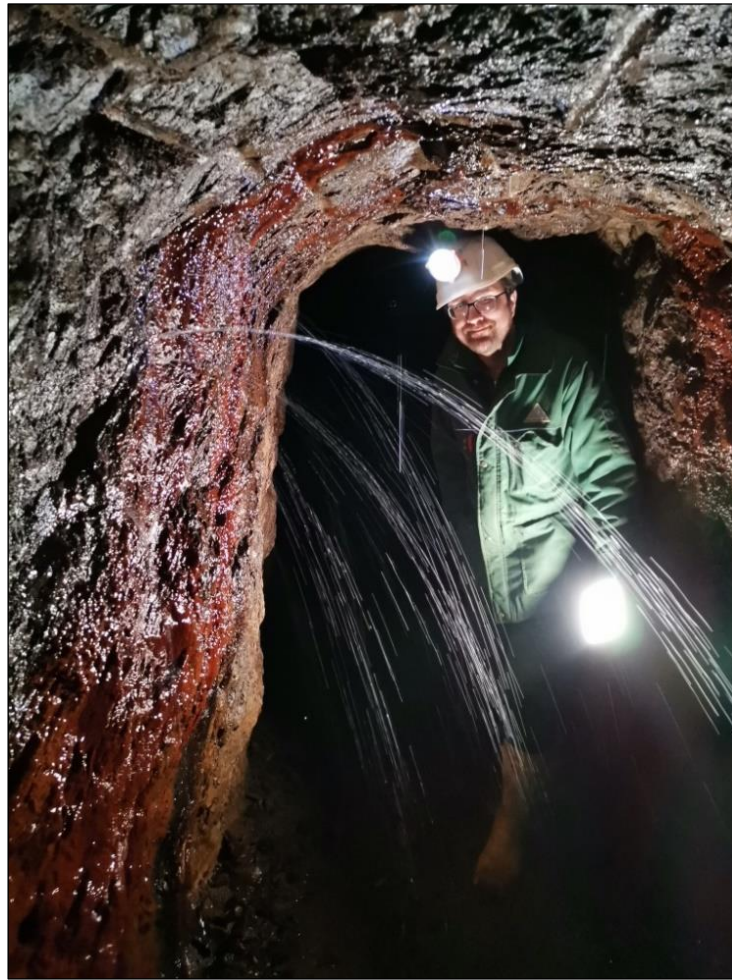
Abb. 5: DI TH. LEITNER, Salinen Austria an einem Quellzutritt der Stampfer Kehr, dem Stampferwasser. Im Bild ebenfalls zu erkennen, die deutliche Rostrotfärbung der Wände durch die Oxidation der Sulfidvererzung. Foto P. Arthofer 2022
