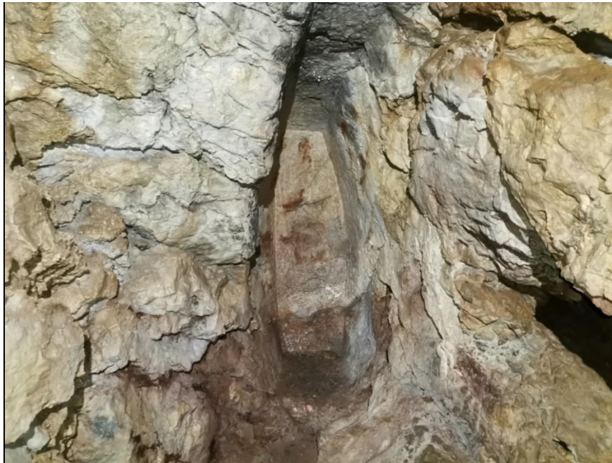
Abb.12: Handgeschrämte Stollenbrüst im Arzloch bei Perneck. Foto P. Arthofer, Steyr
