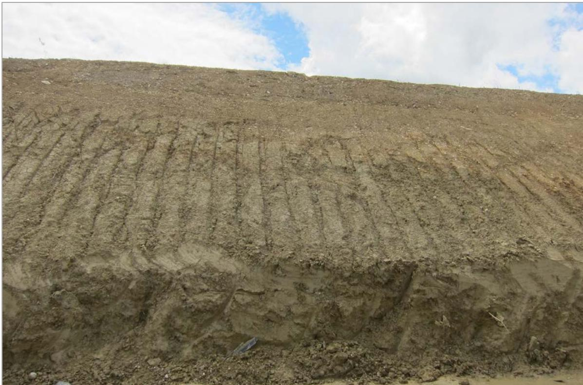
Abb. 2.1.1.28: Hanganschnitt an der A8 südlich von Wallner (Ried im Innkreis): Terrassenkiese taschenartig eingelagert in Ried-Formation im Liegenden (Foto: M. Peresson).
