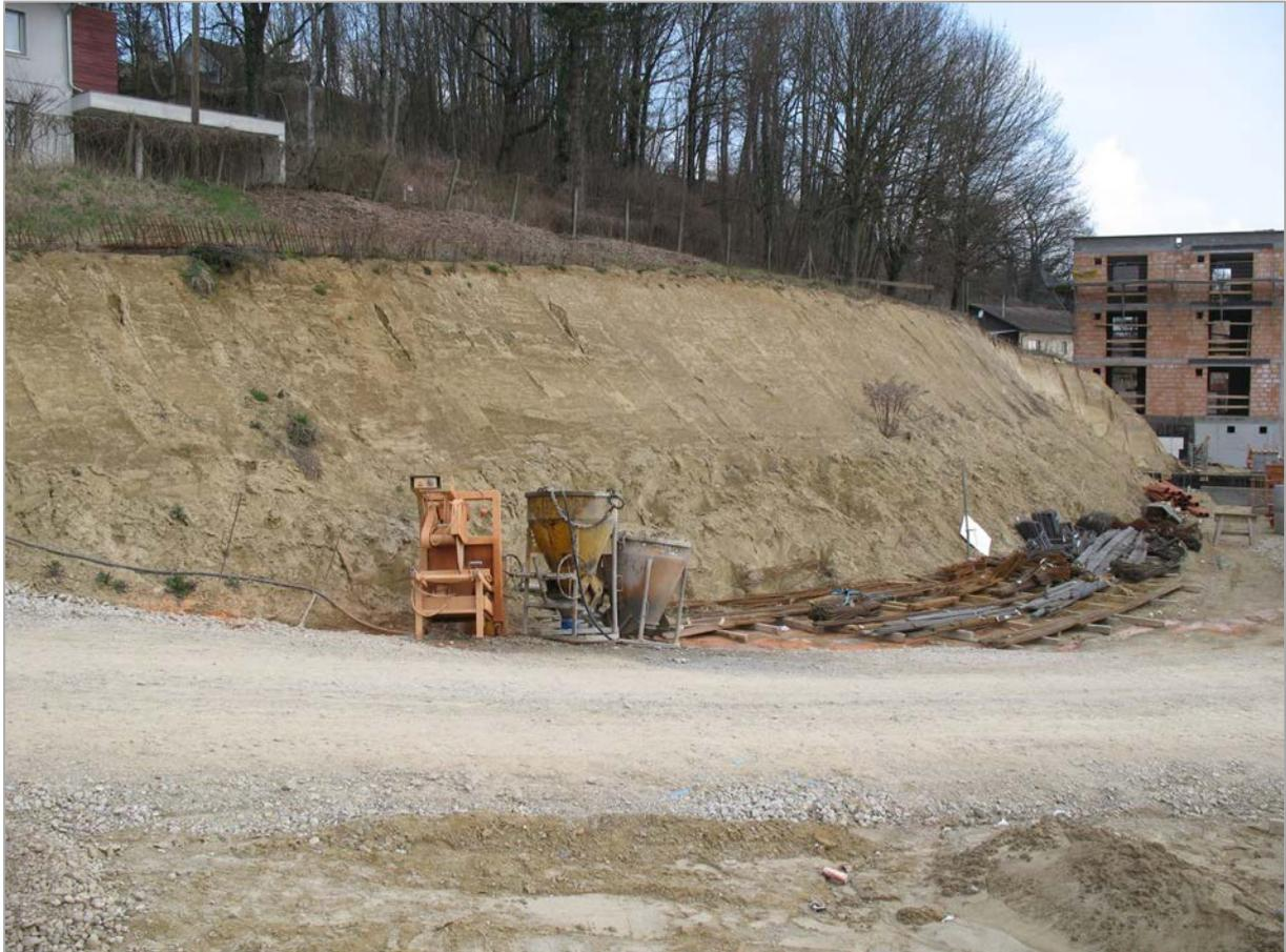
Abb. 2.2.1.9: Westlicher Bereich der Baugrube in Leonding, Cranachstraße; unstrukturierter, gelblicher Löss (Foto: Ch. Rupp).
