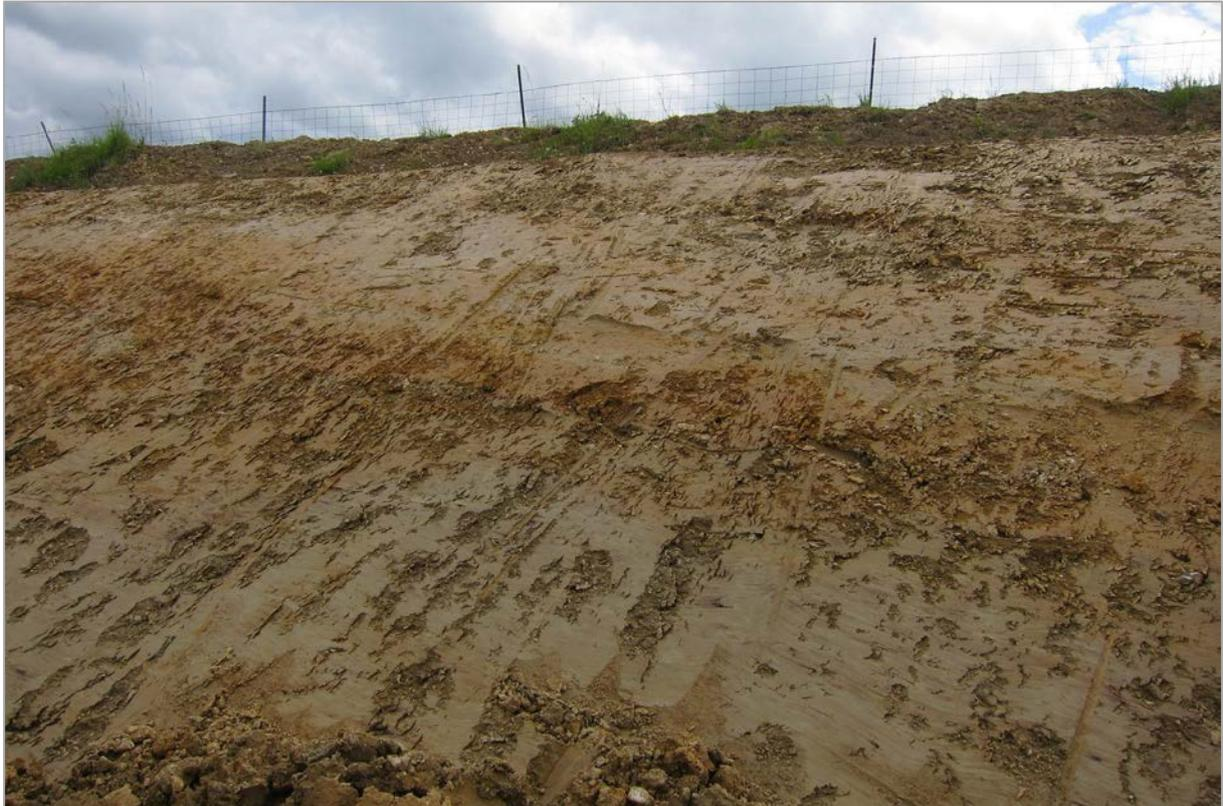
Abb. 2.1.1.40: Hanganschnitt an der A8 südöstlich der Ortschaft Wallner; schluffig, tonige Matrix mit rötlichen Kieseinschaltungen (Foto: M. Peresson).
