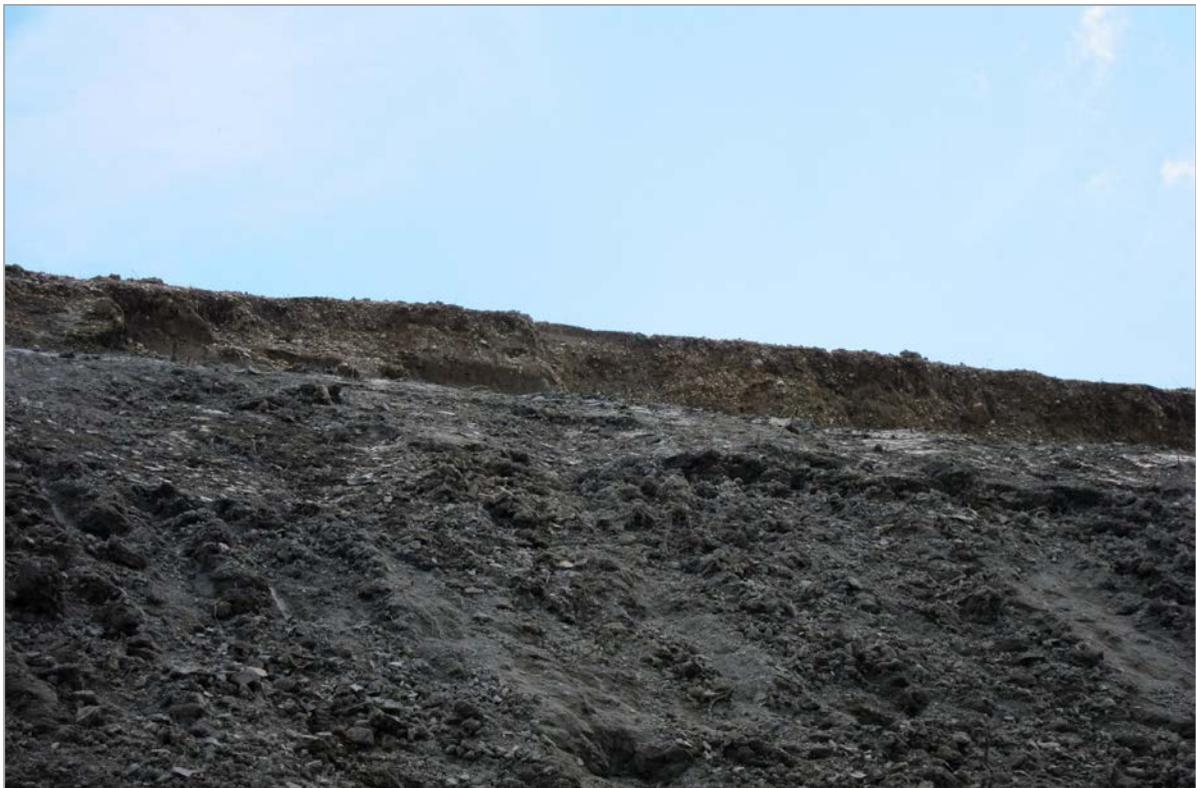
Abb. 2.1.1.52: Hanganschnitt an der A8 im Bereich der Gemeinde Rabenberg; Terrassenkiese am Top der Ried-Formation (Foto: M. Peresson).
