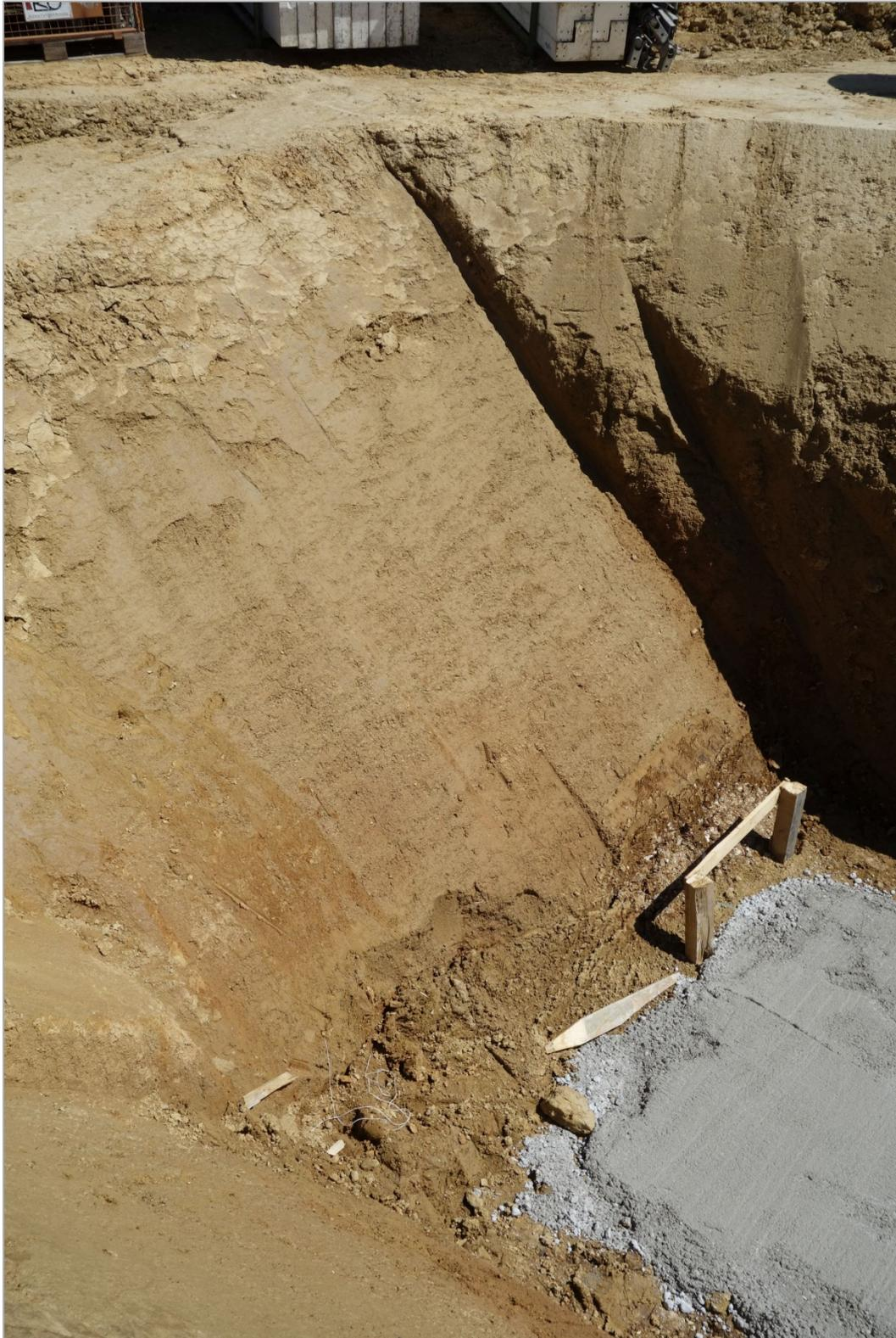
Abb. 2.3.1.11: Baugrube in Dietach: Gelbbrauner Lösslehm mit Kieseinschlüssen; unterlagert von undeutlich ausgebildetem rötlichem Paläoboden mit Kieseinlagerungen und hellen „Älteren Deckenschottern“ an der Basis (H. Peresson).
