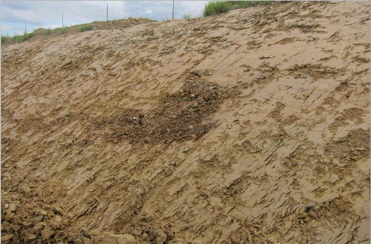
Abb. 2.1.1.42: Hanganschnitt an der A8 südöstlich der Ortschaft Wallner; schluffig, tonige Deckschicht mit „Kiesnestern“ (Foto: M. Peresson).
