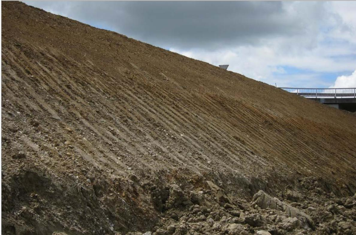
Abb. 2.1.1.30: Hanganschnitt an der A8 südlich von Wallner (Ried im Innkreis): Gesamter Hanganschnitt besteht aus altpleistozänen Terrassenkiesen (Foto: M. Peresson).
