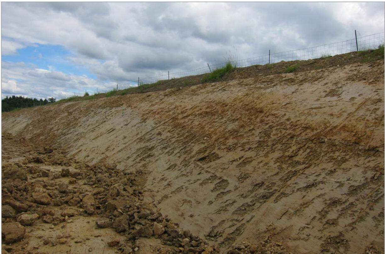
Abb. 2.1.1.41: Hanganschnitt an der A8 südöstlich der Ortschaft Wallner; schluffig, tonige Matrix mit rötlichen taschenartigen Kieseinschaltungen (Foto: M. Peresson).
