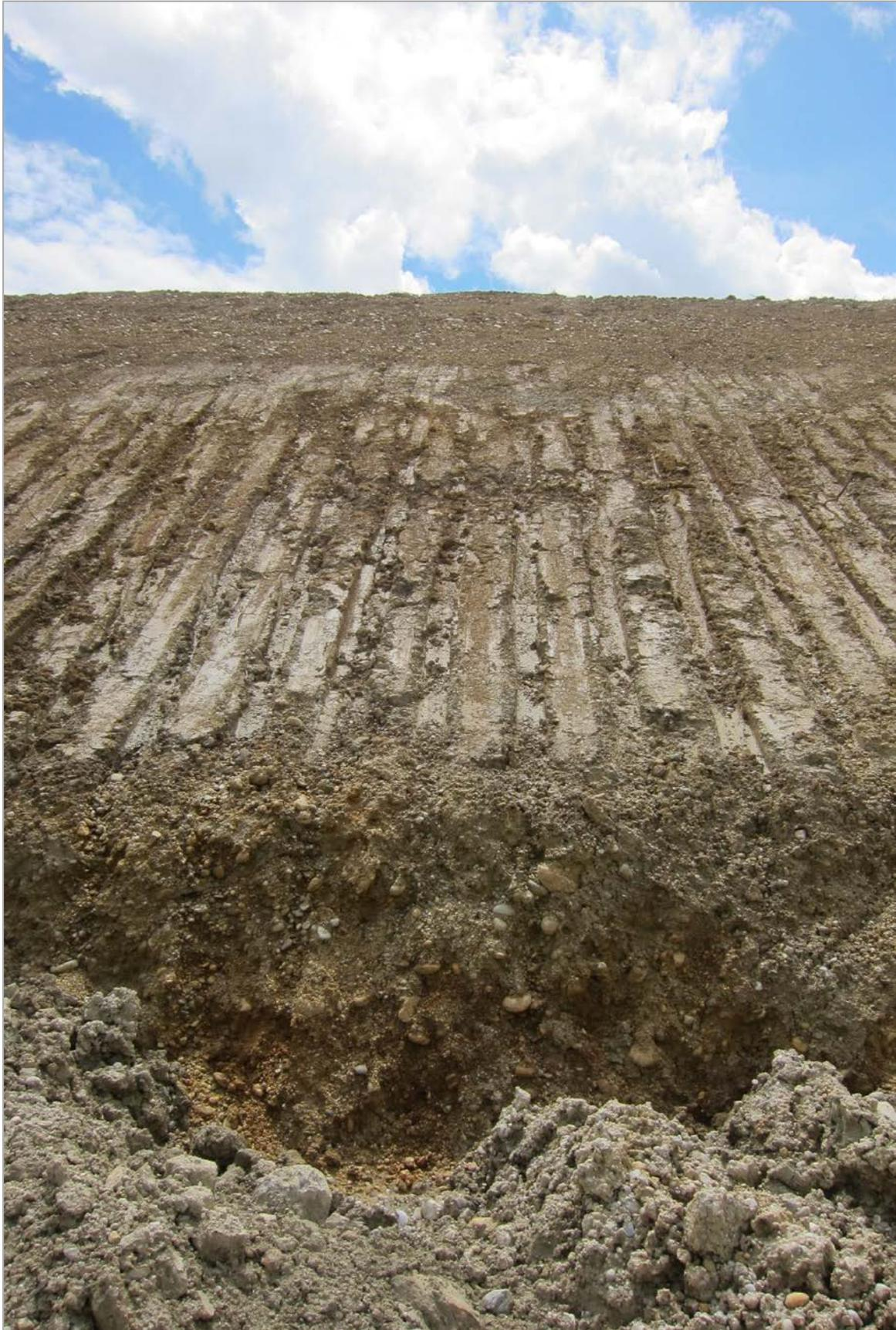
Abb. 2.1.1.32: Hanganschnitt an der A8 südlich von Wallner (Ried im Innkreis): Gesamter Hanganschnitt besteht aus altpleistozänen Terrassenkiesen (Foto: M. Peresson).
