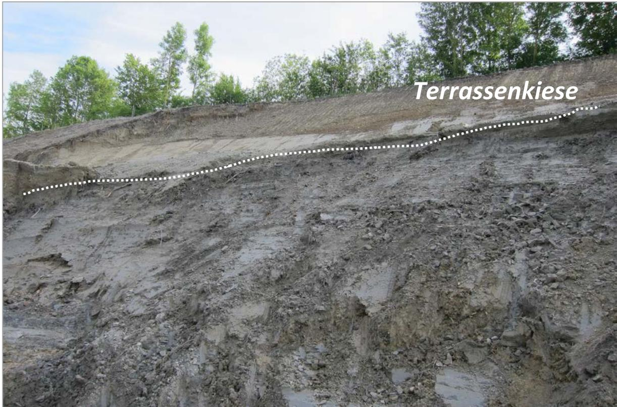
Abb. 2.1.1.73: Hanganschnitt an der A8 im Bereich der Ortschaft Pramwald; stark tektonisierte Ottnang-Formation; im Hangenden Terrassenkiese (Foto: M. Peresson).
