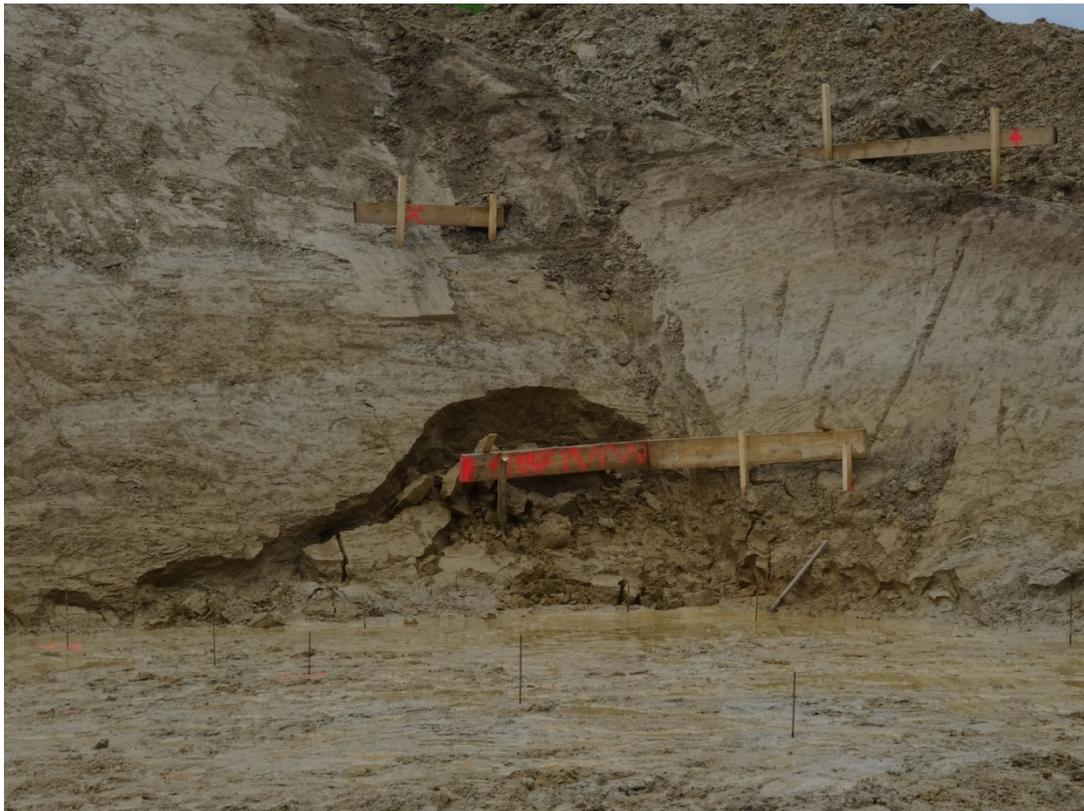
Abb. 2.1.2.7: Baugrube in Niederrottenheim: Sackungen innerhalb der quartäre Deckschichten; vergleytes Erscheinungsbild (Foto: M. Linner).
