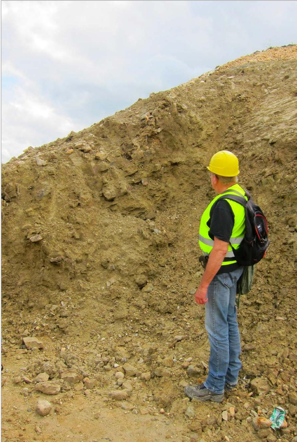
Abb. 2.1.1.22: Hanganschnitt an der A8 südwestlich Ried im Innkreis; gekippte Ried-Formation (Foto: M. Peresson).
