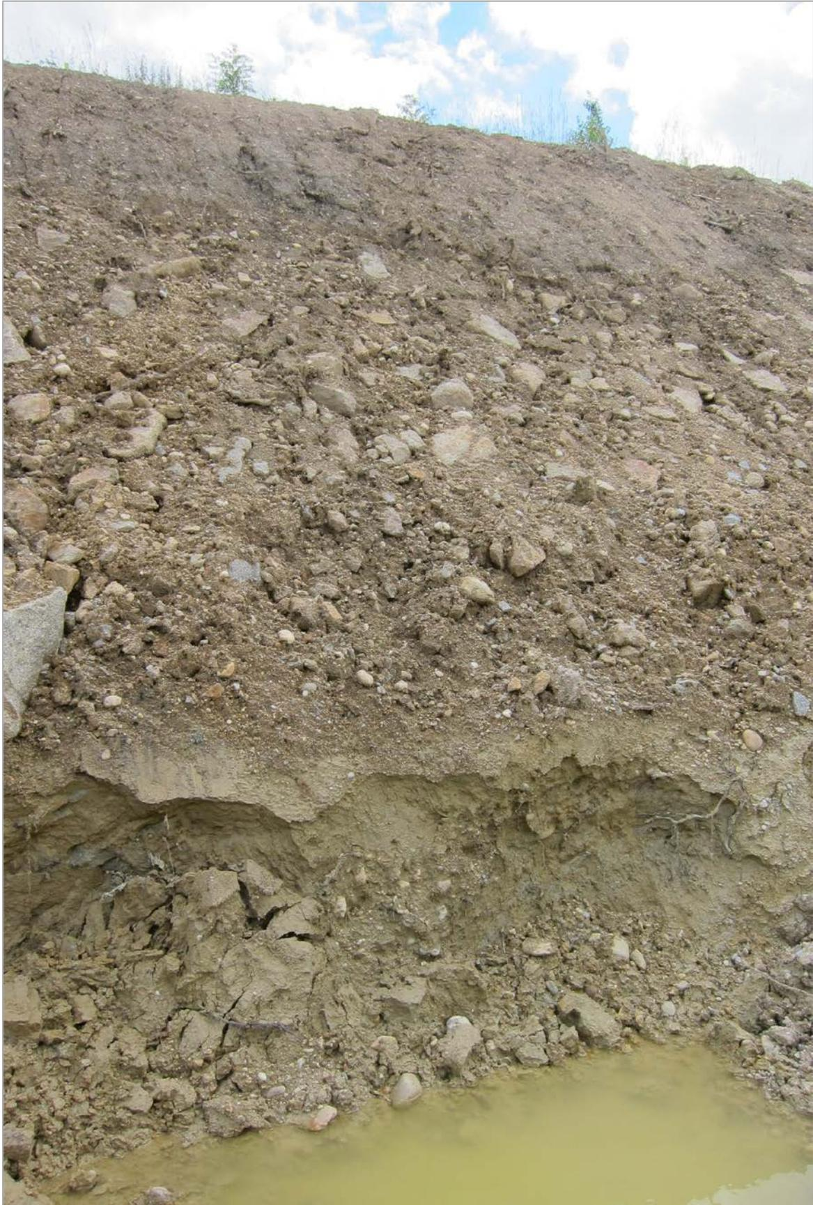
Abb. 2.1.1.33: Hanganschnitt an der A8 südlich von Wallner (Ried im Innkreis): im Hangenden Anschüttungsmaterial aus Blockwerk einer früheren Bauphase; im Liegenden Schluffe und Kiese (Foto: M. Peresson).
