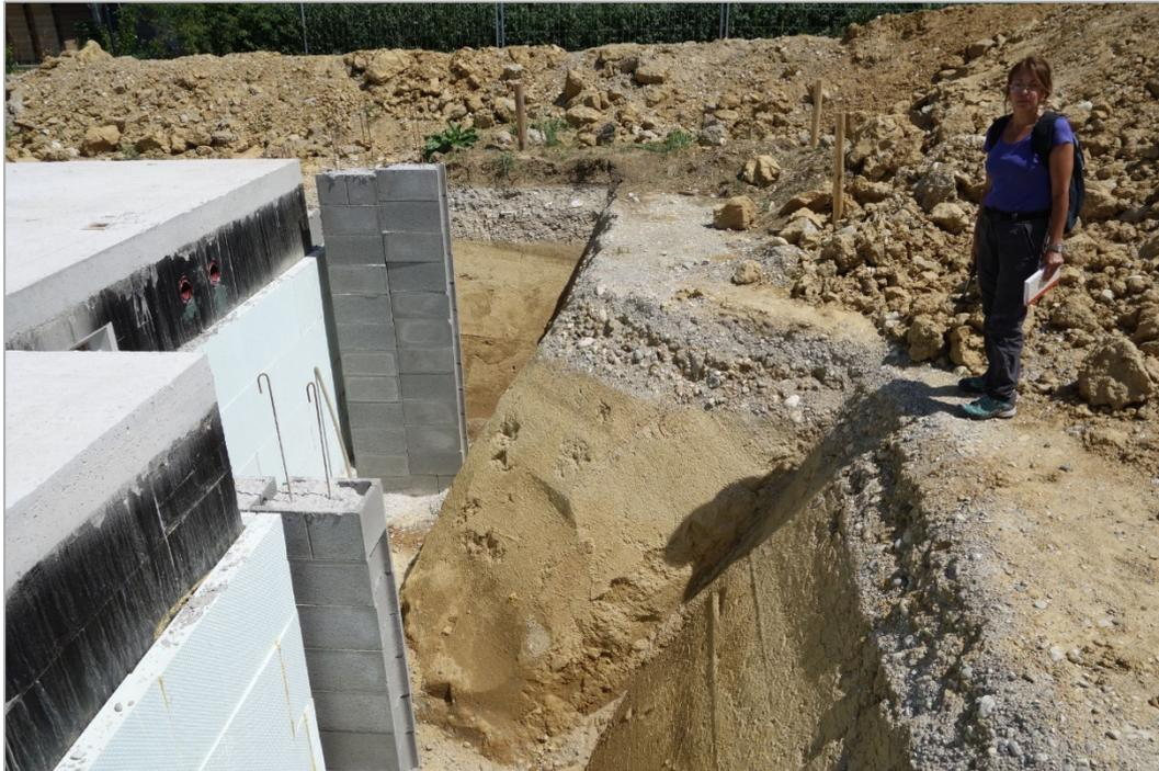
Abb. 2.3.2.12: Nordostwand der Baugrube in Wolfers: im Hangenden eine stark verfestigte Kieslage (Anschüttung); der liegende Abschnitt besteht aus gelblichen Löss-Lehm (Foto: H. Peresson).
