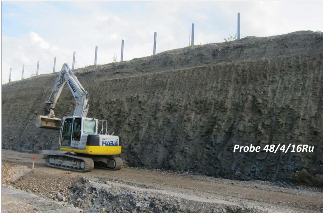
Abb. 2.1.1.68: Hanganschnitt an der A8 im Bereich der Ortschaft Forsthub; gebankte Silte der Ott nang-Formation mit Probenahmepunkt 48/4/16Ru (Foto: M. Peresson).
