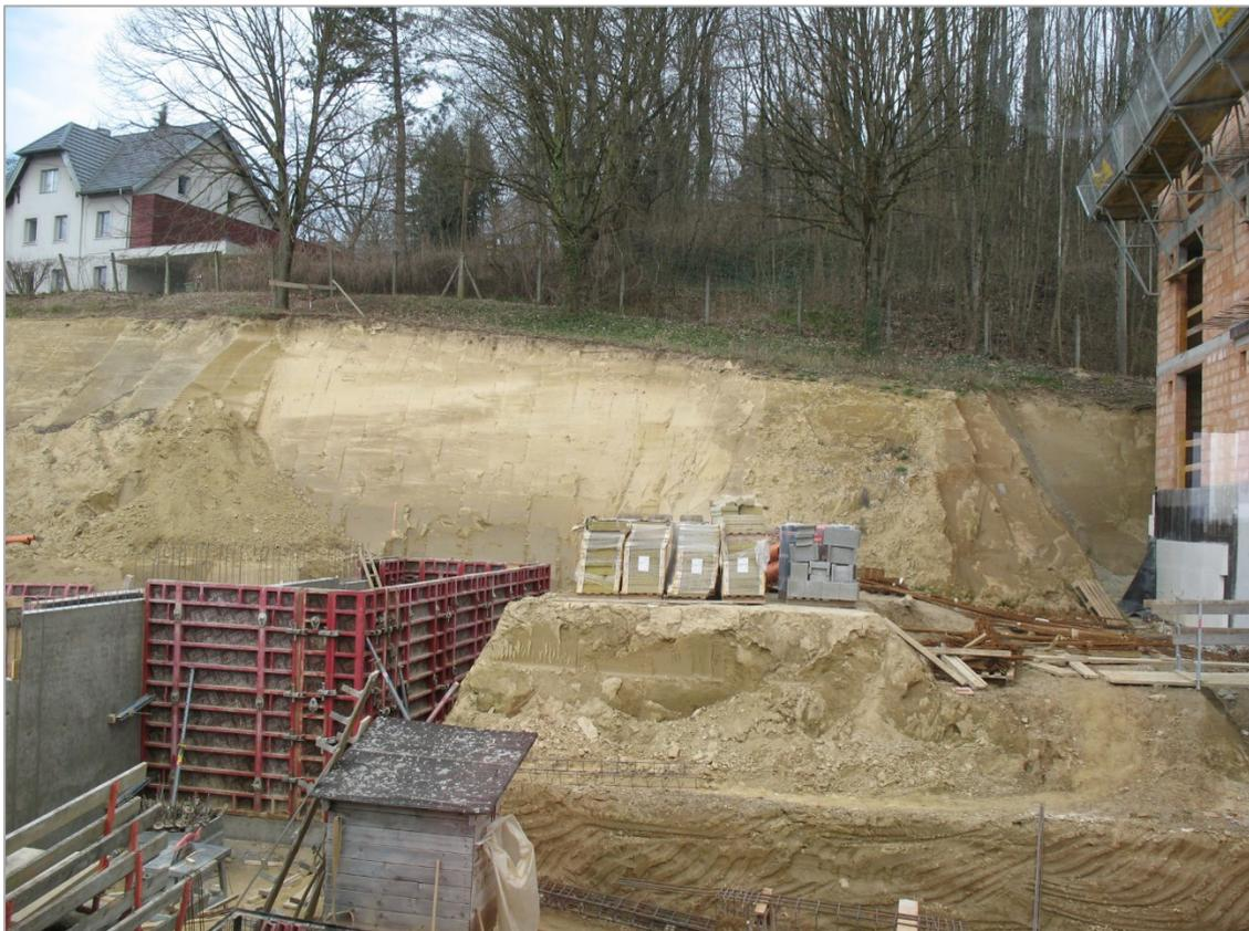
Abb. 2.2.1.6: Mittlerer Abschnitt der Baugrube in Leonding, Cranachstraße. Baugrube in gelblichbraunem, strukturlosen Löss (Foto: Ch. Rupp).
