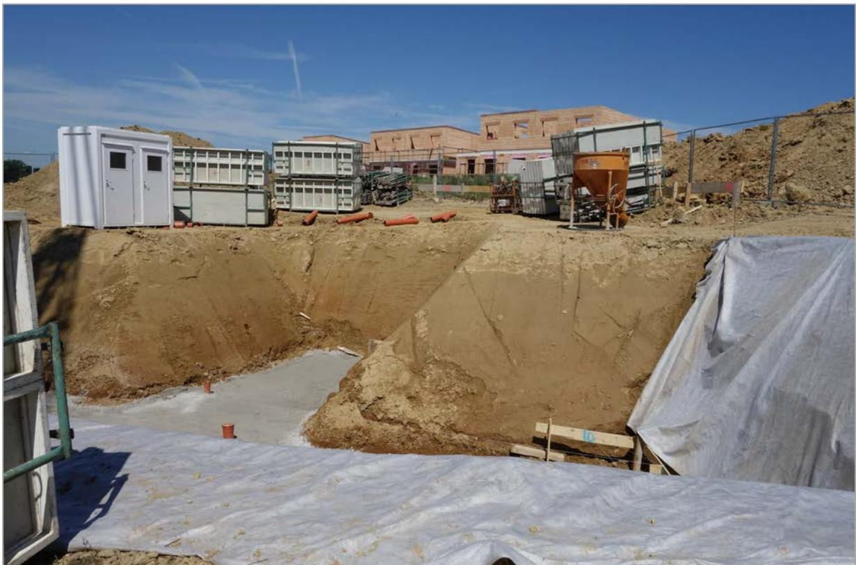
Abb. 2.3.1.9: Baugrube in Dietach: Im Hangenden gelbbrauner Löss-Lehm, unterlagert von rötlichem Paläoboden und Kiesen an der Basis (H. Peresson).
