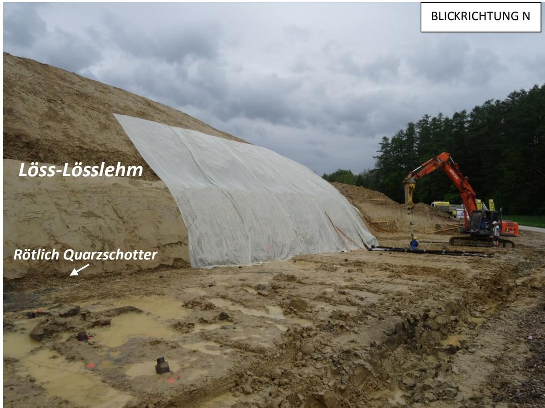
Abb. 2.1.2.6: Baugrube in Niederrottensheim: ockerfarbige quartäre Deckschichten im Hanganschnitt (Foto: M. Linner).
