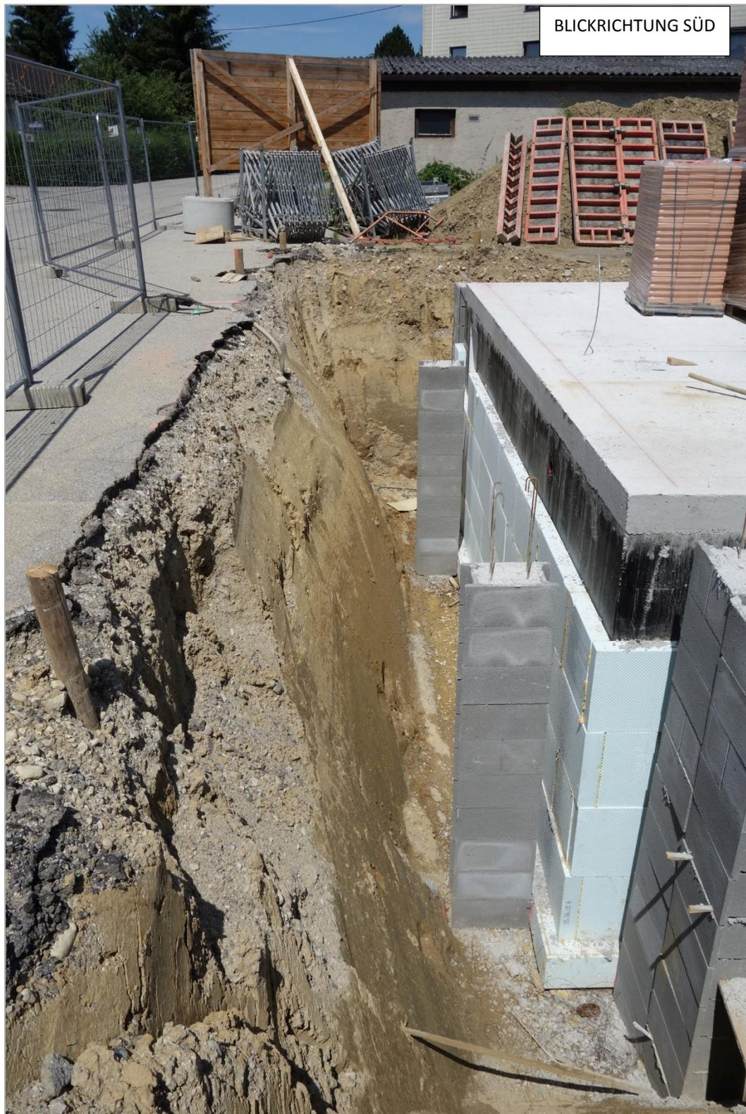
Abb. 2.3.2.9: Blickrichtung Süd in der Baugrube in Wolfers: stark verwitterte sandige Schluffe (Deckschichten, Löss-Lehm) im Liegenden der Baugrube; im Hangenden verfestigte Kieslage (Anschüttung) (Foto: M. Peresson).
