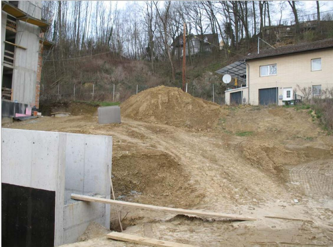
Abb. 2.2.1.5: Nordöstlicher Abschnitt der Baugrube in Leonding, Cranachstraße. Baugrube im Löss; im Hintergrund Paragneis-Steinbruch (Rohstoffabbaudatenbank Nummer 032/76; (Foto: Ch. Rupp).
