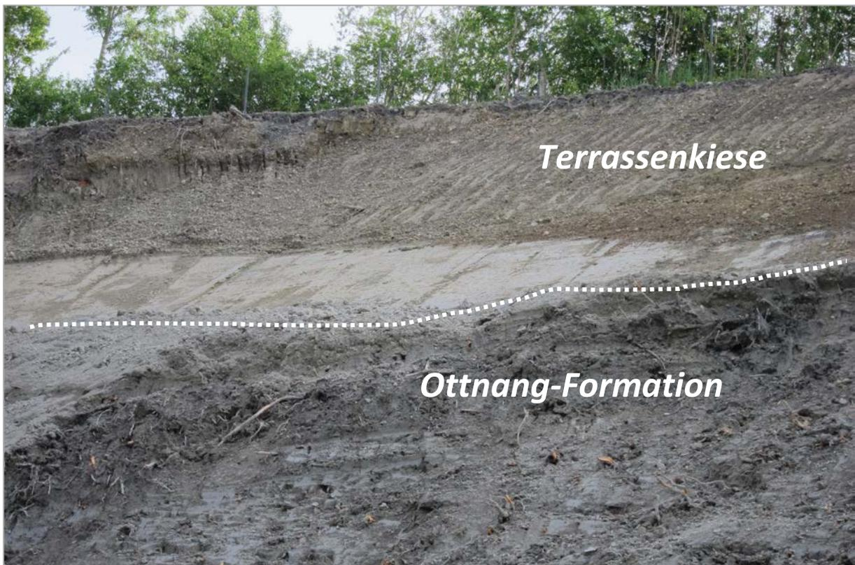
Abb. 2.1.1.74: Hanganschnitt an der A8 im Bereich der Ortschaft Pramwald; stark tektonisierte Ottnang-Formation; im Hangenden Terrassenkiese in schluffig, toniger Matrix (Foto: M. Peresson).
