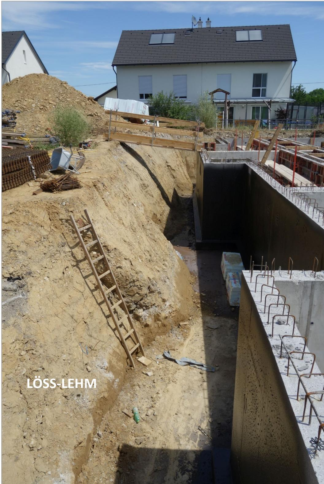
Abb. 2.3.2.15: Zweite Baugrube mit Kellerrohbau in Wolfen: An der Westseite nur gelbliche Deckschichten in Form von Löss-Lehm erkennbar; an der Südwand auch geringmächtige Anschüttung (Kieslage) im Hangenden aufgeschlossen (Foto: M. Peresson).
