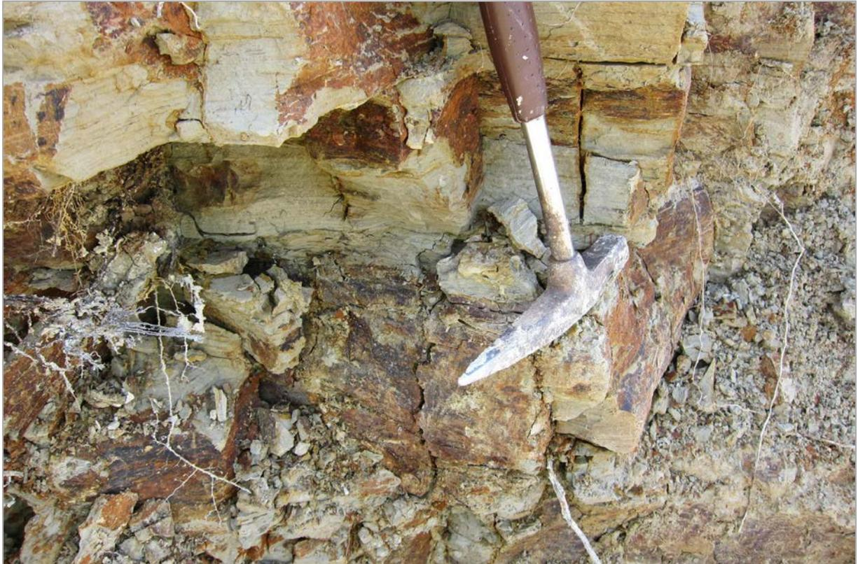
Abb. 2.1.1.49: Hanganschnitt an der A8 im Bereich der Gemeinde Rabenberg; stark tektonisierte, zerbrochene Ried-Formation (Foto: M. Peresson).
