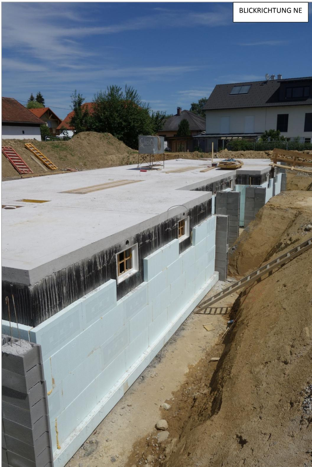
Abb. 2.3.2.8: Nordöstlicher Abschnitt der Baugrube Wolfern: stark verwitterte sandige Schluffe (Deckschichten, Löss-Lehm) dominieren in der Baugrube (Foto: M. Peresson).
