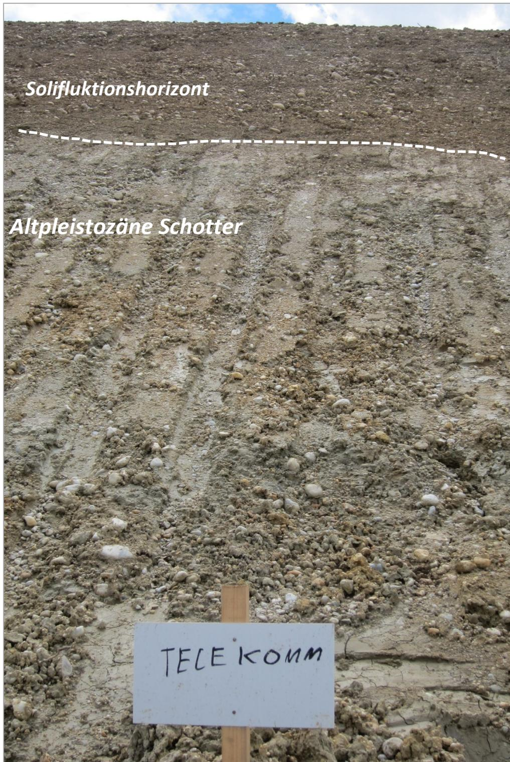
Abb. 2.1.1.29: Hanganschnitt an der A8 südlich von Wallner (Ried im Innkreis): Solifluktionshorizont im Hangenden; unterlagert von altpleistozänen Schottern (Foto: M. Peresson).
