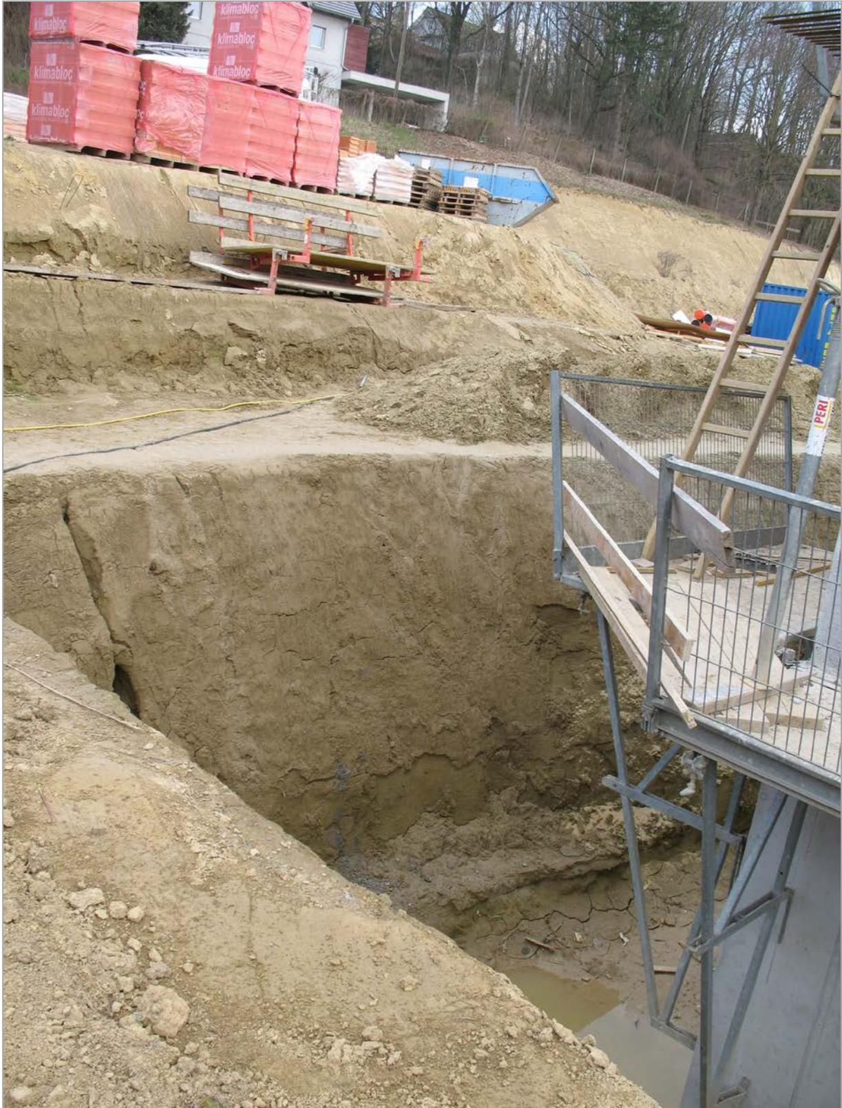
Abb. 2.2.1.8: Südlicher, tiefster Abschnitt der Baugrube in Leonding, Cranachstraße; unstrukturierter, gelblicher Löss (Foto: Ch. Rupp).
