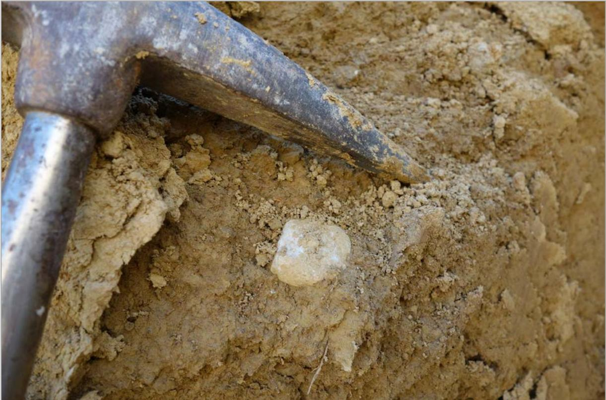
Abb. 2.3.1.12: Baugrube in Dietach: Kieseinschaltungen in Löss-Lehm (H. Peresson).
