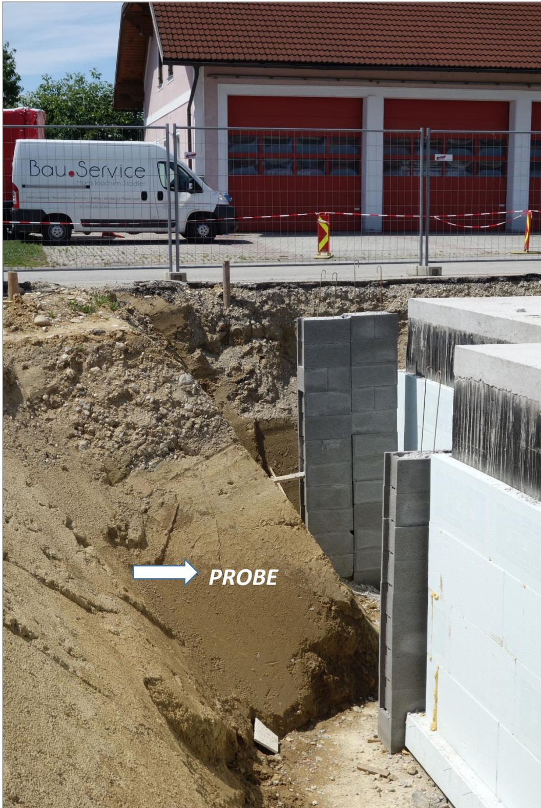
Abb. 2.3.2.10: Südostwand der Baugrube in Wolfers: im Hangenden eine stark verfestigte Kieslage (Anschüttung); der liegende Abschnitt besteht aus gelblichen Deckschichten (Löss-Lehm) (Foto: H. Peresson).
