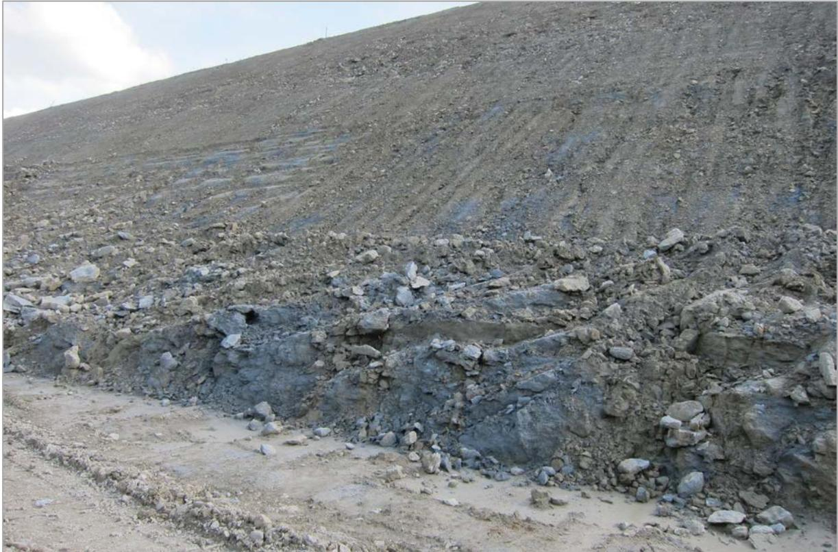
Abb. 2.1.1.66: Hanganschnitt an der A8 im Bereich der Ortschaft Forsthub; blaugraue sandige Silte der Otttang-Formation (Foto: M. Peresson).
