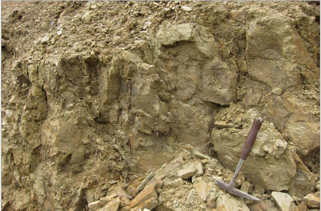
Abb. 2.1.1.9: Hanganschnitt an der A8 östlich der Anschlussstelle Ried im Innkreis; stark tektonisierte Ried-Formation; intern feingeschichtet (Foto: M. Peresson).
