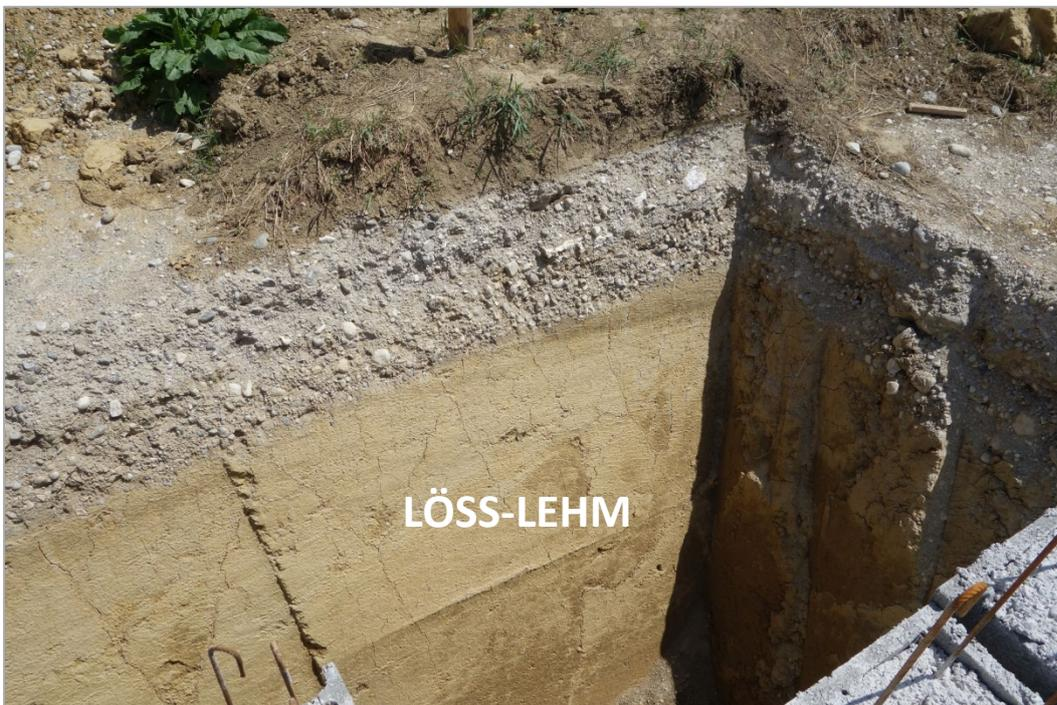
Abb. 2.3.2.13: Nordostwand der Baugrube in Wolfers; im Hangenden eine stark verfestigte Kieslage (Anschüttung); der liegende Abschnitt besteht aus gelblichen quartären Deckschichten (Löss-Lehm) (Foto: M. Peresson).
