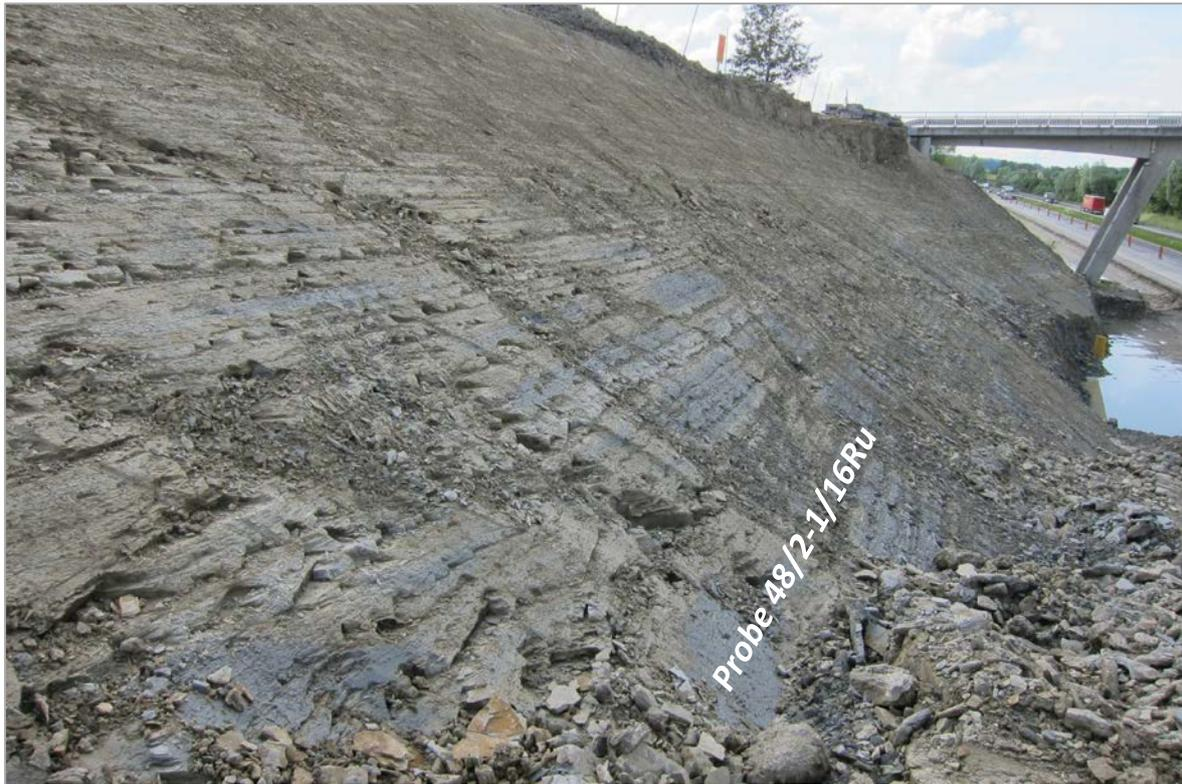
Abb. 2.1.1.59: Hanganschnitt an der A8 im Bereich der Ortschaft Unterprenning; blaugraue bis graue Ottngang-Formation; Rinnenbildung an der Schichtbasis erkennbar (Foto: M. Peresson).
