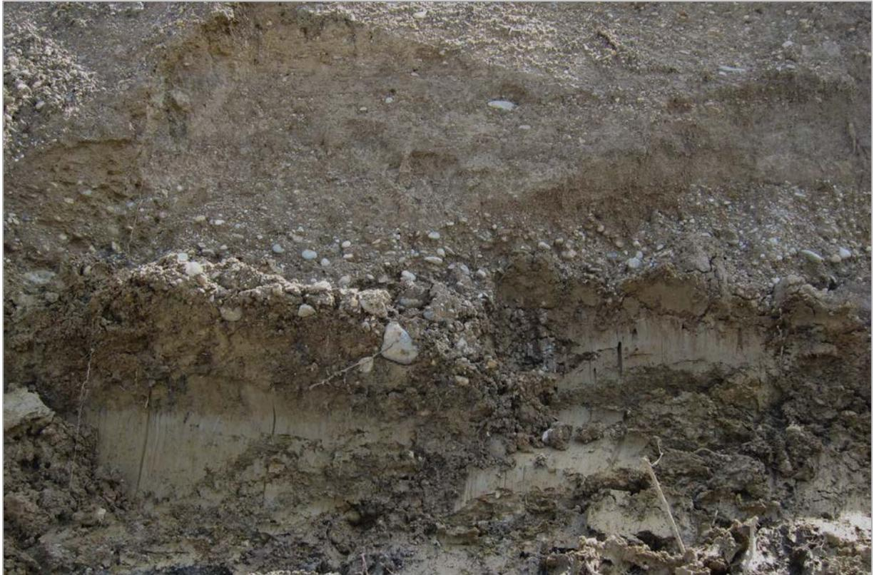
Abb. 2.1.1.53: Hanganschnitt an der A8 im Bereich der Gemeinde Rabenberg; lagenweise eingeschaltete, gradierte Terrassenkiese in schluffig toniger Matrix (Foto: M. Peresson).
