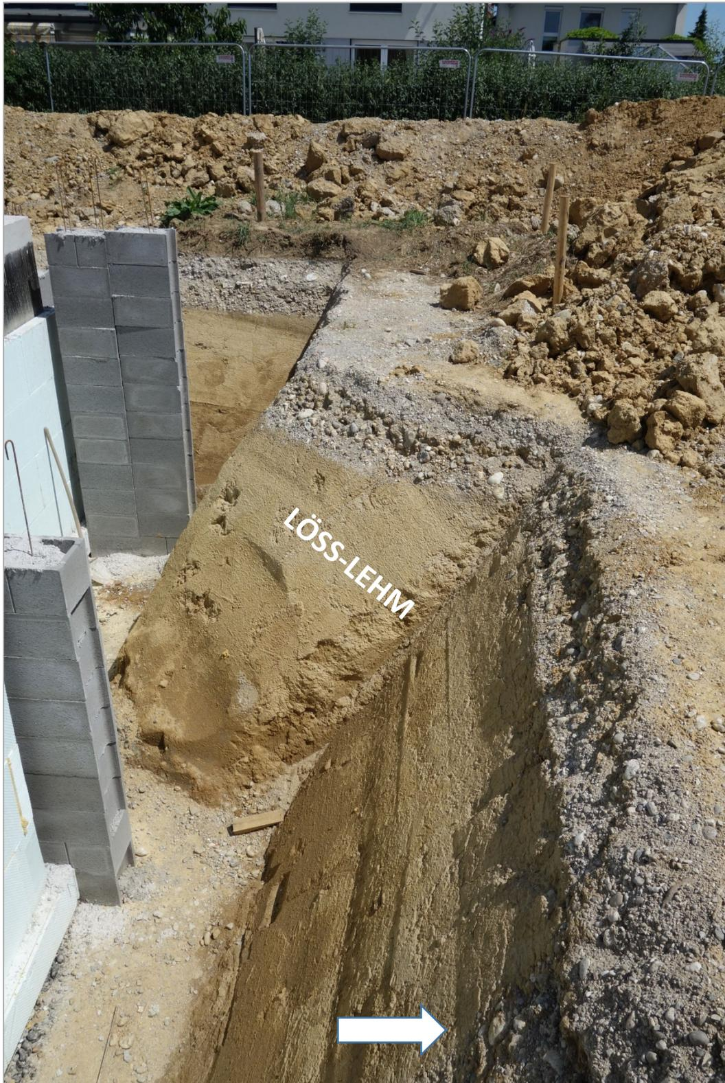
Abb. 2.3.2.11: Ostwand der Baugrube in Wolferrn: im Hangenden eine stark verfestigte Kieslage (Anschüttung); im Vordergrund taschenartige Kiesauffüllung siehe Pfeil; der liegende Abschnitt besteht aus gelblichen Löss-Lehm (Foto: M. Peresson).
