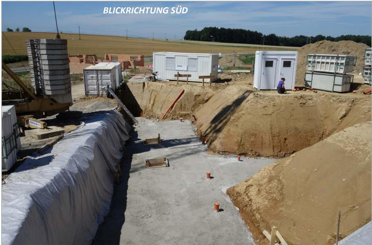
Abb. 2.3.1.10: Baugrube in Dietach: Im Hangenden gelbbrauner Löss-Lehm, unterlagert von rötlichem, kryoturbaten Paläoboden und Kiesen an der Basis (H. Peresson).
