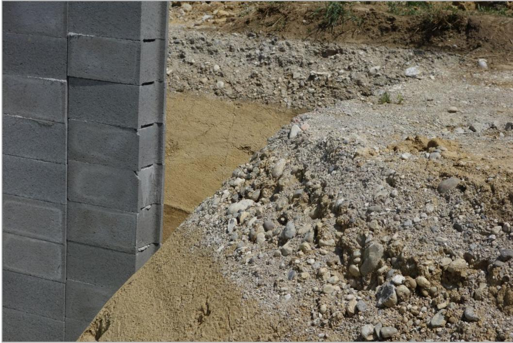
Abb. 2.3.2.14: Detailaufnahme der stark verfestigten Kieslage in der Baugrube in Wolfern (Foto: M. Peresson).
