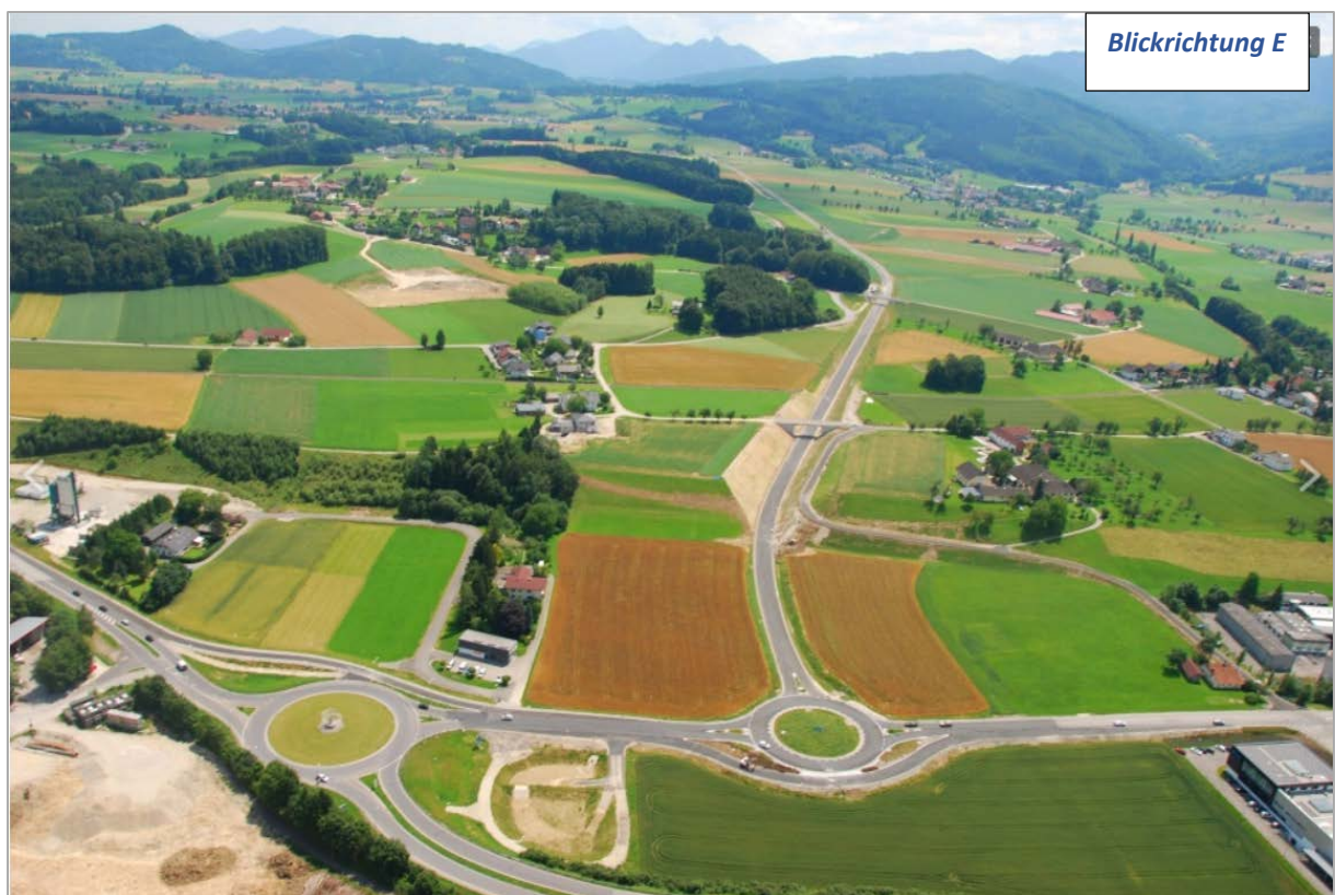
Abb. 2.2.1.2: Links= bestehende 3-armige Kreisverkehrsanlage im Kreuzungsbereich B144/B120a; rechts= neuer 3-armiger Kreisverkehr (entnommen aus salzi.at)
