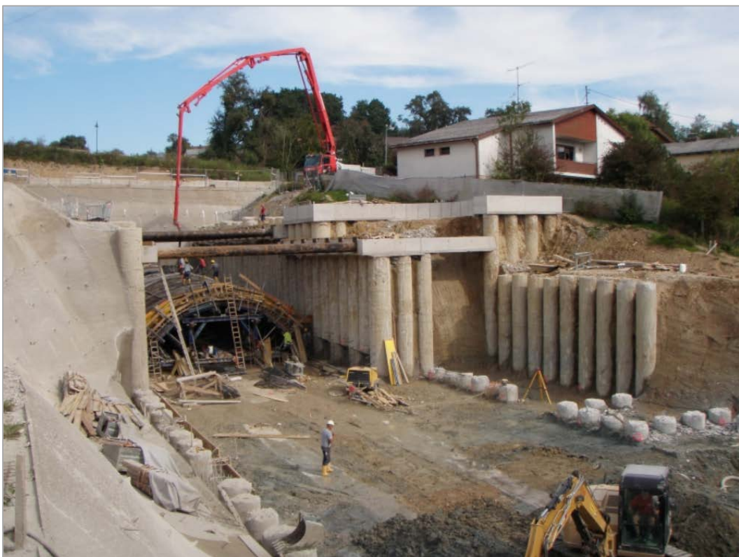
Abb. 2.1.2.28: Baufortschritt im Tunnelportal West (aus www.kellergrundbau.at ).
