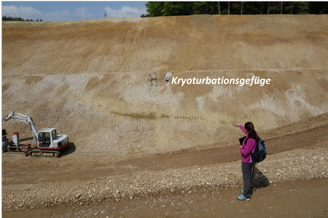
Abb. 2.1.2.36: Umfahrung Lambach-Nord- Aufschlusspunkt 3, Tunnelportal Ost: Kryoturbationsgefüge in den „Älteren Deckenschottern“ (Foto: H. Peresson).
