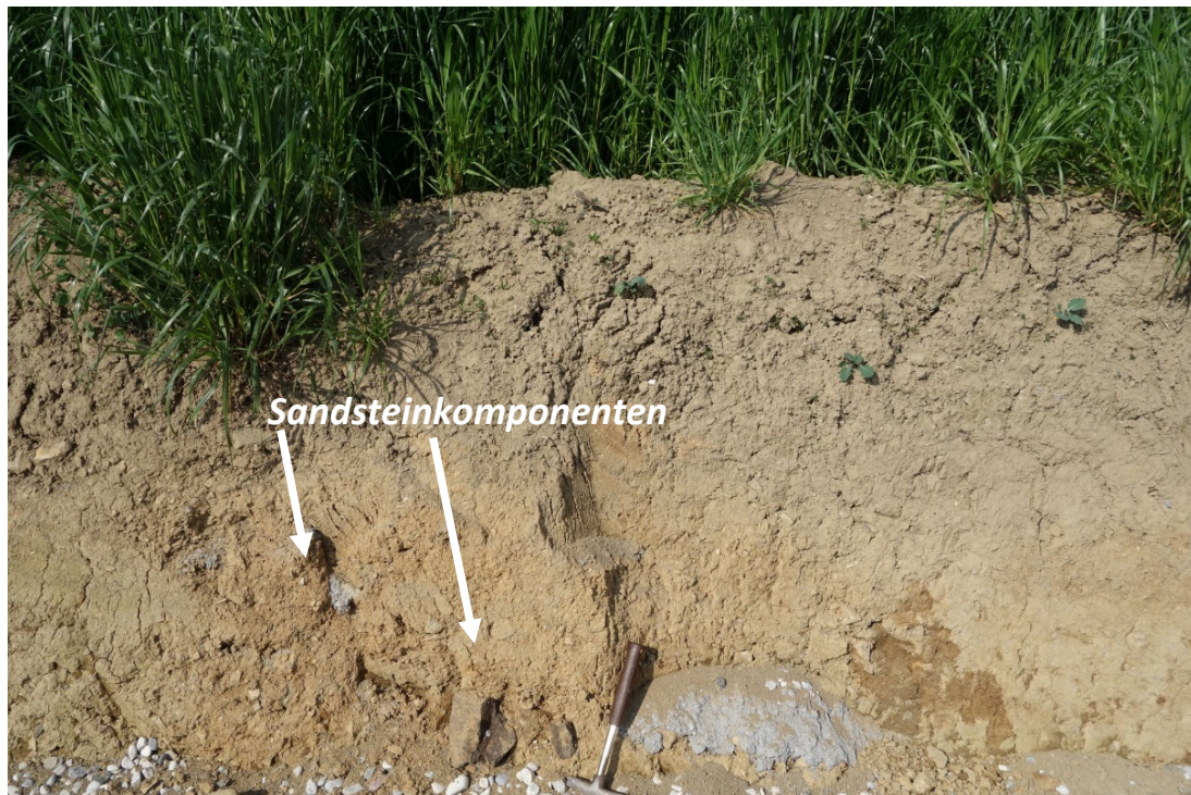
Abb. 2.2.1.25: Umfahrung Gmunden-Ost, Aufschlusspunkt 3, Überführung Steig: rotbraune Schluffe mit Sandsteinkomponenten; aufgenommen Mai 2014 (Foto: M. Peresson).
