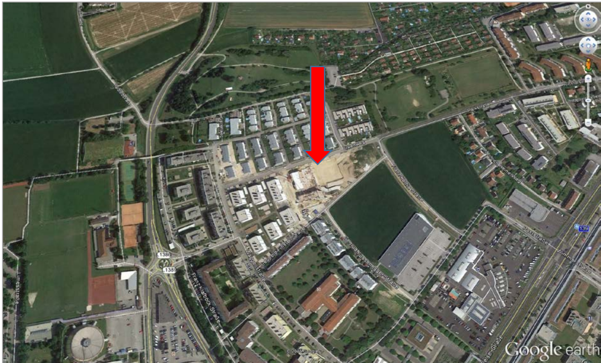
Abb. 2.1.4.11: Luftbildaufnahme der Baustelle (roter Pfeil) in Leonding ( www.google-earth , 7.5.2015).
