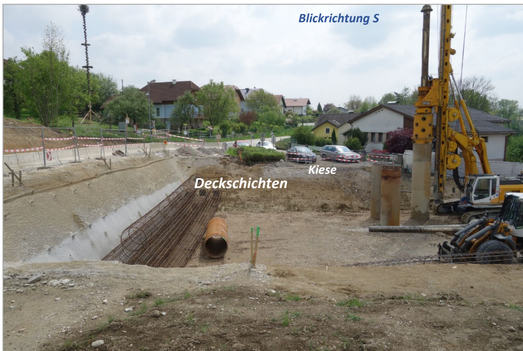
Abb. 2.1.2.22: Umfahrung Lambach-Nord- Aufschlusspunkt 2, Tunnelportal West: Einblick in die S-Wand unterhalb des Hanganschnitt an der Bundesstraße mit Deckschichten im Hangenden; an der Basis vermutete Vöckla-Formation (Foto: H. Peresson).
