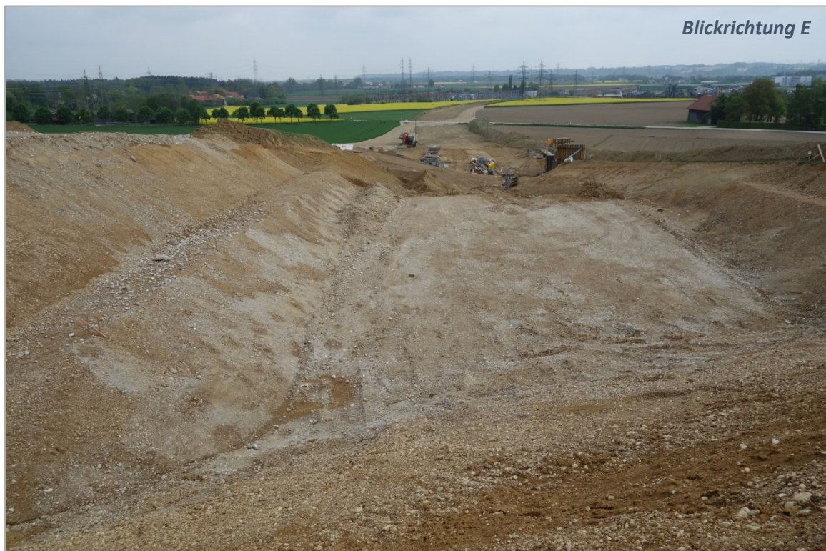
Abb. 2.1.2.9: Umfahrung Lambach-Nord- Aufschlusspunkt 1 im Bereich Breitenberg (Überführung Schlinkerleitenstraße): Knapp 7 m mächtige „Ältere Deckenschotter“ am Top des Hanganschnittes (Foto: H. Peresson).
