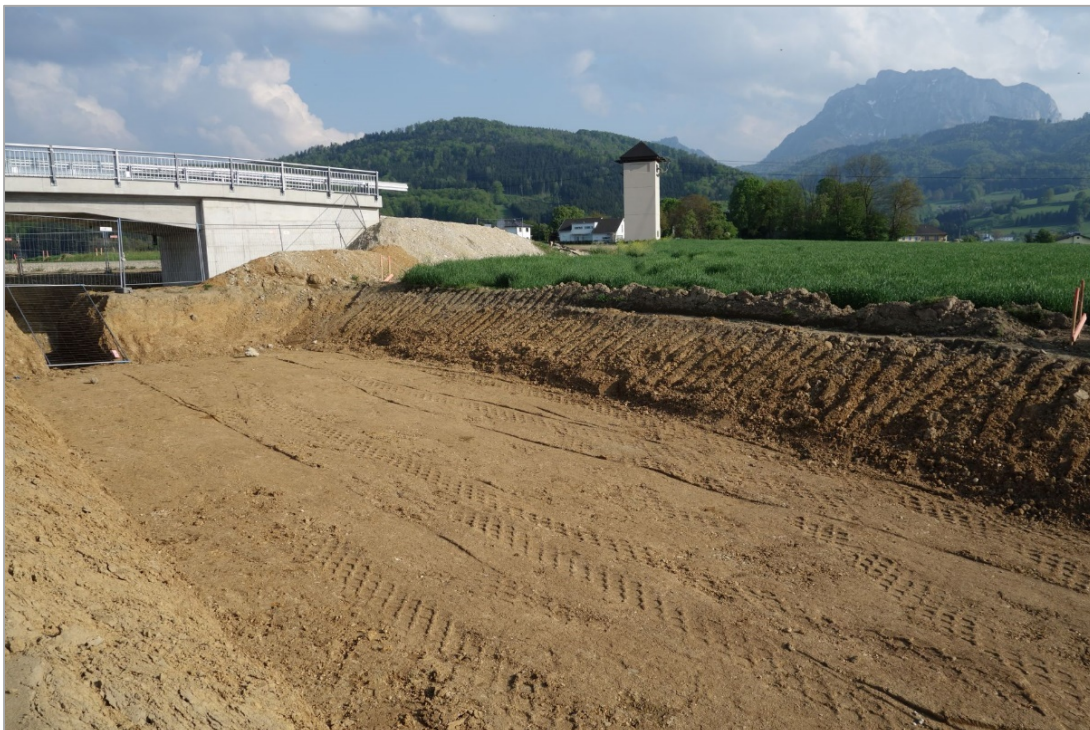
Abb. 2.2.1.27: Umfahrung Gmunden-Ost, Aufschlusspunkt 4, Überführung Steinbichl: rotbraune Schluffe und Sande mit Geröllkomponenten; aufgenommen Mai 2014 (Foto: M. Peresson).
