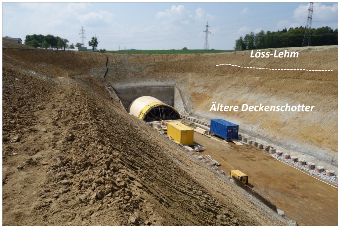
Abb. 2.1.2.32: Umfahrung Lambach-Nord- Aufschlusspunkt 3, Tunnelportal Ost: 22 m mächtige „Ältere Deckenschotter“ überlagert von Löss-Lehm (Foto: H. Peresson).
