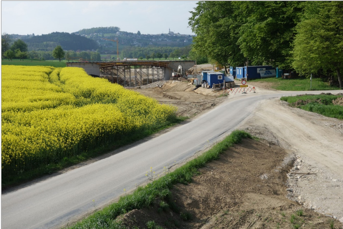
Abb. 2.2.1.24: Umfahrung Gmunden-Ost, Aufschlusspunkt 3, Überführung Steig: Überblicksaufnahme der Umfahungstrasse; aufgenommen Mai 2014 (Foto: M. Peresson).
