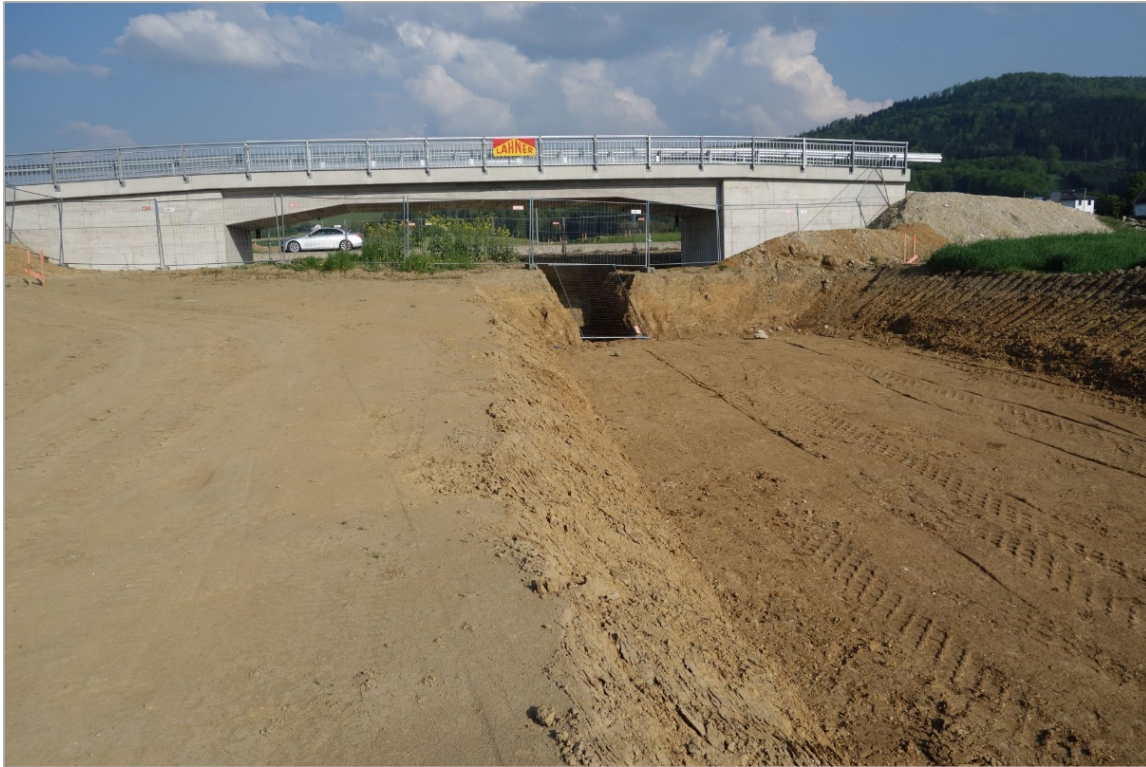
Abb. 2.2.1.28: Umfahrung Gmunden-Ost, Aufschlusspunkt 4, Überführung Steinbichl: rotbraune Schluffe und Sande mit Kieskomponenten; aufgenommen Mai 2014 (Foto: M. Peresson).
