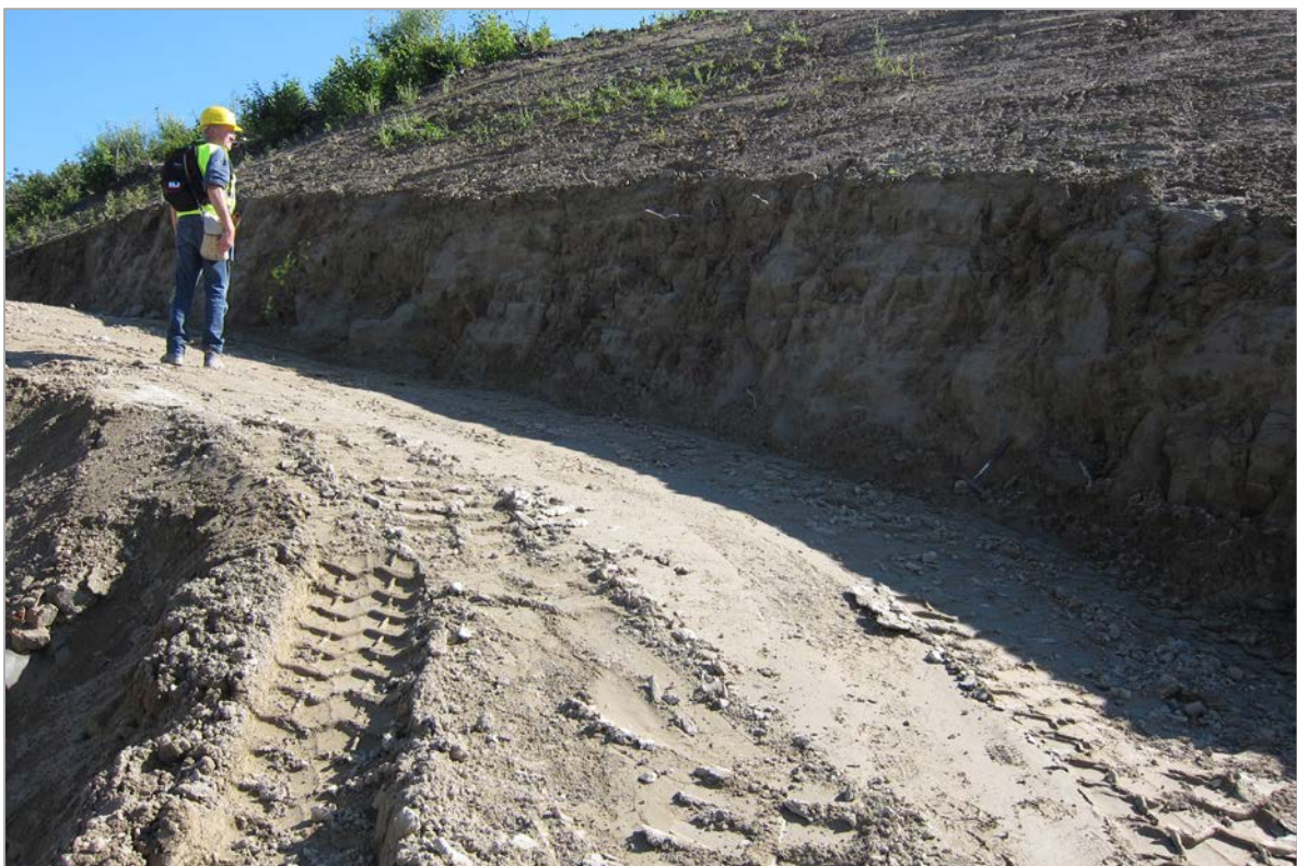
Abb. 2.1.1.32: Hanganschnitt an der A8 bei Buch: Rhythmisch gebankte Ottnang-Formation (Foto: M. Peresson).
