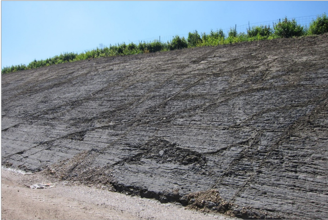
Abb. 2.1.1.11: Hanganschnitt an der A8 nördlich von Haag am Hausruck: Dunkelgraue, rhythmisch gebankte Ottnang-Formation mit NE-einfallenden Störungsflächen („Setzungsklüfte“) im gesamten Aufschlussbereich (Foto: M. Peresson).
