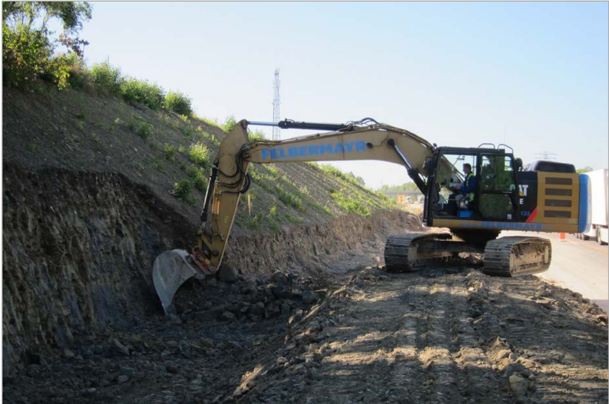
Abb. 2.1.1.34: Hanganschnitt an der A8 bei der Anschlussstelle Weibern: Rhythmisch gebankte Otttang-Formation (Foto: M. Peresson).
