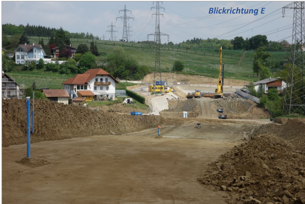
Abb. 2.1.2.27: Umfahrung Lambach-Nord- Aufschlusspunkt 2, Tunnelportal West: Mächtige Deckschichten (Löss-Lehme) entlang der Tunneltrasse Richtung Schwaigerbrücke (Foto: H. Peresson).
