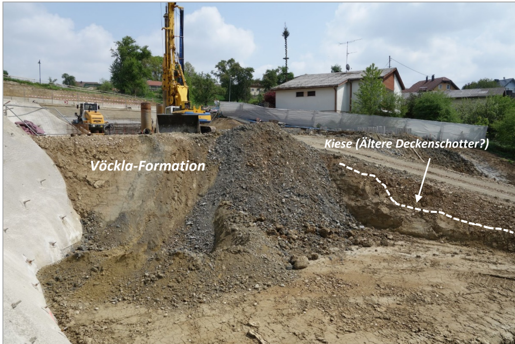
Abb. 2.1.2.25: Umfahrung Lambach-Nord- Aufschlusspunkt 2, Tunnelportal West: Baugrube in der zweiten Geländestufe mit „Älteren Deckenschottern“ an den Seitenwänden und Vöckla-Formation im Zentrum des Fotos (Foto: H. Peresson).
