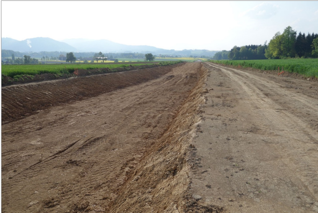
Abb. 2.2.1.26: Umfahrung Gmunden-Ost, Aufschlusspunkt 4, Überblick über das Gelände: rotbraune Schluffe und Sande mit Geröllkomponenten; aufgenommen Mai 2014 (Foto: M. Peresson).
