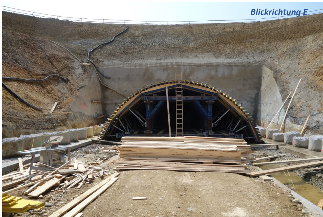
Abb. 2.1.2.46: Umfahrung Lambach-Nord- Aufschlusspunkt 3, Tunnelportal Ost: Deckelbauweise mit Bohrpfählen (Foto: H. Peresson).
