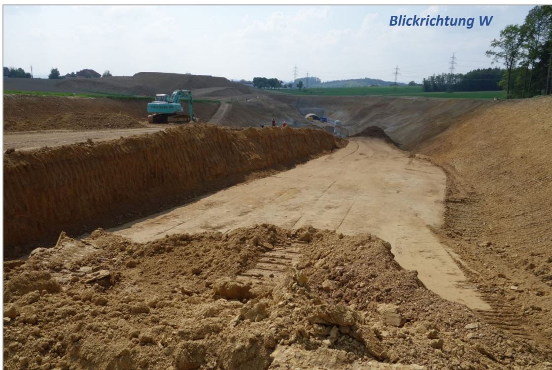
Abb. 2.1.2.47: Umfahrung Lambach-Nord- Aufschlusspunkt 3, Tunnelportal Ost: Mächtige Deckschichten (Löss-Lehme) im Hangenden der Trasse (Foto: H. Peresson).
