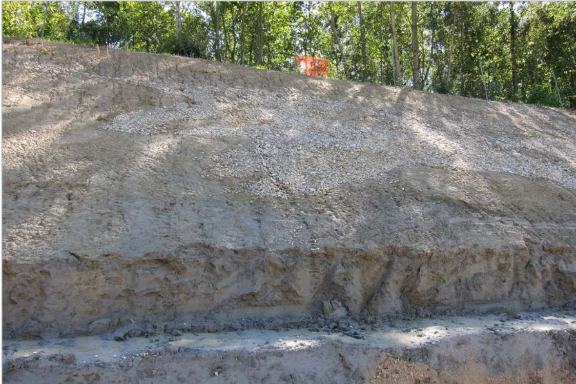
Abb. 2.1.1.24: Hanganschnitt an der A8 bei Niedernhaag: Fingerförmig auslaufende Kiesfazies unterlagert von Ottnang-Formation (Foto: M. Peresson).
