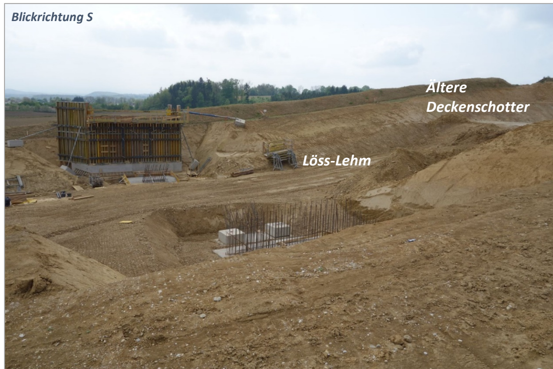
Abb. 2.1.2.8: Umfahrung Lambach-Nord- Aufschlusspunkt 1 im Bereich Breitenberg (Überführung Schlinkerleitenstraße): „Ältere Deckenschotter“ im Hintergrund; Löss-Lehm Bedeckung im Hangfussbereich des Brückenobjektes (Foto: H. Peresson).
