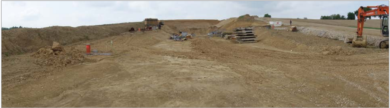
Abb. 2.1.2.6: Umfahrung Lambach-Nord- Aufschlusspunkt 1 im Bereich Breitenberg (Überführung Schlinkerleitenstraße): Überblicksfoto des Baustellengeländes mit mächtigen „Älteren Deckenschottern“ und „Löss-Lehm“ (Foto: H. Peresson).
