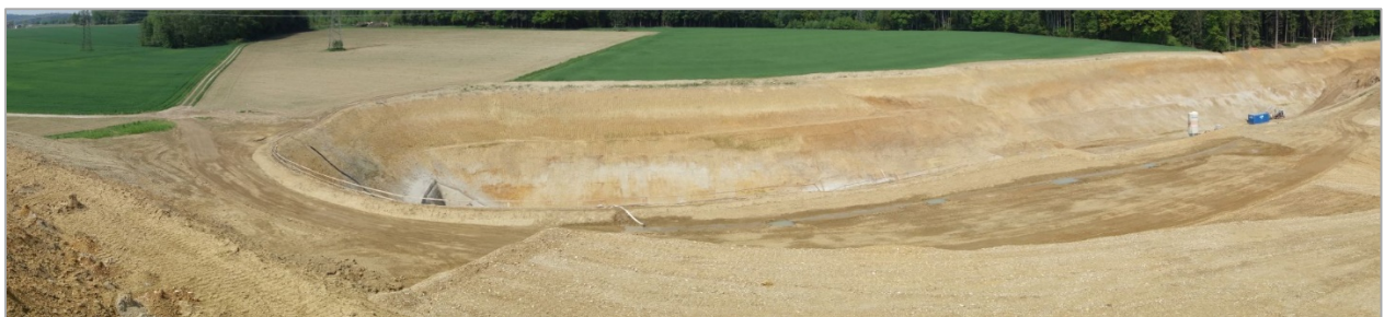
Abb. 2.1.2.30: Umfahrung Lambach-Nord, Aufschlusspunkt 3, Tunnelportal Ost: Überblicksfoto des Baustellengeländes (Foto: H. Peresson).
