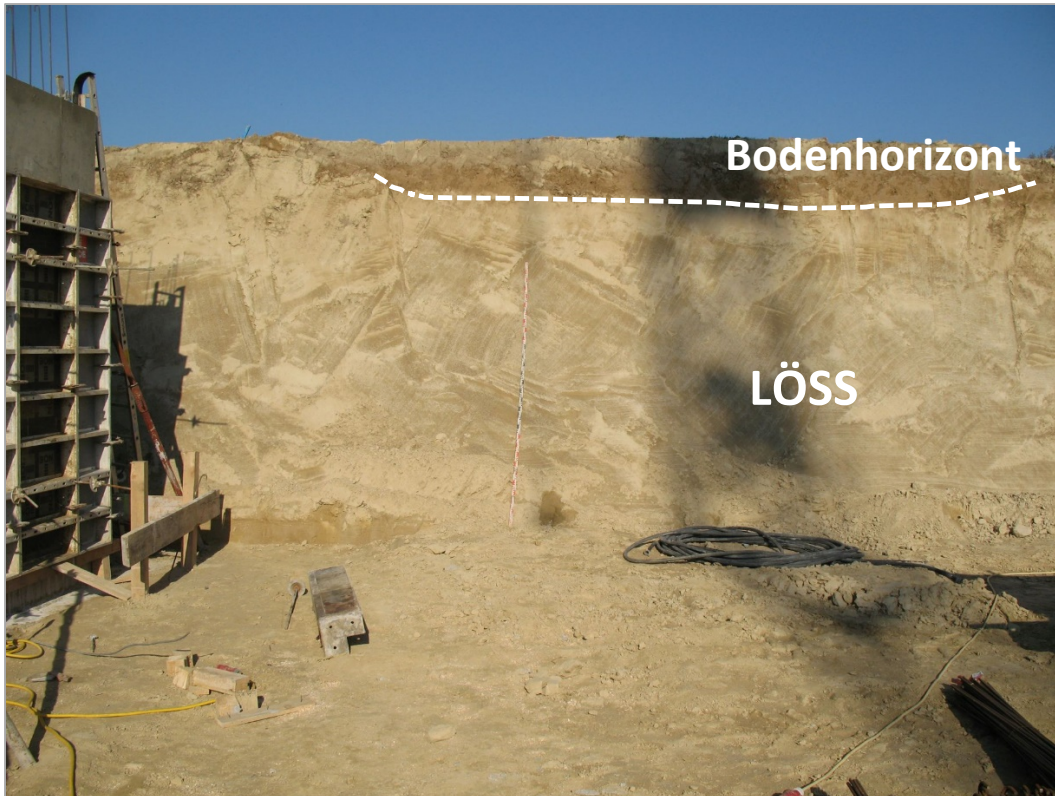
Abb. 2.1.4.7: Bauaushub im NW Bereich des Baustellengeländes in Leonding: 4 m Aufschlusswand im Löss; im Hangenden ist ein Bodenhorizont erkennbar (Foto Ch. Rupp).
