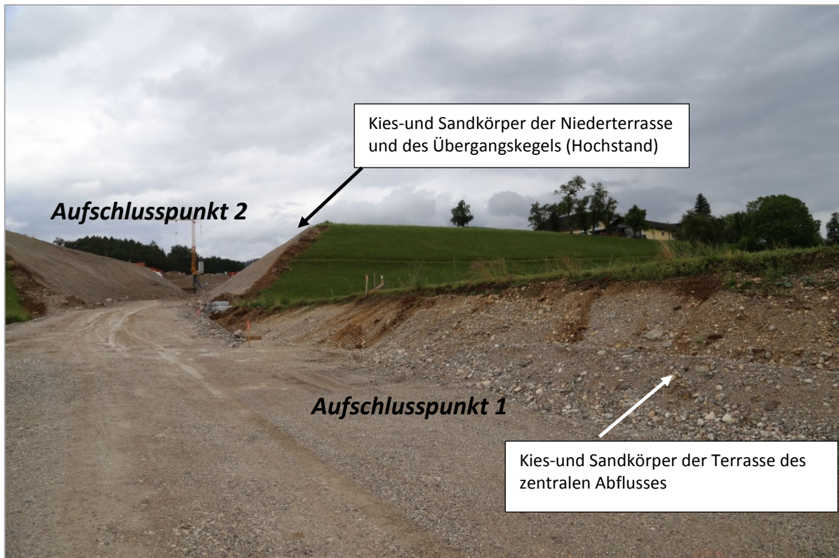
Abb. 2.2.1.11: Umfahrung Gmunden-Ost, Aufschlusspunkt 1: Kiese der Terrasse des zentralen Abflusses; aufgenommen Juni 2014 (Foto: I. Wimmer-Frey).
