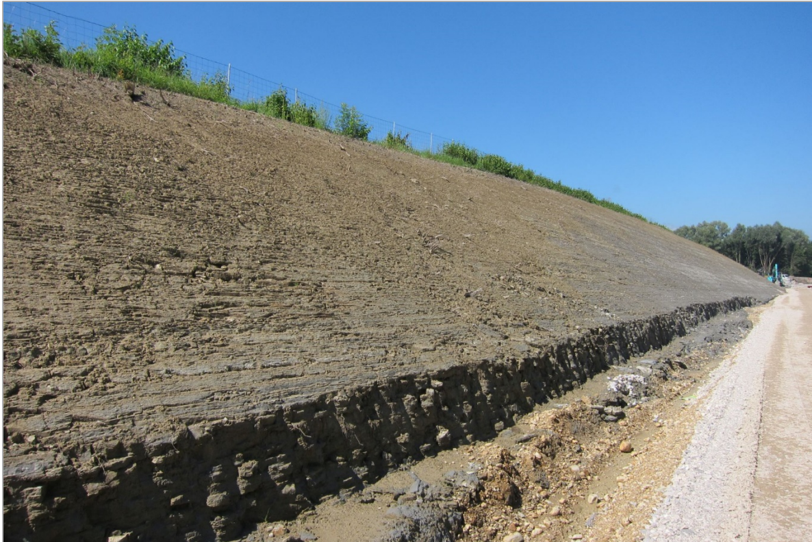
Abb. 2.1.1.8: Hanganschnitt an der A8 nördlich von Haag am Hausruck: Rhythmisch gebankte Ottnang-Formation mit abschnittsweise wechselnder Farbausbildung von grau zu braun (Foto: M. Peresson).
