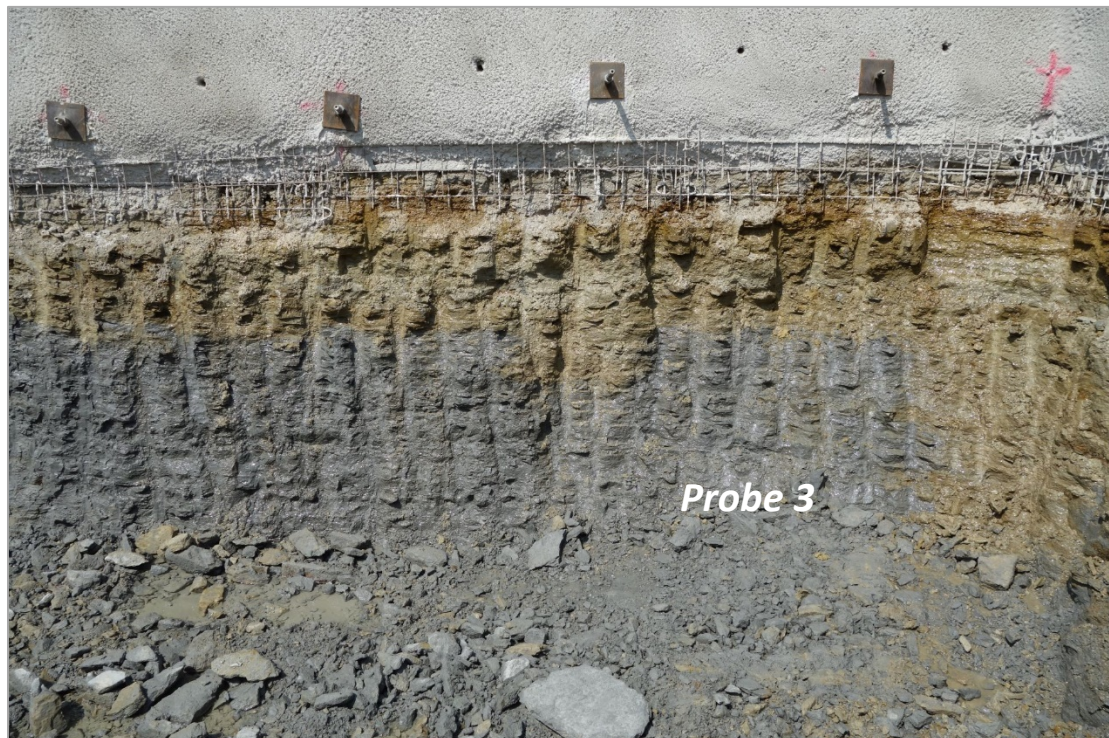
Abb. 2.1.2.43: Umfahrung Lambach-Nord- Aufschlusspunkt 3, Tunnelportal Ost: Gebankte dunkelgraue bis grünliche „Vöckla-Formation“ mit Probenahmepunkt (Foto: H. Peresson).
