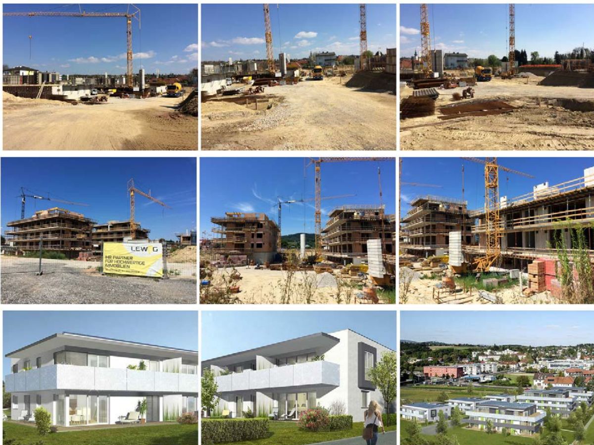
Abb. 2.1.4.1: Baustellendokumentation der LEWOG in der Dallingerstraße in Leonding ( www.lewog.at ).
