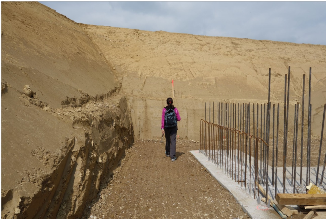
Abb. 2.1.2.16: Umfahrung Lambach-Nord- Aufschlusspunkt 1 im Bereich Breitenberg (Überführung Schlinkerleitenstraße): Im Hangfussbereich 6 m mächtige Löss-Lehme (Foto: H. Peresson).
