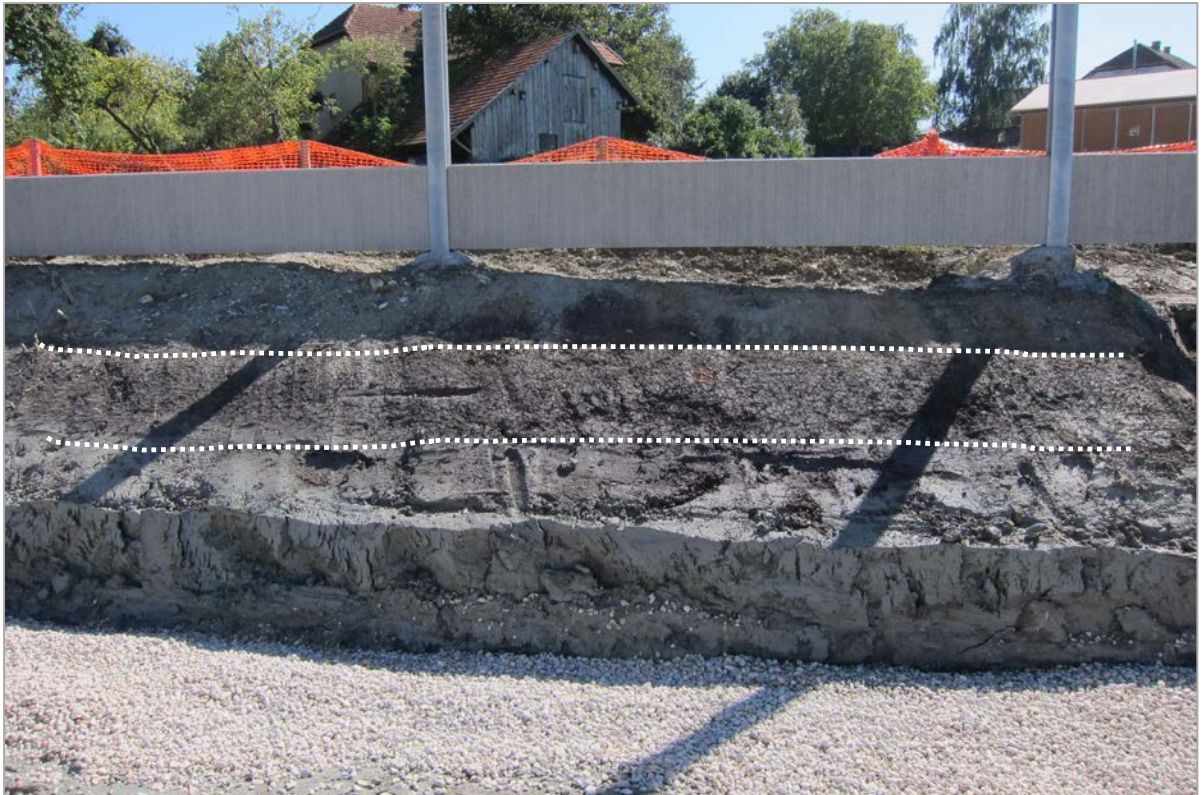
Abb. 2.1.1.27: Hanganschnitt an der A8 bei Niedernhaag: Schluffig, sandige graue Deckschicht mit Einschaltung von torfiger Lage (schwarz; Anmoor) (Foto: M. Peresson).
