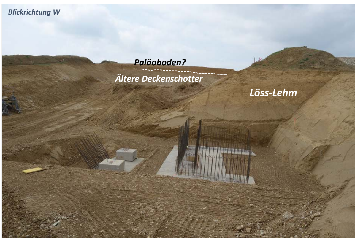
Abb. 2.1.2.7: Umfahrung Lambach-Nord- Aufschlusspunkt 1 im Bereich Breitenberg (Überführung Schlinkerleitenstraße): „Ältere Deckenschotter“ im Hintergrund; Löss-Lehm Bedeckung im Hangfussbereich (Foto: H. Peresson).
