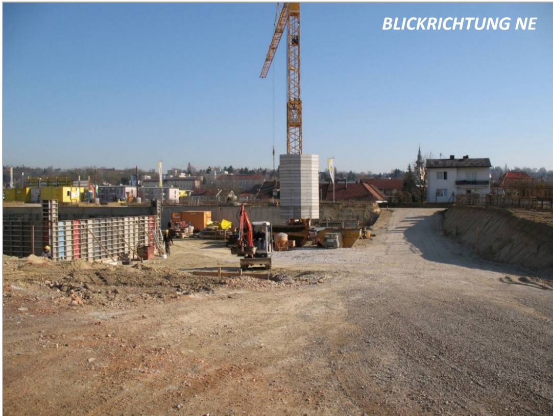
Abb. 2.1.4.5: Überblick über das Baustellengelände der LEWOG in Leonding (Foto Ch. Rupp).
