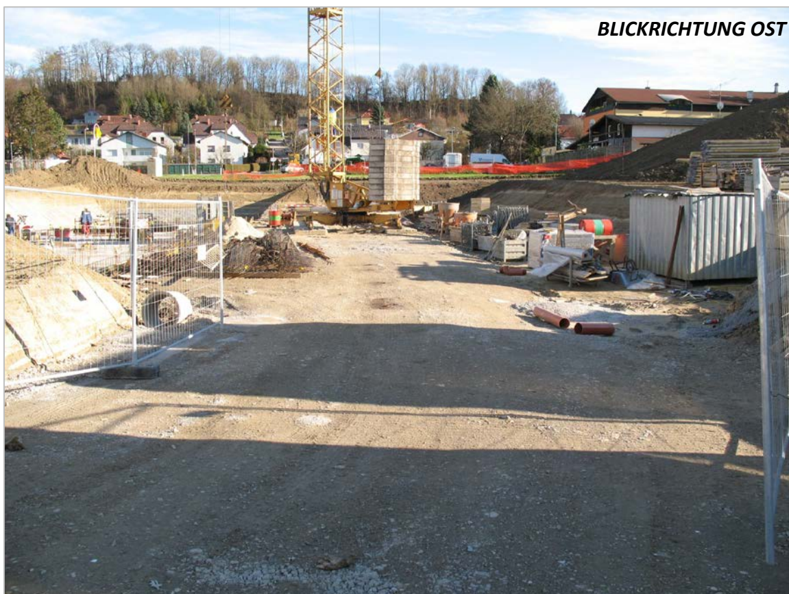
Abb. 2.1.3.5: Überblick über das Baustellengelände der „Neuen Heimat“ in Schönering (Foto: Ch. Rupp).
