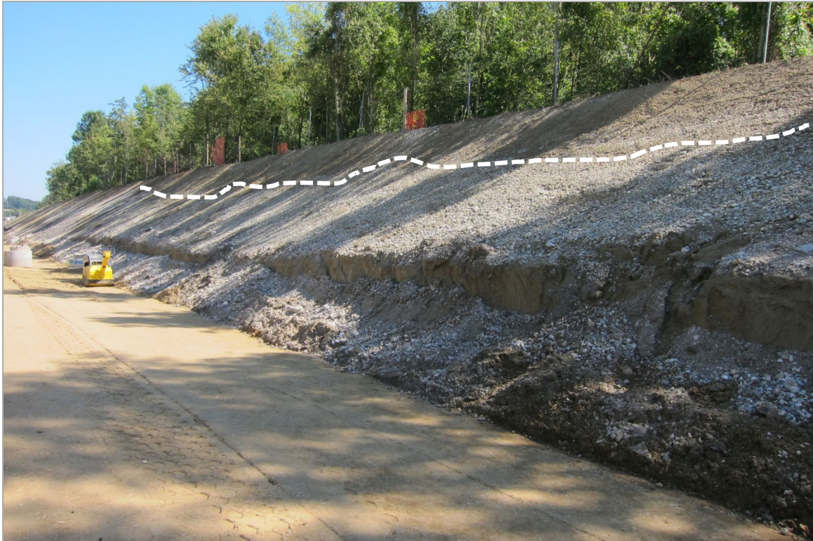
Abb. 2.1.1.20: Hanganschnitt an der A8 bei Niedernhaag: Hellgraue Grob- bis Mittelkiese; deutliches Relief zur Deckschicht erkennbar (Foto: M. Peresson).
