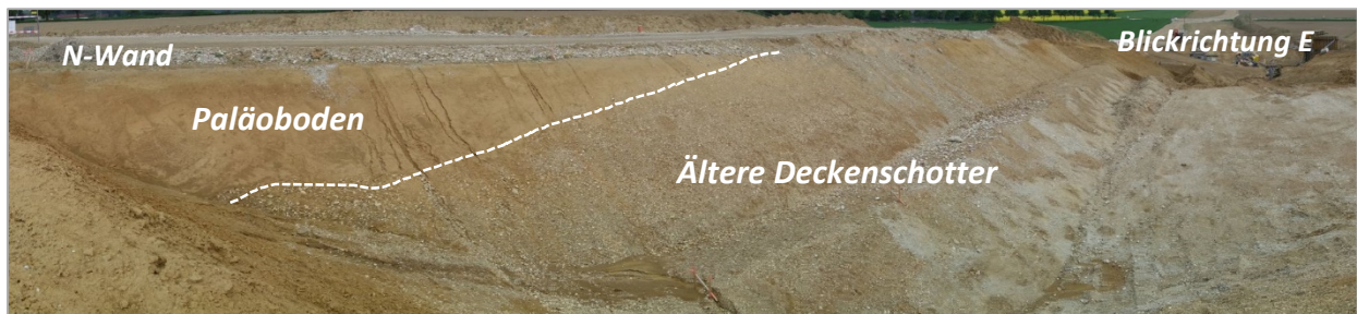
Abb. 2.1.2.10: Umfahrung Lambach-Nord- Aufschlusspunkt 1 im Bereich Breitenberg (Überführung Schlinkerleitenstraße): Knapp 7 m mächtige „Ältere Deckenschotter“ mit Dellen artig auflagerndem Paläoboden am Top des Hanganschnittes (Foto: H. Peresson).
