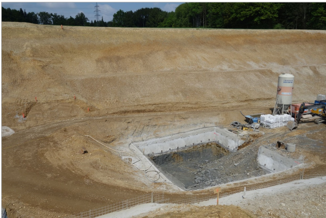
Abb. 2.1.2.35: Umfahrung Lambach-Nord- Aufschlusspunkt 3, Tunnelportal Ost: „Vöckla-Formation“ an der Basis (Foto: H. Peresson).
