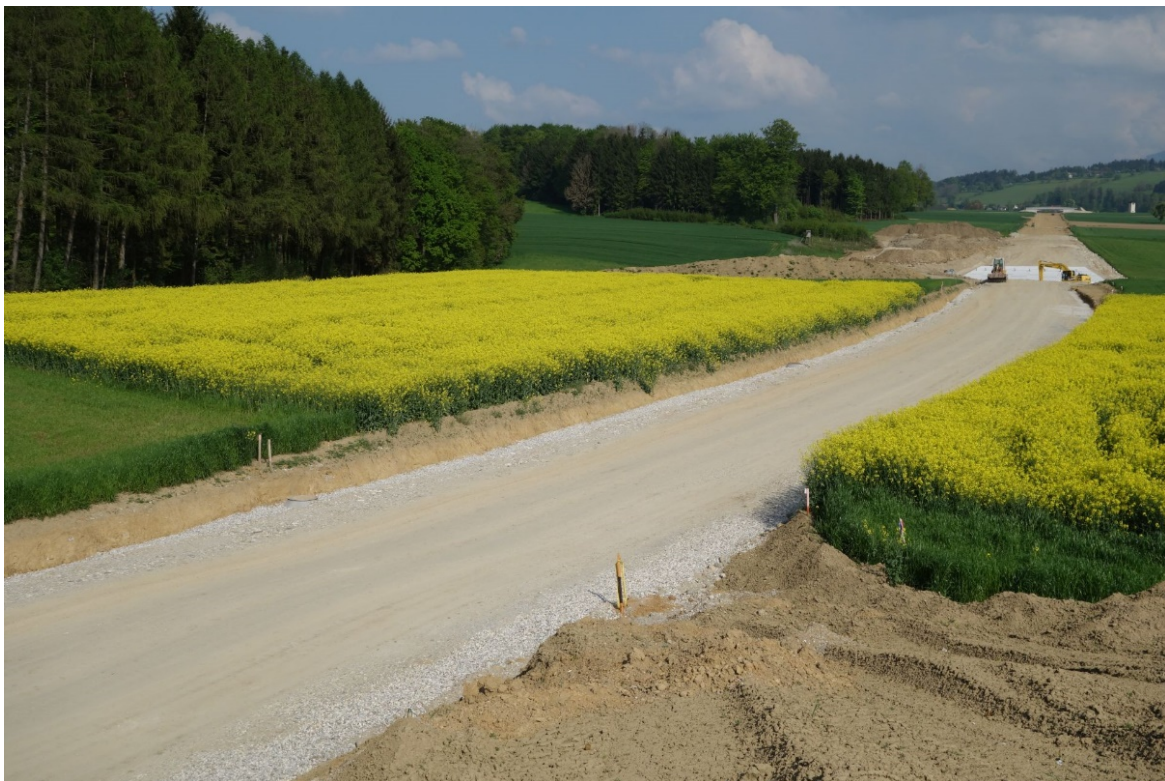
Abb. 2.2.1.25: Umfahrung Gmunden-Ost, Aufschlusspunkt 3, Überführung Steig: Überblicksaufnahme der Umfahungstrasse; aufgenommen Mai 2014 (Foto: M. Peresson).
