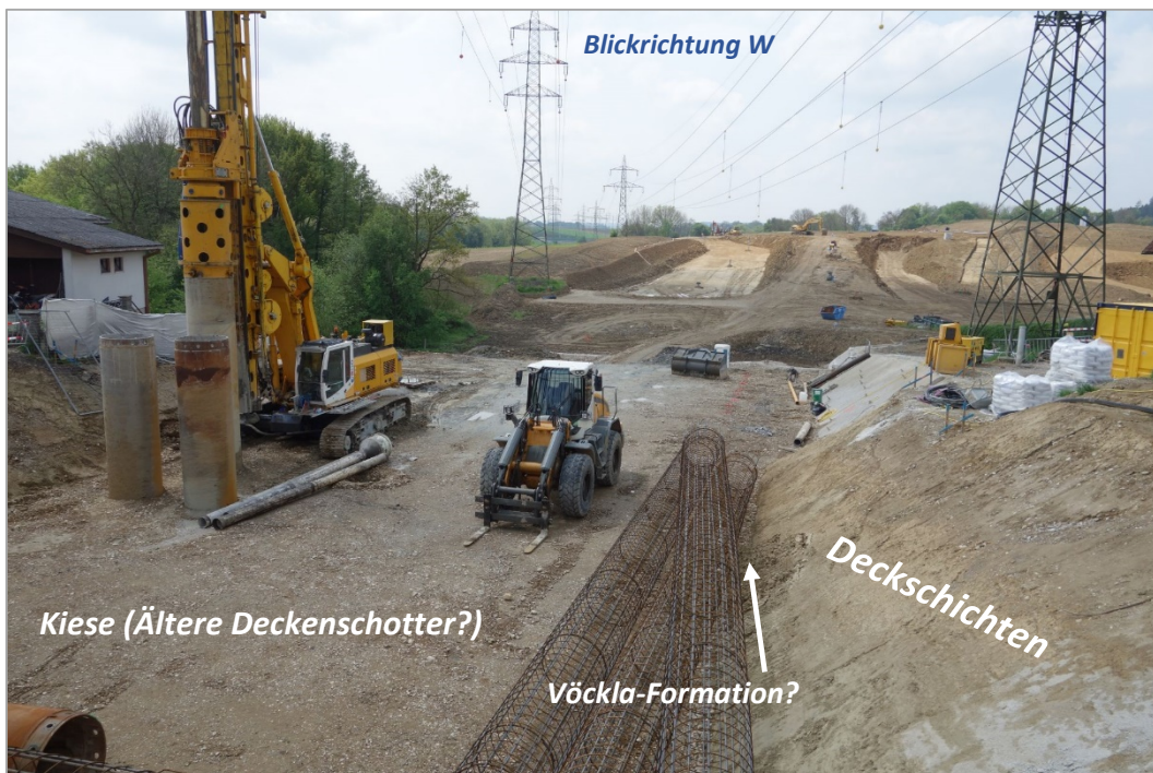
Abb. 2.1.2.24: Umfahrung Lambach-Nord- Aufschlusspunkt 2, Tunnelportal West: Einblick in die N-Wand unterhalb des Hanganschnitt an der Bundesstraße mit Deckschichten im Hangenden; an der Basis vermutete grünliche Vöckla-Formation (Foto: H. Peresson).
