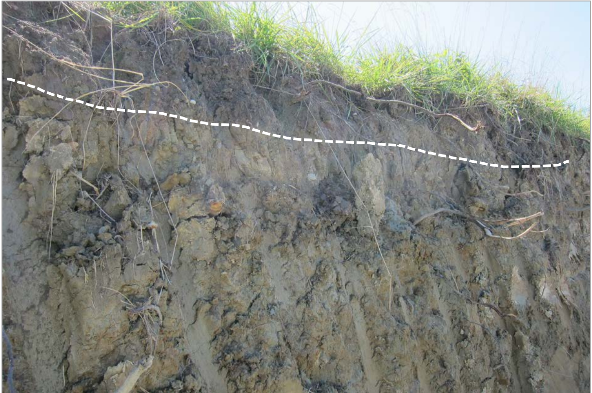
Abb. 2.1.1.17: Hanganschnitt an der A8 bei Niedernhaag: Braun verwitterte Ottnang-Formation; Bankung mit Bodenhorizont (dunkelbraun) im Hangenden (Foto: M. Peresson).
