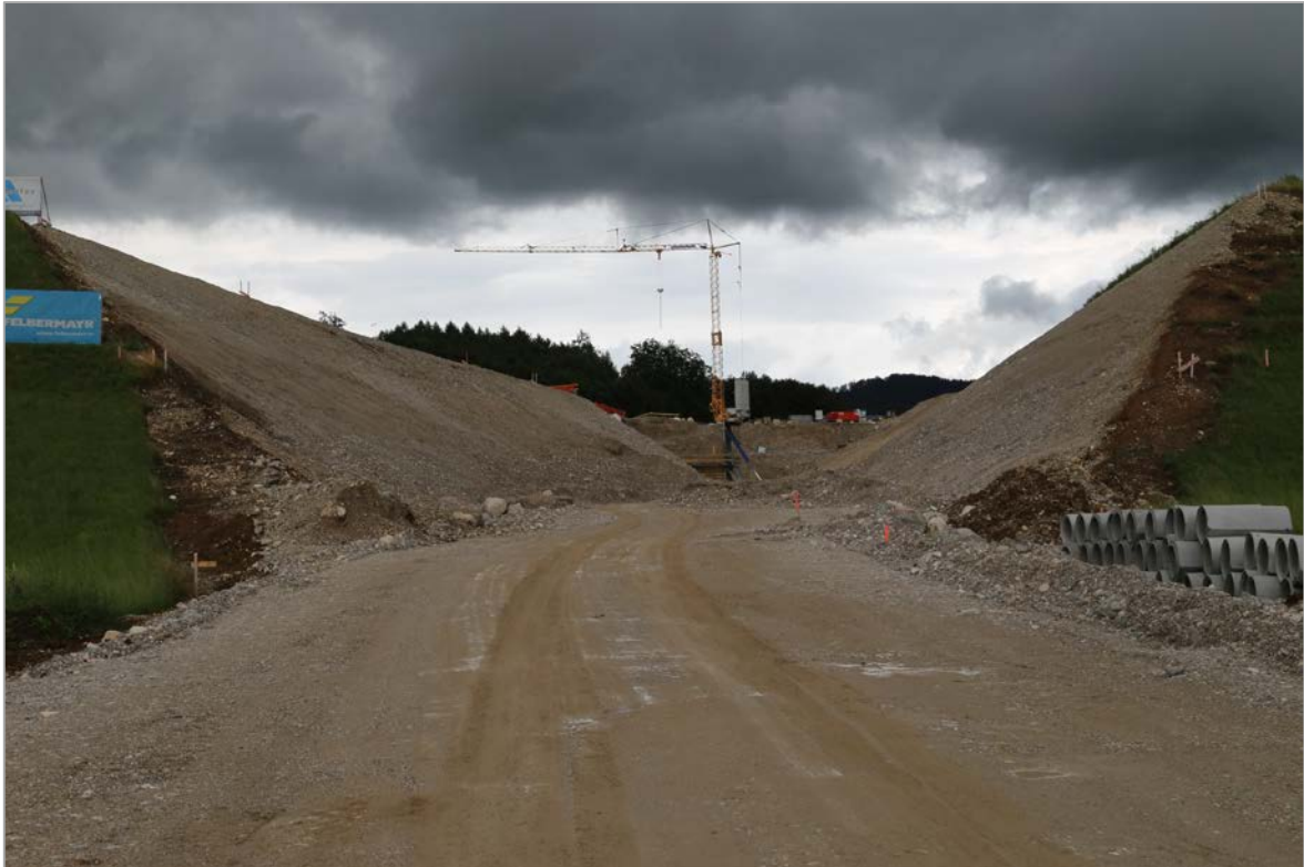
Abb. 2.2.1.16: Umfahrung Gmunden-Ost, Aufschlusspunkt 2a, W der Bahn: Kies- und Sandkörper der Niederterrasse und des Übergangskegels (Hochstand); aufgenommen Juni 2014 (Foto: I. Wimmer-Frey).
