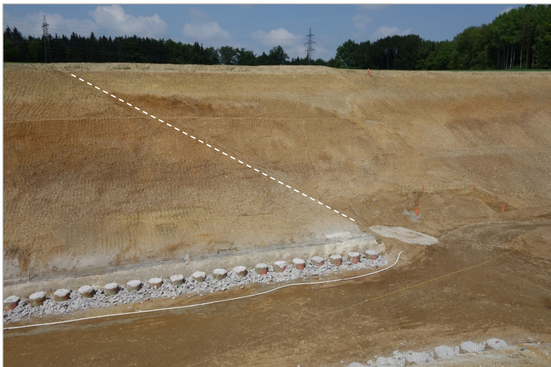
Abb. 2.1.2.33: Umfahrung Lambach-Nord- Aufschlusspunkt 3, Tunnelportal Ost: N-S streichende Störung (Aufschiebung) erkennbar; undeutliches Kryoturbationsgefüge (Foto: H. Peresson).
