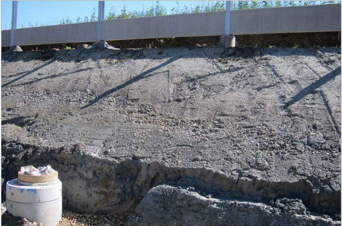
Abb. 2.1.1.26: Hanganschnitt an der A8 bei Niedernhaag: Schluffig, sandige grau-braune Deckschicht mit Kieslagen (Foto: M. Peresson).
