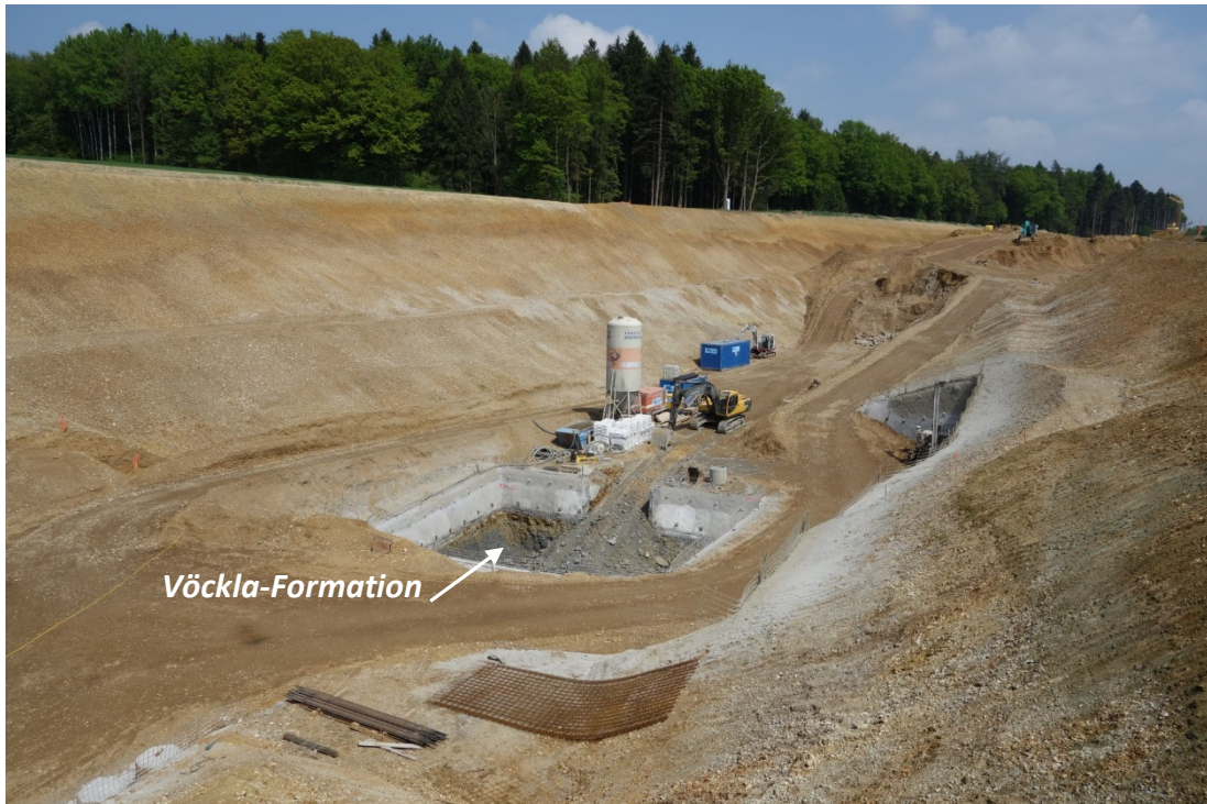
Abb. 2.1.2.34: Umfahrung Lambach-Nord- Aufschlusspunkt 3, Tunnelportal Ost: Am tiefsten Geländeaushub der Trasse ist „Vöckla-Formation“ aufgeschlossen (Foto: H. Peresson).
