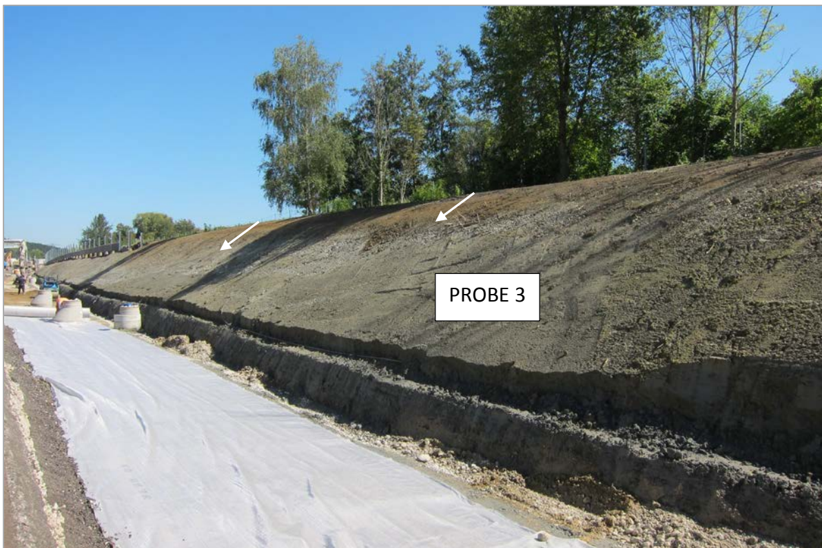
Abb. 2.1.1.25: Hanganschnitt an der A8 bei Niedernhaag: Schluffige grau-braune Deckschicht mit vereinzelt Kiesschnüren – siehe weiße Pfeile; Probenahmepunkt (Foto: M. Peresson).
