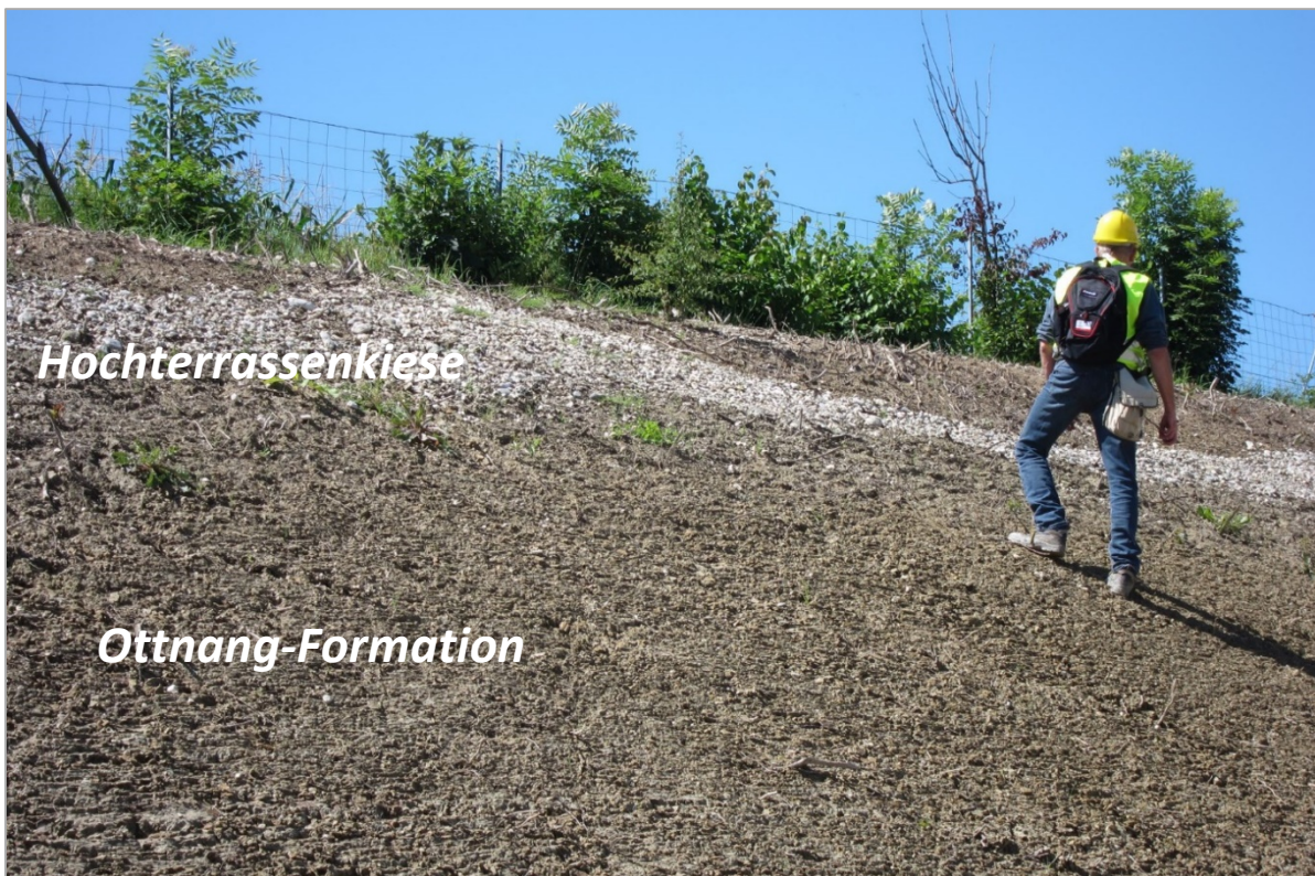
Abb. 2.1.1.8: Hanganschnitt an der A8 nördlich von Haag am Hausruck: Rhythmisch gebankte Ottnang-Formation mit abschnittsweise wechselnder Farbausbildung von grau zu braun (Foto: M. Peresson).
