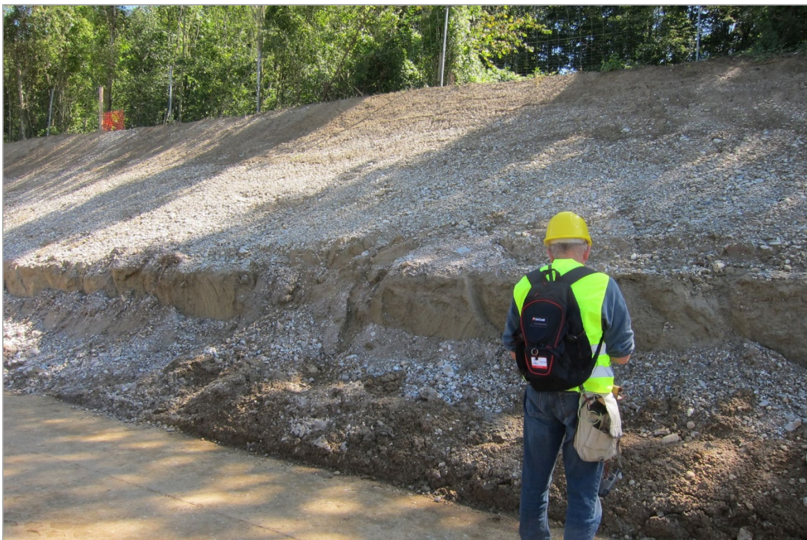
Abb. 2.1.1.19: Hanganschnitt an der A8 bei Niedernhaag: Hellgraue Grob- bis Mittelkiese unterlagert von Ottnang-Formation; im Hangenden schluffige Deckschichten (Foto: M. Peresson).
