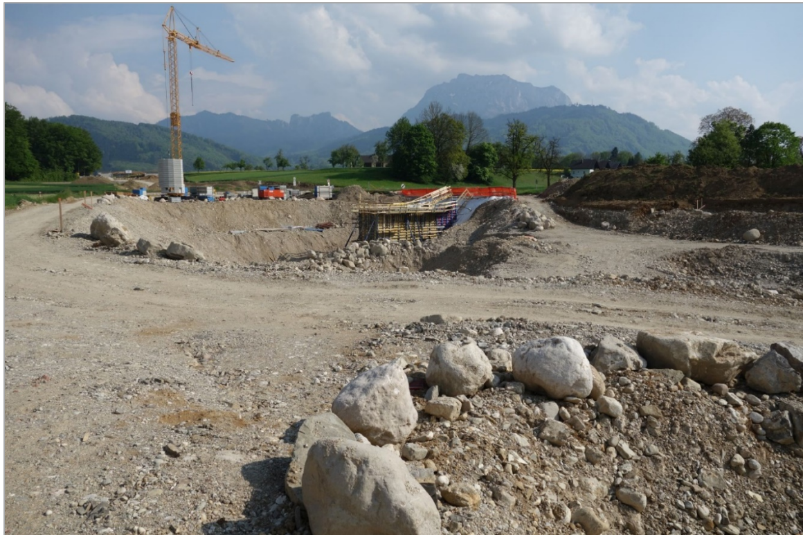
Abb. 2.2.1.19: Umfahrung Gmunden-Ost, Aufschlusspunkt 2a, W der Bahn: Driftblöcke aus Kalkstein und Flyschsandsteinen der Umgebung in beiden Aushüben; aufgenommen Mai 2014 (Foto: M. Peresson).
