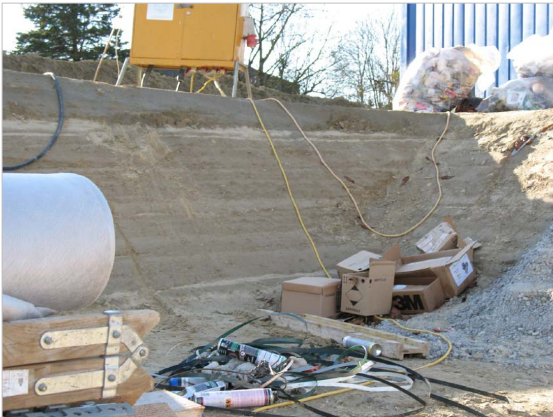
Abb. 2.1.3.7: Südwestwand des Bauplatzes in Schönering: Durchziehende Feinsandlagen im Schluff (Foto: Ch. Rupp).
