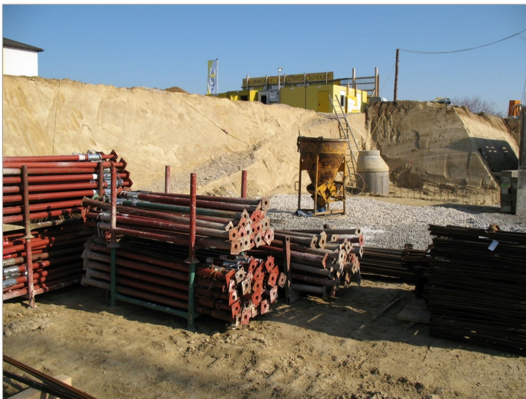
Abb. 2.1.4.8: Bauaushub im NW Bereich des Baustellengeländes in Leonding: 4 m Aufschlusswand aus gelblichbraunem Löss (Foto Ch. Rupp).
