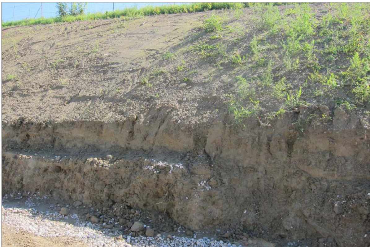
Abb. 22.1.1.9: Hanganschnitt an der A8 bei Buch: Schluffig, sandige grau-braune Solifluktsions-schicht mit Kieseinstreu im Übergang zur Ottnang-Formation (Foto: M. Peresson).
