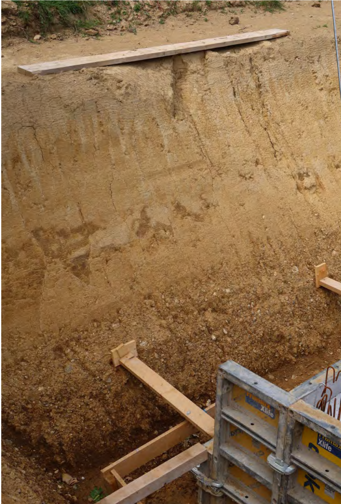
Abb. 2.3.2.10.: „Baulos Wohnhausanlage in Piberbach“: 3,5m tiefer Hanganschnitt in der Baugrube mit Lösslehm und Hochterrassenschottern an der Basis; kalkalpines, schlecht gerundetes Komponentenspektrum (Foto: M. Peresson).
