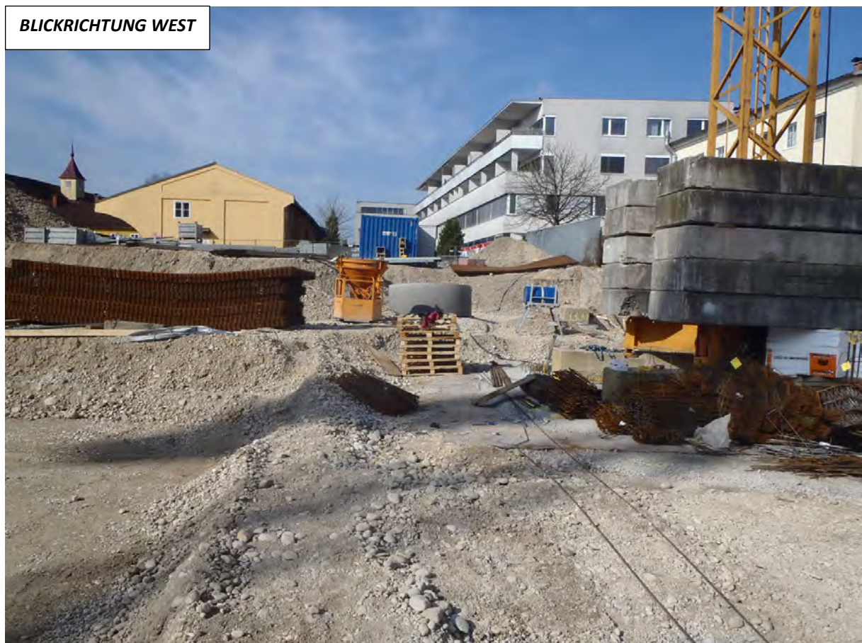
Abb. 2.3.4.7: „Baustelle in Traun, Graumannviertel“: Überblick über den Baustellenbereich (Foto: Ch. Benold).
