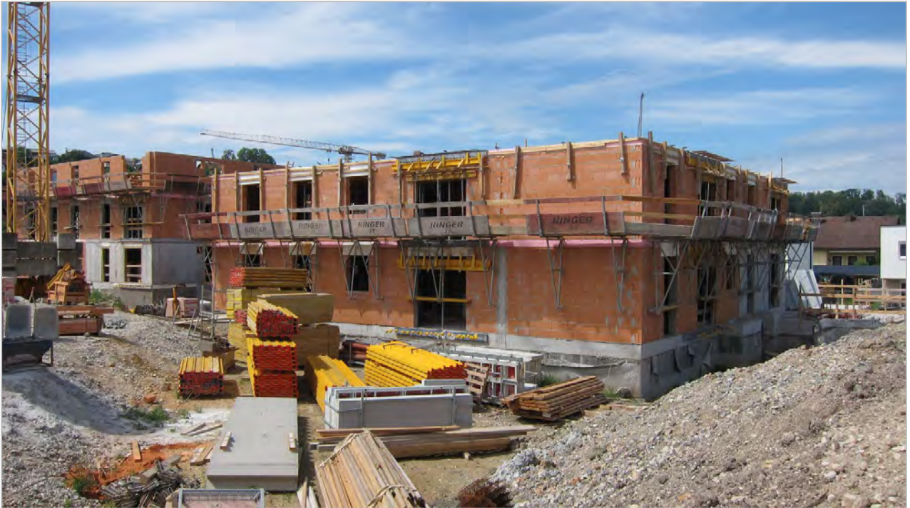
Abb. 2.3.2.6.: „Baulos Wohnhausanlage in Piberbach“: Überblick über den Baustellenbereich (Foto: M. Peresson).
