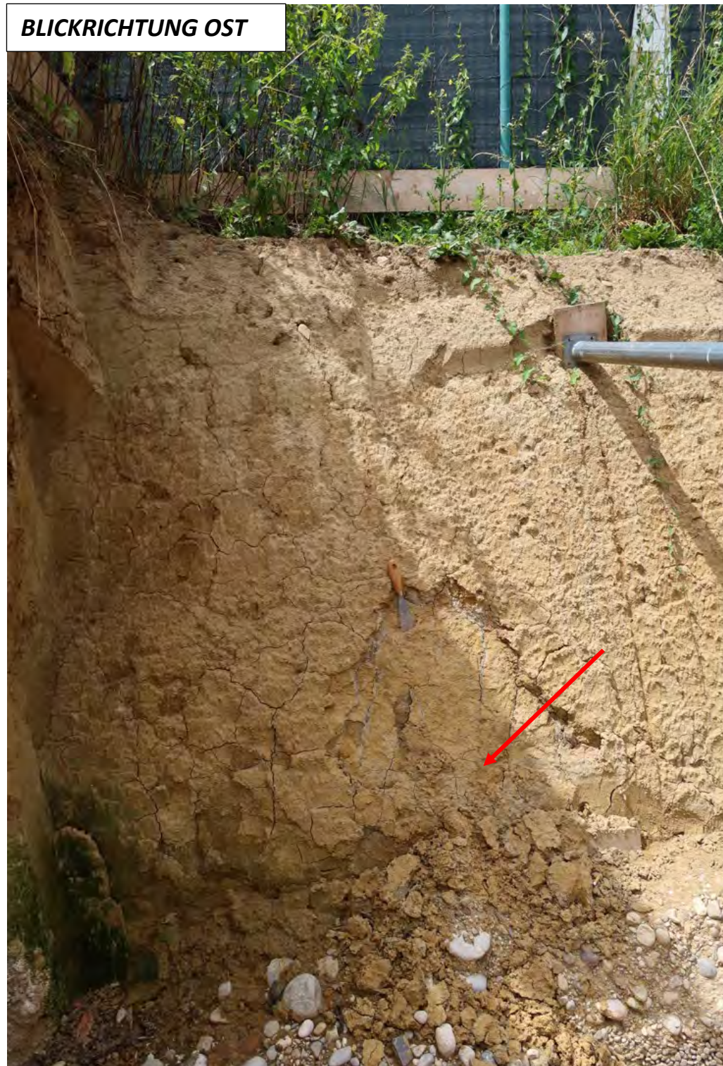
Abb. 2.3.1.13.: „Baulos Wohnhausanlage Neuhofen an der Krems“: Südseite - Zwei Meter hoher Hanganschnitte mit aus tonig, sandigem braunen Schluff (quartärer Lösslehm). Teilweise Abbruch der Sedimente aus dem Hang im unteren Bereich. Probenahmepunkt an der Ostseite (Probe 1). (Foto: M. Peresson).
