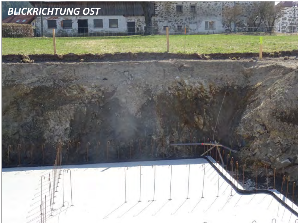
Abb. 2.1.1.7.: „Baugrube in Pröselsdorf, Hauswies“: 4m tiefer Hanganschnitt in der Baugrube für ein Einfamilienhaus; Mauthausener Granit (feinkörnig) und Weinsberger Granite (grobkörnig) (Foto: G. Griesmeier).
