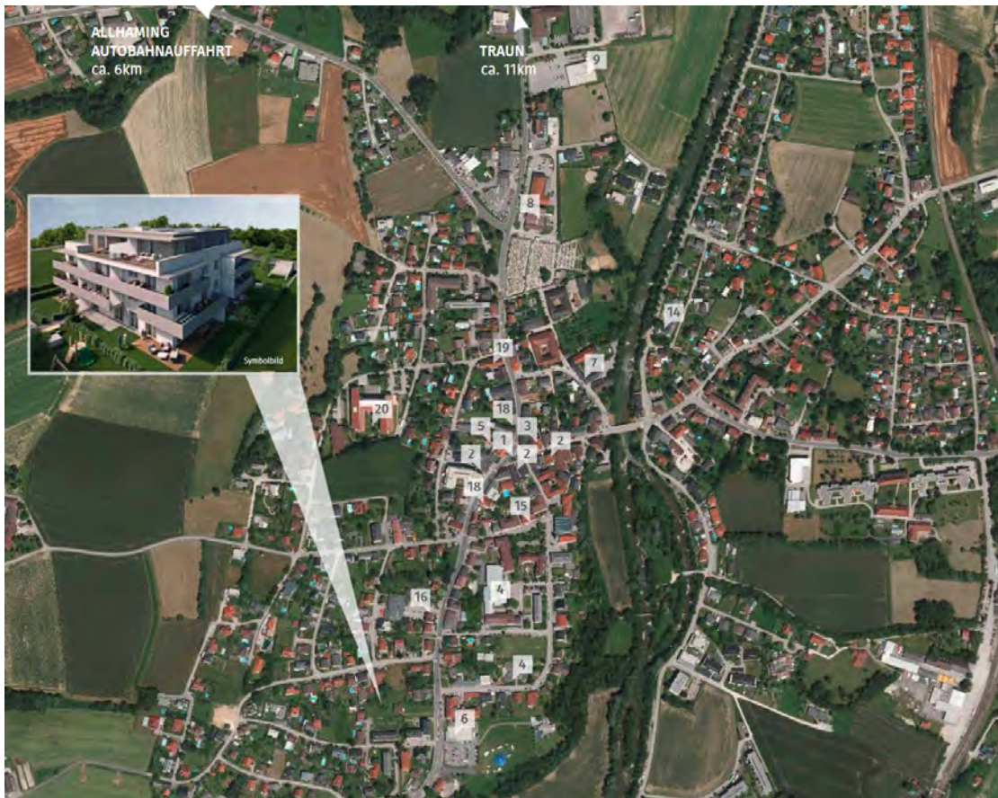
Abb. 2.3.1.1.: Projektplan für eine Wohnhausanlage in Neuhofen an der Krens, Kremstalstraße 30 (entnommen aus https://www.brunner-bau.at ).
