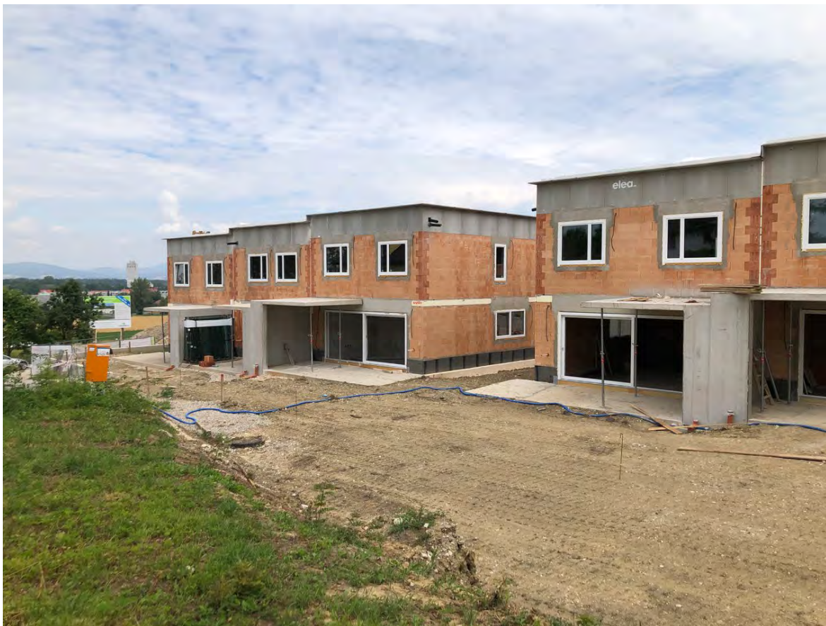
Abb. 2.2.1.8.: „Baulos Wohnhausanlage in Ansfelden am Hochfeld“: Überblick über den Baustellenbereich; am Baustellengelände alles planiert; keine Aufschlüsse vorhanden (Foto: M. Peresson).
