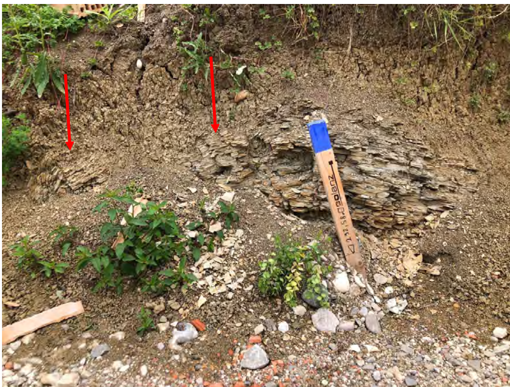
Abb. 2.2.1.12.: „Baulos Wohnhausanlage in Ansfelden am Hochfeld“: Sämtliche Schichtpakete erscheinen verkippt (rotiert); es handelt sich wahrscheinlich um Hangrutschungen bzw. Setzungen (keine tektonischen Bewegungen) (Foto: M. Peresson).
