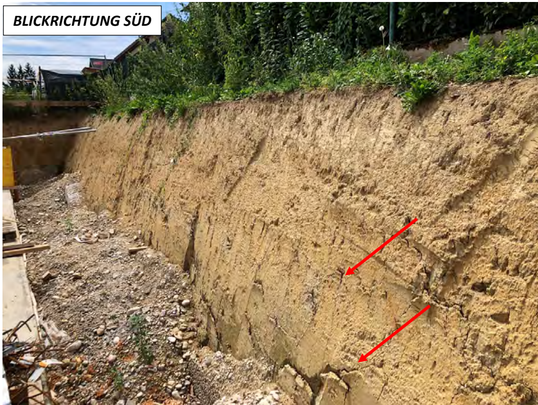
Abb. 2.3.1.11.: „Baulos Wohnhausanlage Neuhofen an der Krems“: Südseite - Zwei Meter hoher Hanganschnitte mit 20 cm dunkelbraunen Bodenhorizont. Im Anschluss tonig, sandiger brauner Schluff (quartärer Lösslehm). Teilweise Abbruch der Sedimente aus dem Hang im unteren Bereich (Foto: M. Peresson).
