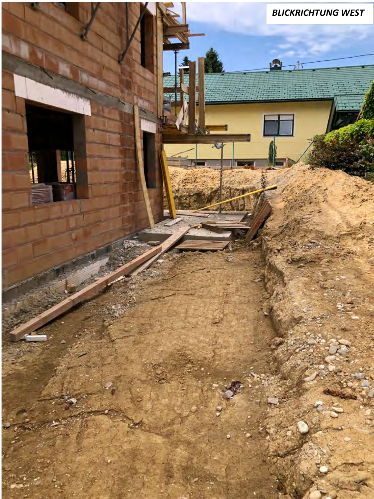
Abb. 2.3.1.10.: „Baulos Wohnhausanlage Neuhofen an der Krems“: Nordhang mit tonig, sandigem rötlichbraunem Schluff (quartärer Lösslehm) (Foto: M. Peresson).
