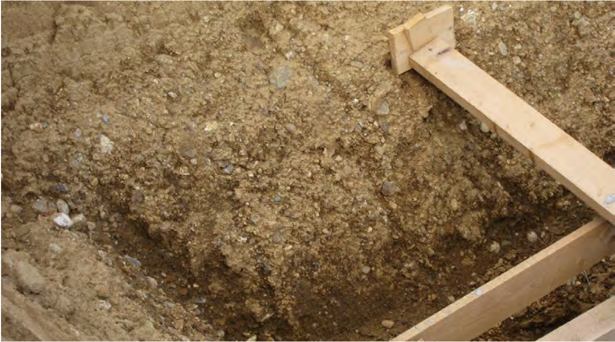
Abb. 2.3.2.11.: „Baulos Wohnhausanlage in Piberbach“: Hochterrassenschottern an der Basis; kalkalpines, schlecht gerundetes Komponentenspektrum (Foto: M. Peresson).
