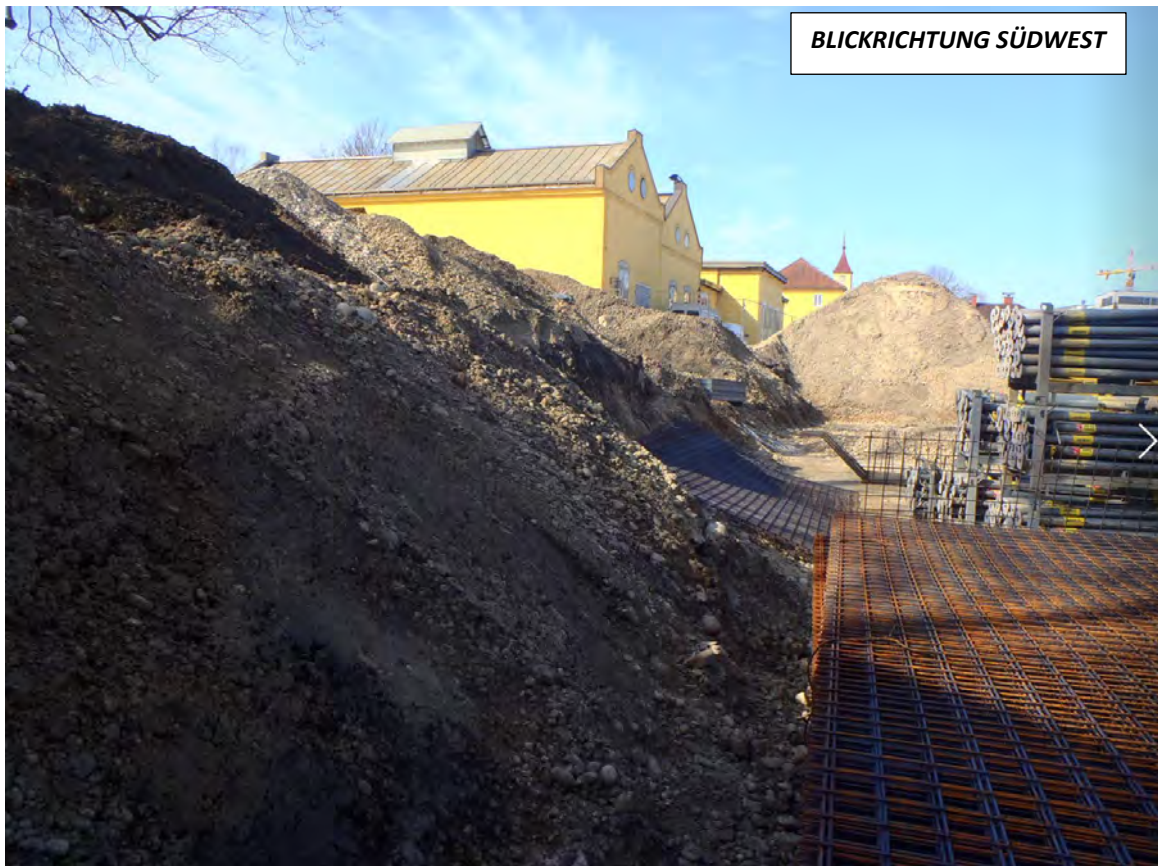
Abb. 2.3.4.8.: „Baustelle in Traun, Graumannviertel“: Überblick über den Baustellenbereich (Foto: Ch. Benold).
