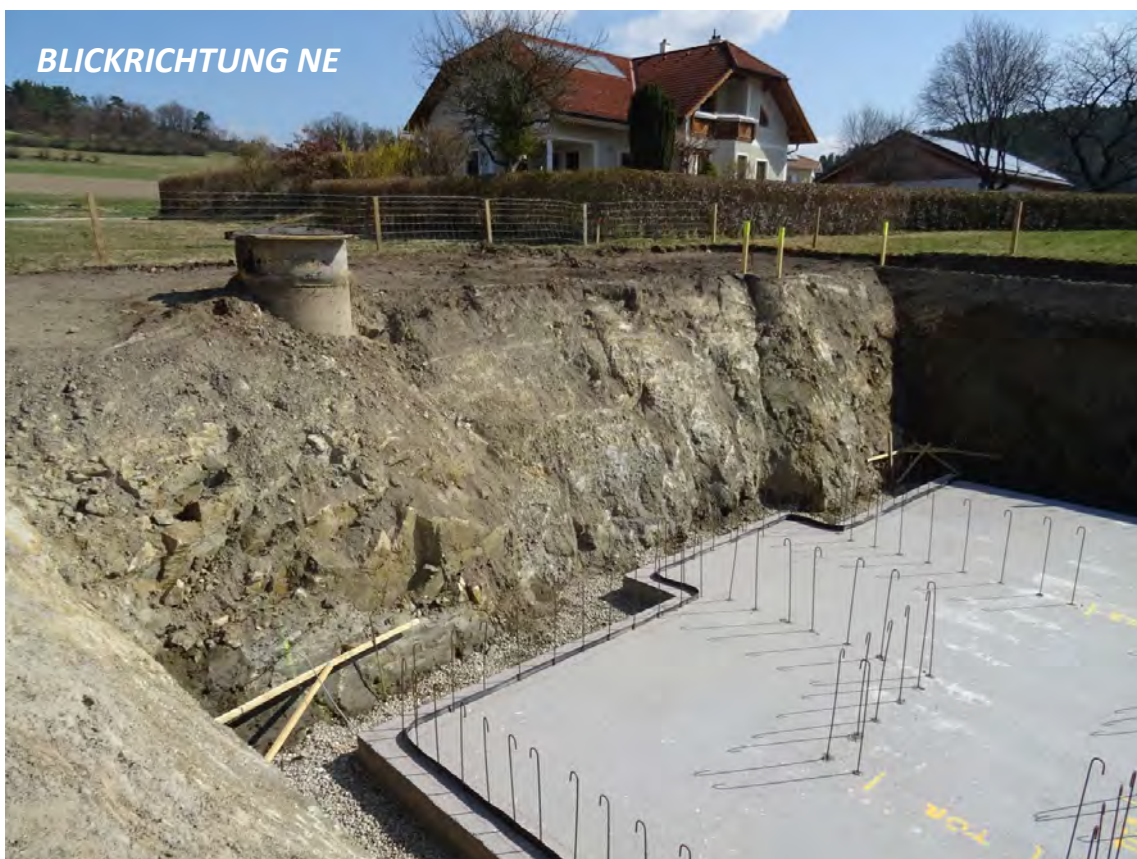
Abb. 2.1.1.6.: „Baugrube in Pröselsdorf, Hauswies“: 4m tiefer Hanganschnitt in der Baugrube für ein Einfamilienhaus; Mauthausener Granite (feinkörnig) und Weinsberger Granite (grobkörnig) (Foto: G. Griesmeier).
