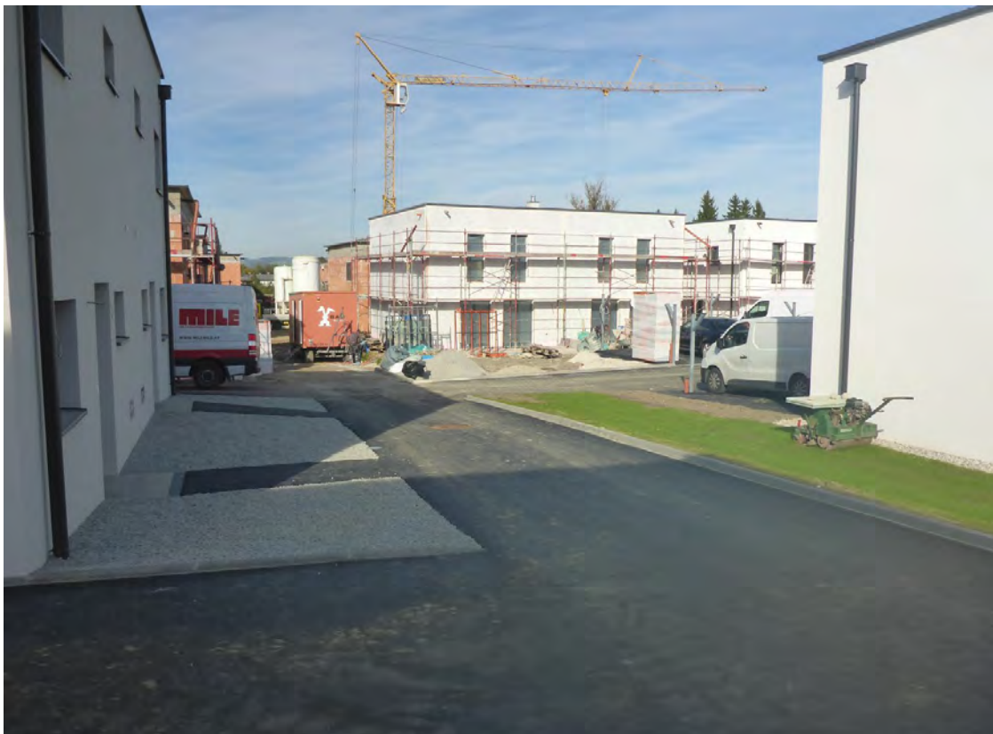
Abb. 2.3.3.7.: Überblick Siedlungsbau - Baustellengelände in Straßham (Foto: F. Hofmayer).
