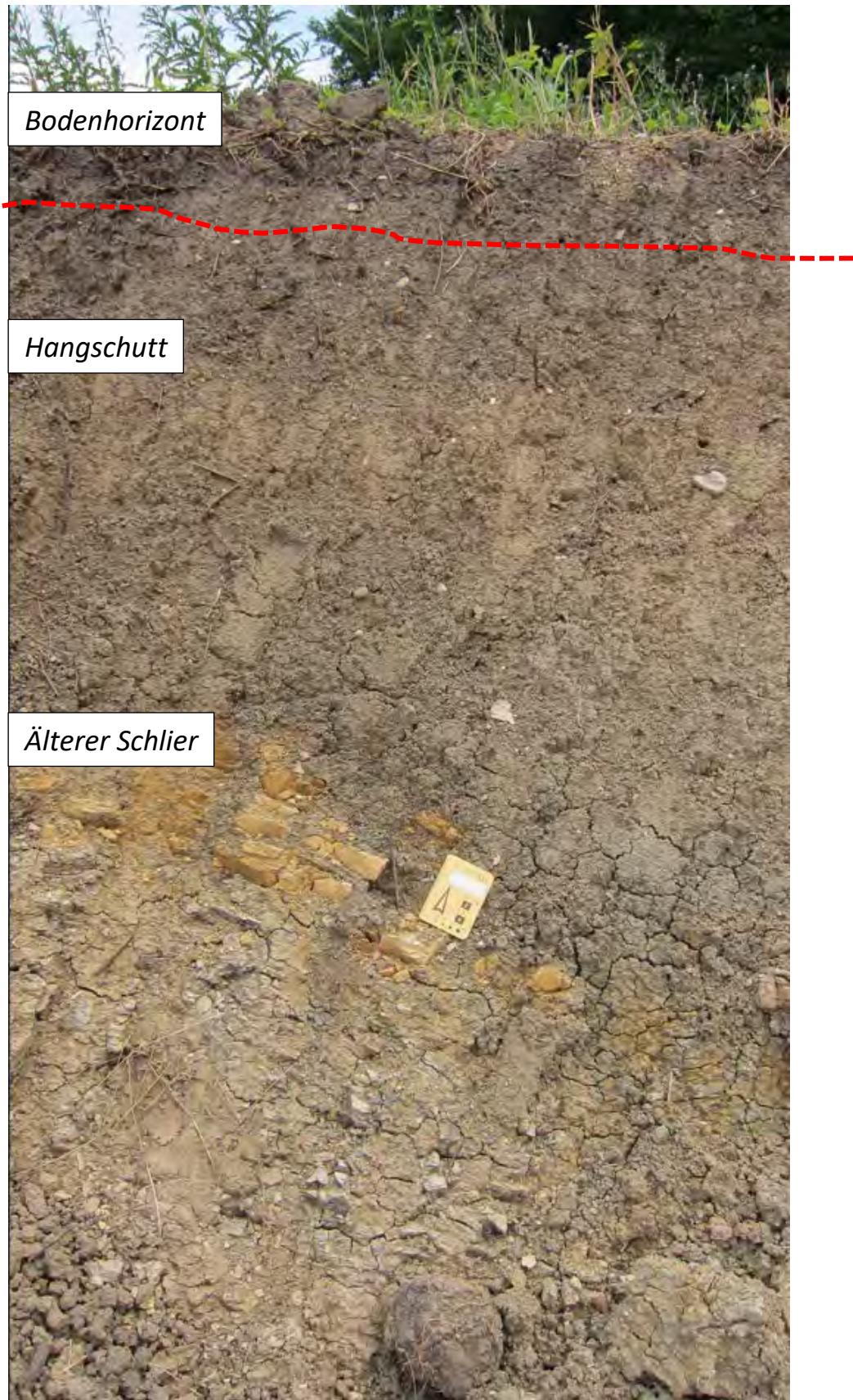
Abb. 2.2.1.16.: „Baulos Wohnhausanlage in Ansfelden am Hochfeld“: Am Top des Hanganschnittes ist ein Bodenhorizont ausgebildet, der in Hangschutt übergeht. Die Grenze zum „Schlier“ bildet die rötliche Dolomitkonkretion (Foto: M. Peresson).
