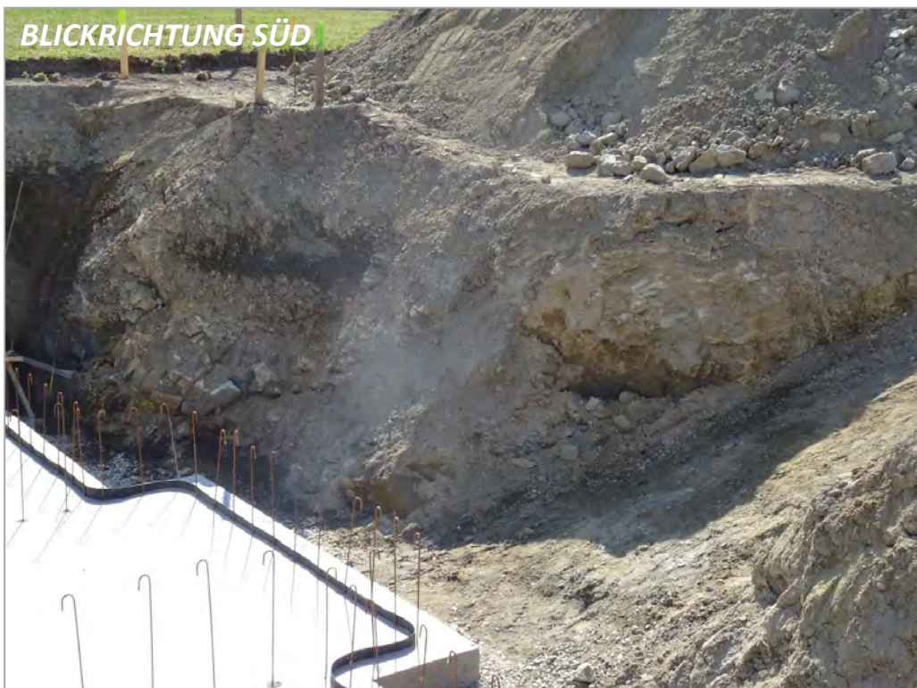
Abb. 2.1.1.8.: „Baugrube in Pröselsdorf, Hauswies“: 4m tiefer Hanganschnitt in der Baugrube für ein Einfamilienhaus; Mauthausener Granit (feinkörnig) und Weinsberger Granite (grobkörnig) (Foto: G. Griesmeier).
