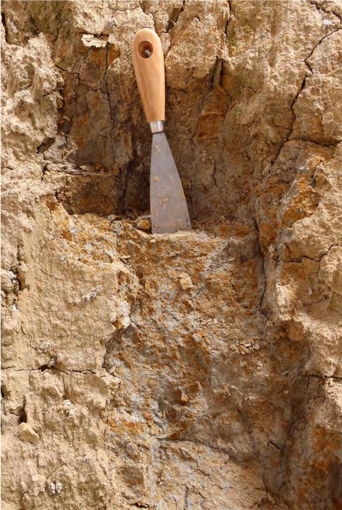
Abb. 2.3.1.14.: „Baulos Wohnhausanlage Neuhofen an der Krems“: Südseite - Zwei Meter hoher Hanganschnitte mit aus tonig, sandigem braunen Schluff (quartärer Lösslehm). Bereichsweise marmoriertes Aussehen der Sedimente. Detailfoto vom Probenahmepunkt an der Ostseite (Probe 1). (Foto: M. Peresson).
