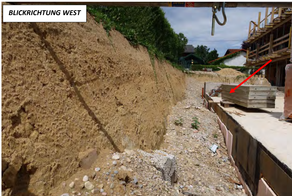
Abb. 2.3.1.12.: „Baulos Wohnhausanlage Neuhofen an der Krems“: Südseite - Zwei Meter hoher Hanganschnitte mit aus tonig, sandigem braunen Schluff (quartärer Lösslehm). Probenahmepunkt an der Westseite (Probe 2) (Foto: M. Peresson).
