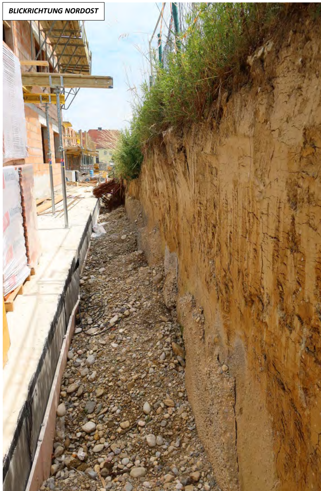
Abb. 2.3.1.15.: „Baulos Wohnhausanlage Neuhofen an der Krems“: Südseite - Zwei Meter hoher Hanganschnitt mit aus tonig, sandigem braunen Schluff (quartärer Lösslehm) (Foto: M. Peresson).
