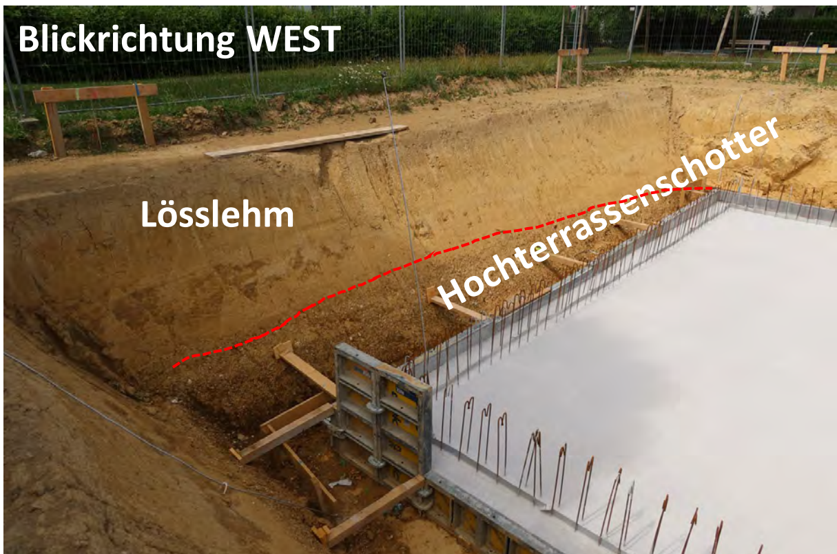
Abb. 2.3.2.9.: „Baulos Wohnhausanlage in Piberbach“: 3,5m tiefer Hanganschnitt in der Baugrube mit Lösslehm und Hochterrassenschottern an der Basis; markante Grenze zwischen den beiden Schichten erkennbar (Foto: M. Peresson).
