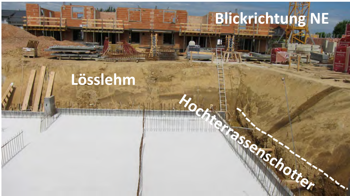
Abb. 2.3.2.8.: „Baulos Wohnhausanlage in Piberbach“: 3,5m tiefer Hanganschnitt in der Baugrube mit 2,5m mächtigem Lösslehm und 1m mächtigem Hochterrassenschottern an der Basis (Foto: M. Peresson).
