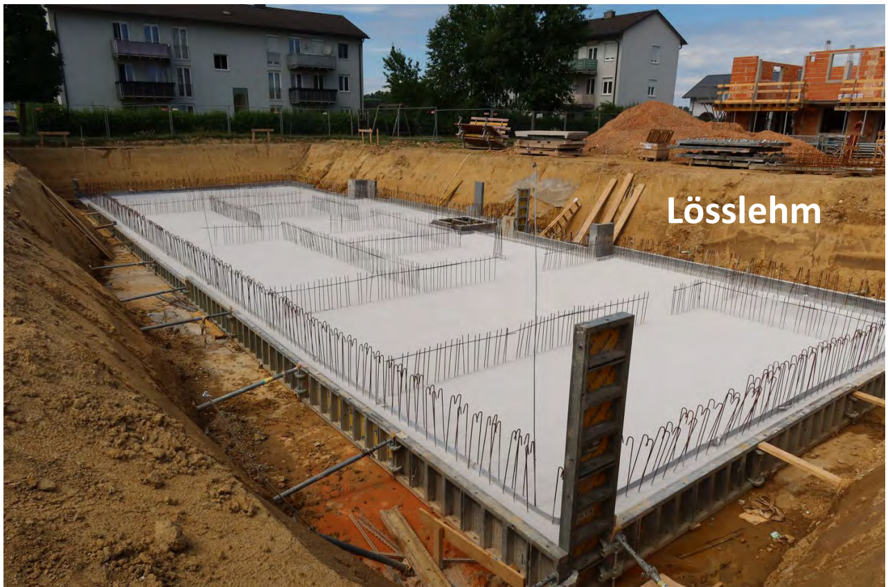
Abb. 2.3.2.7.: „Baulos Wohnhausanlage in Piberbach“: 3,5m tiefer Hanganschnitt in der Baugrube mit 2,5m mächtigem Lösslehm und 1m mächtigem Hochterrassenschottern an der Basis (Foto: M. Peresson).
