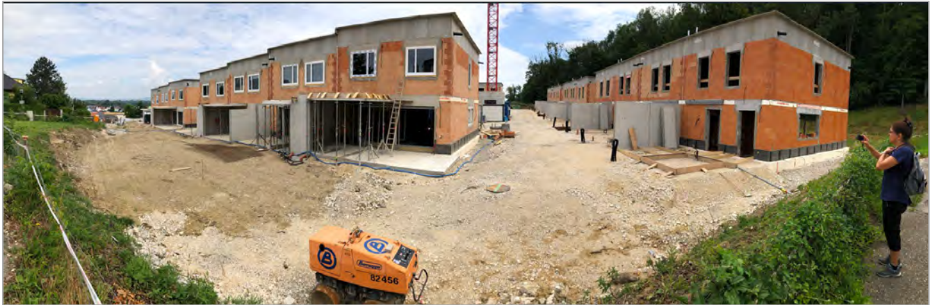
Abb. 2.2.1.7.: „Baulos Wohnhausanlage in Ansfelden am Hochfeld“: Überblick über den Baustellenbereich (Foto: M. Peresson).
