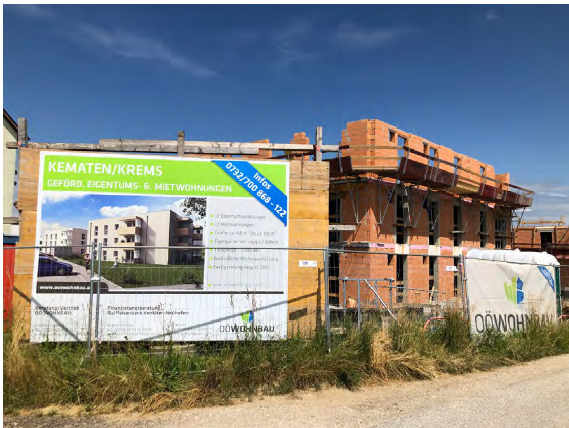
Abb. 2.2.2.7.: „Baulos Wohnhausanlage in Kematen an der Krems“: Überblick über den Baustellenbereich (Foto: M. Peresson).
