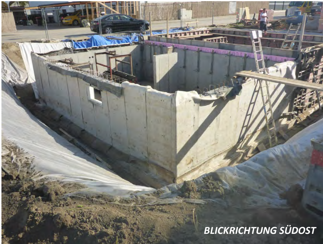
Abb. 2.3.3.8.: Überblick über die Baugrube in Straßham (Foto: F. Hofmayer).
