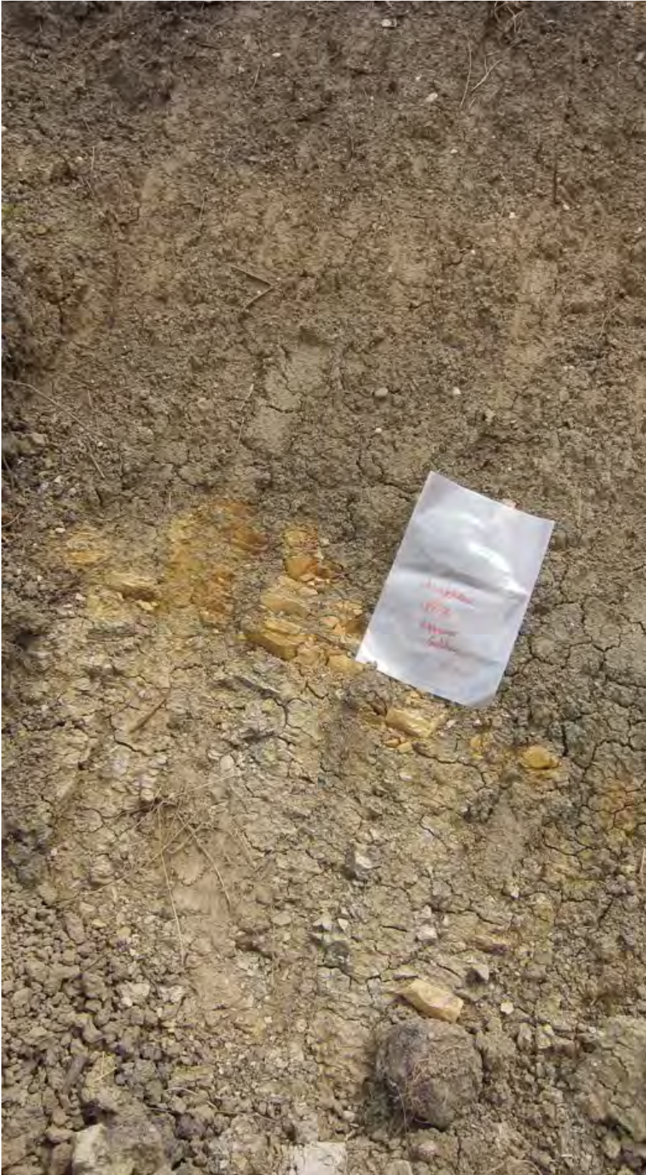
Abb. 2.2.1.18.: „Baulos Wohnhausanlage in Ansfelden am Hochfeld“: Probenahmepunkte im „Schlier“ (Foto: M. Peresson).
