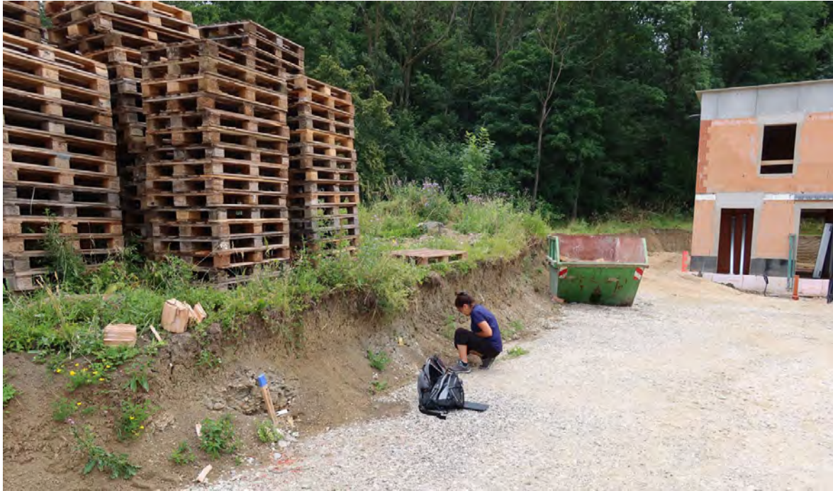
Abb. 2.2.1.9.: „Baulos Wohnhausanlage in Ansfelden am Hochfeld“: Angrenzend an der Nordostseite des Baustellengeländes Hanganschnitt aus gebankten Schliersedimenten (Foto: H. Peresson).
