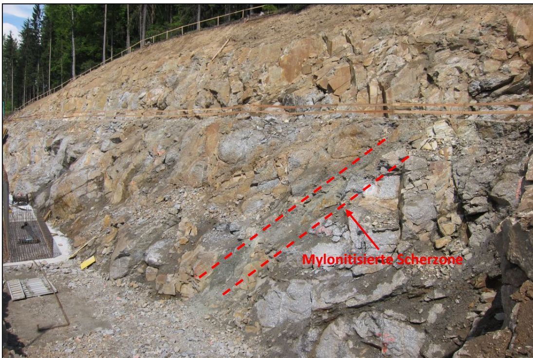
Abb. 2.1.1.12: Mylonitisierte Scherzone (grünliche zerriebene Tone) im Weinsberger Granit beim Nordportal des Tunnels Neumarkt (Foto: M. Peresson).
