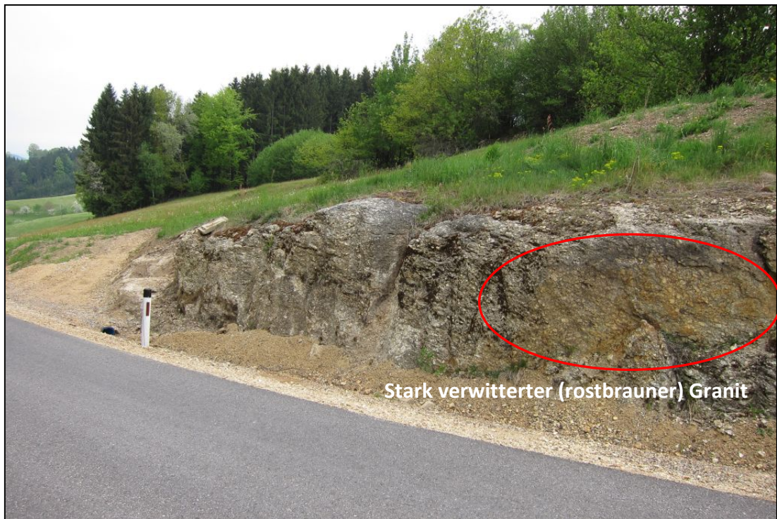
Abb. 2.1.2.5: Bauaufschluss am Güterweg Pehersdorf in verwittertem Weinsberger Granit (Foto: M. Peresson).
