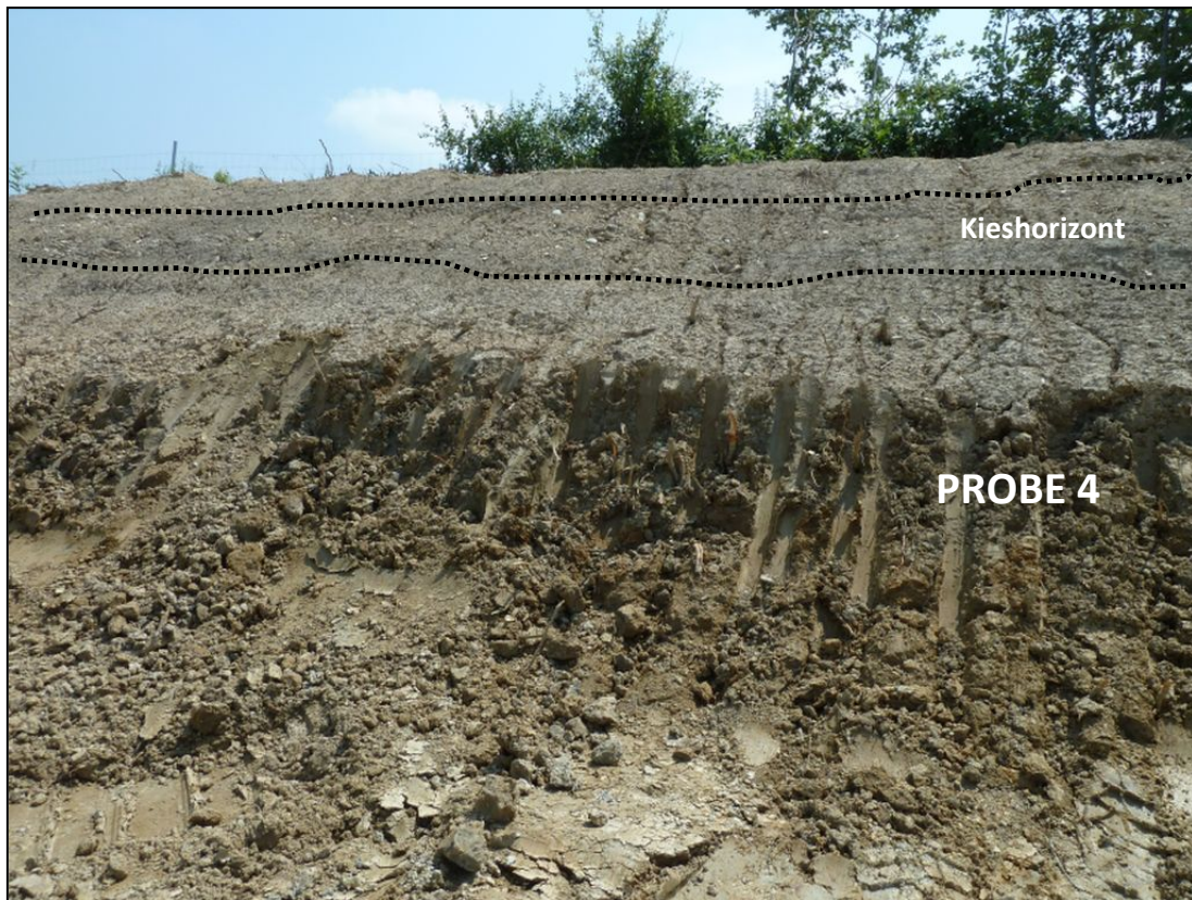
Abb. 2.2.1.13: Im Hangenden Deckschichten mit Kieseinlagerungen; an der Basis verwitterte Ottnang-Formation östlich der Ortschaft Auhäuseln an der A8 (Foto: M. Peresson).
