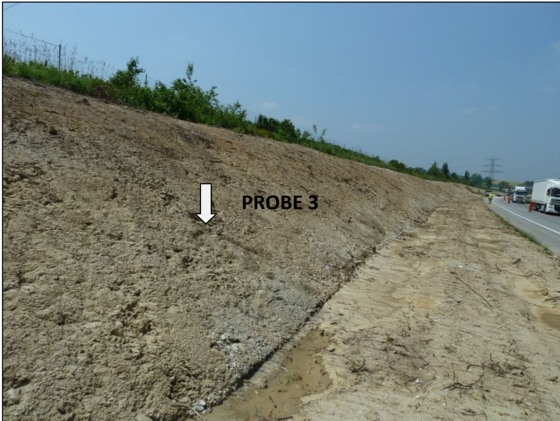
Abb. 2.2.1.12: Schluffig-sandiger Löss-Lösslehm mit Kieseinstreu („Schwemmlöss“?) an der A8 südlich Weibern (Foto: M. Peresson).
