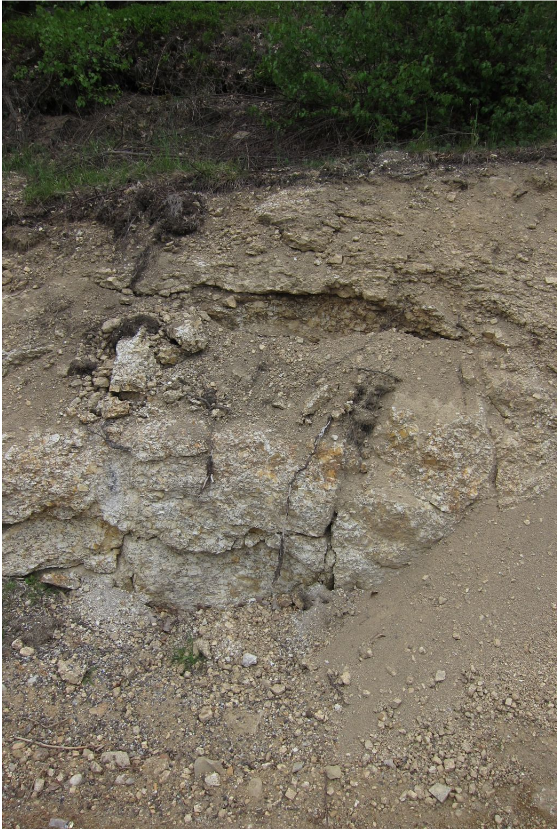
Abb. 2.1.2.11: Hanganschnitt am Güterweg Pehersdorf in verwittertem, geklüfteten Weinsberger Granit (Foto: M. Peresson).
