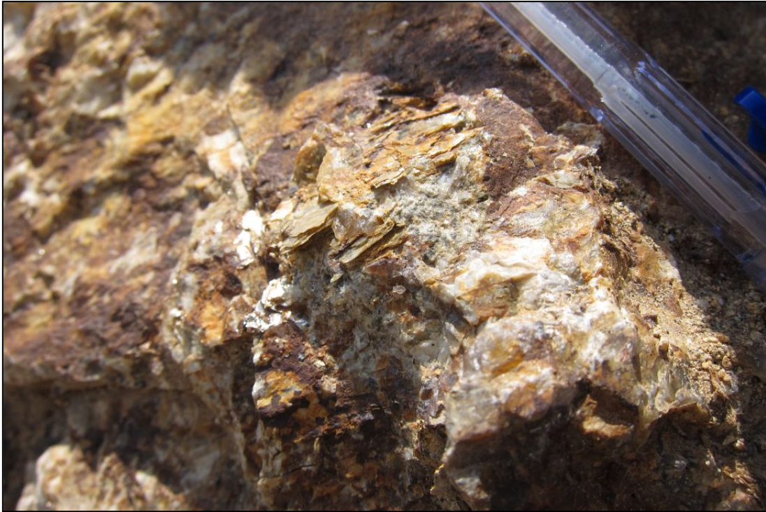
Abb. 2.1.1.8: Detailfoto: Verwitterter Weinsberger Granit im Bereich des Nordportals des Tunnels Götschka (Foto: M. Peresson).
