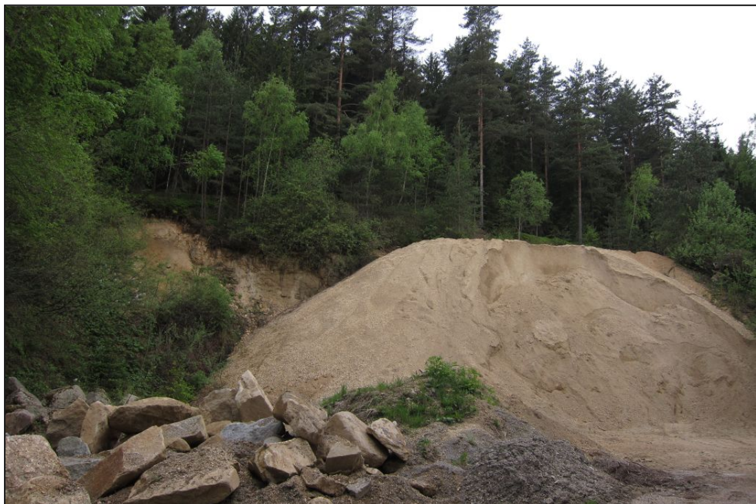
Abb. 2.1.2.15: Abbau 034/150-M im Weinsberger Granit: Stark verwitterte Granitabbauwand, bereits teilweise verwachsen; im Vordergrund frisches Straßenbaumaterial (Foto. M. Peresson)
