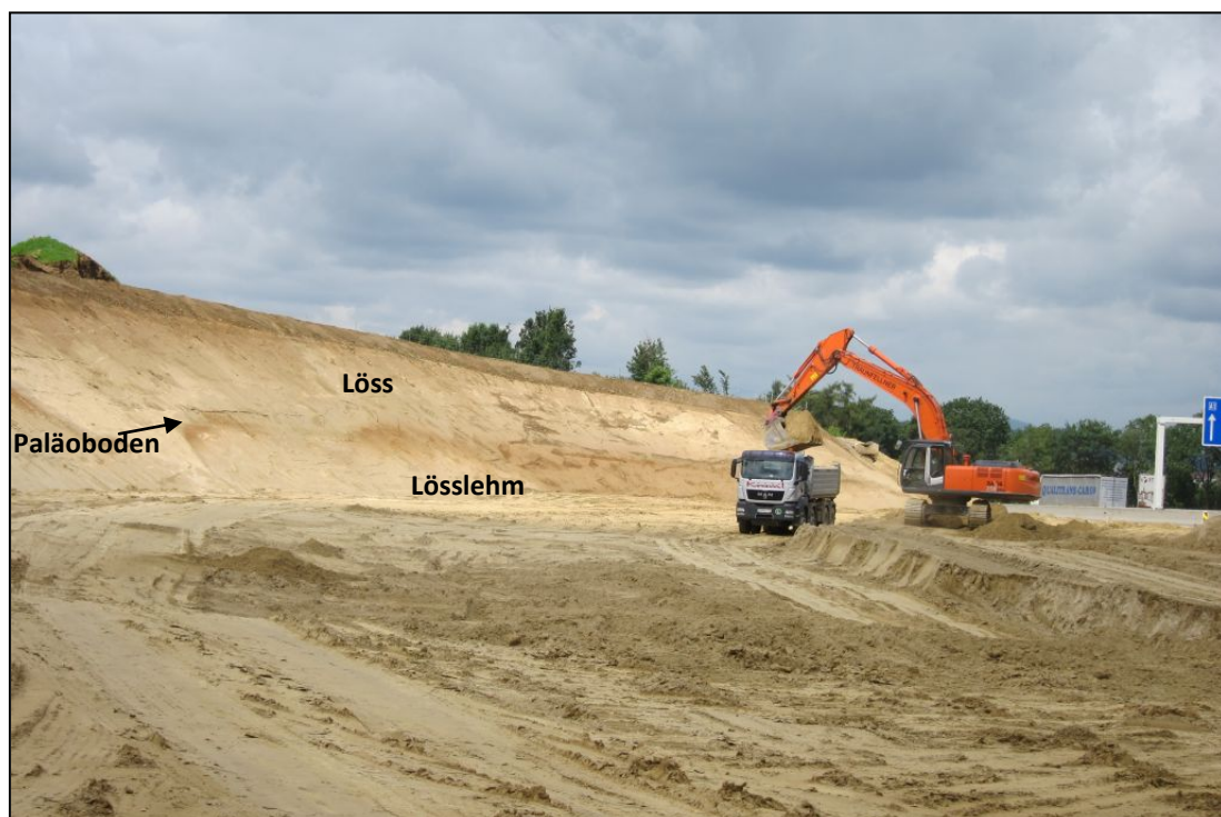
Abb. 2.3.2.7: Hanganschnitt an der Südwestseite der Baugrube knapp an der Westautobahn (Foto: M. Peresson)
