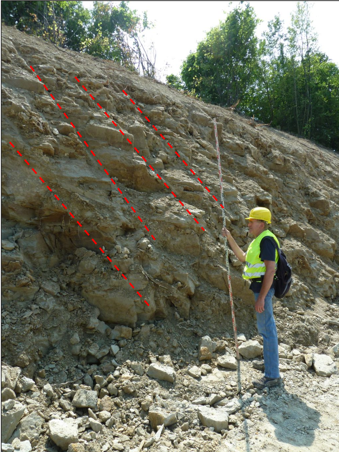
Abb. 2.2.1.21: Stark tektonisierte Ottnang-Formation südlich der Raststätte Aistersheim (Foto: M. Peresson).
