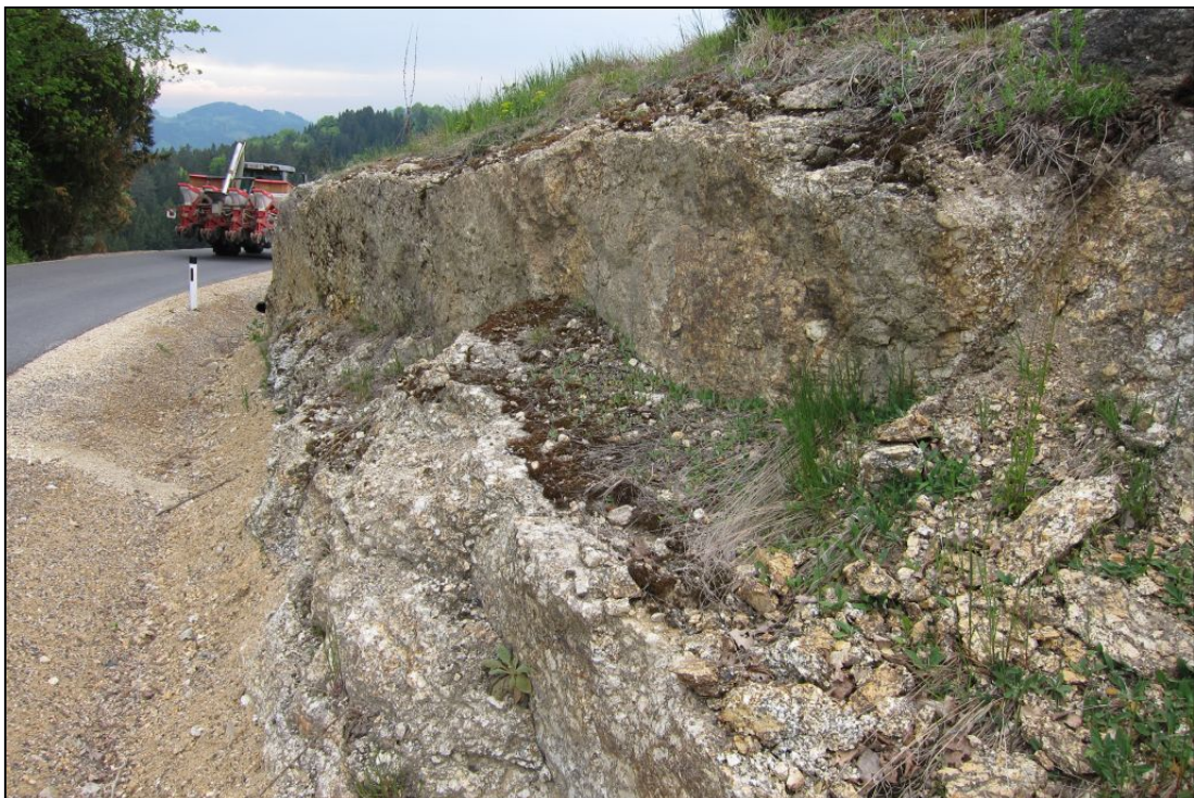
Abb. 2.1.2.6: Bauaufschluss am Güterweg Pehersdorf in geklüftetem Weinsberger Granit (Foto: M. Peresson).
