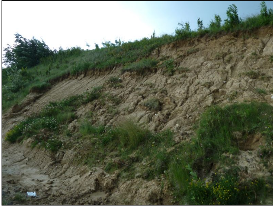
Abb. 2.2.1.35: Hangrutschung in der Atzbach-Formation südlich Etzelsdorf (Foto: M. Peresson)
