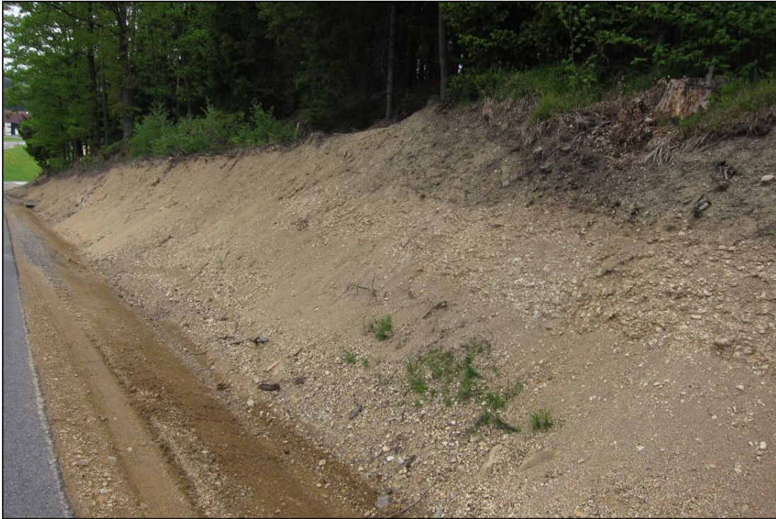
Abb. 2.1.2.12: Straßenanschnitt am Güterweg Pehersdorf in stark verwittertem Weinsberger Granit (Foto: M. Peresson).
