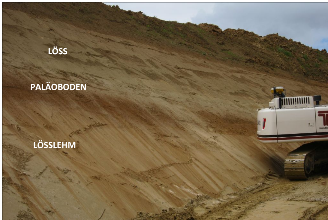
Abb.2.3.2.6: Detailbereich: Hanganschnitt an der Südseite der Baugrube mit rötlichem Paläoboden, eingeschaltet zwischen Löss im Hangenden und Lösslehm im Liegenden (Foto: M. Peresson)
