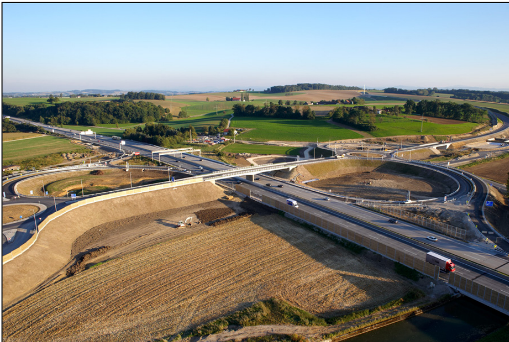
Abb. 2.3.1.2: In Bau befindliche Anschlussstelle Enns-West im Sommer 2009 (entnommen aus hiesl.oevp.at)
