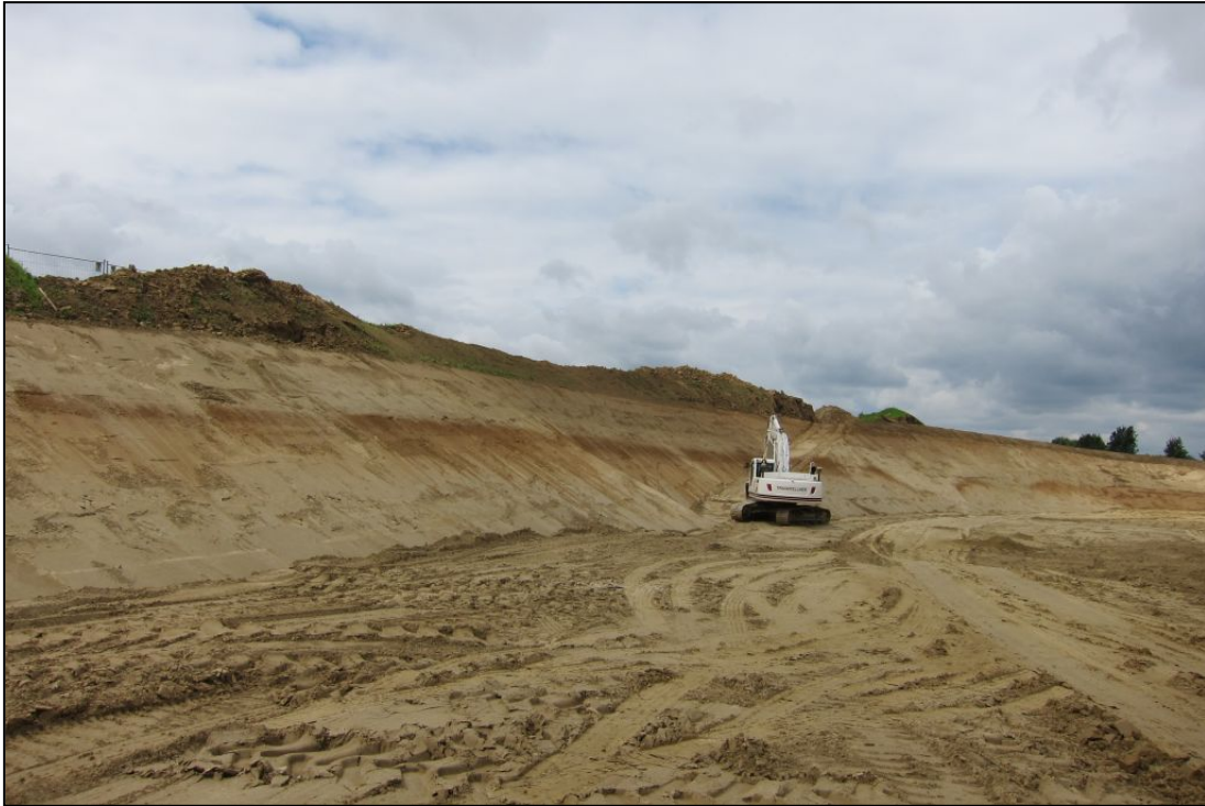
Abb. 2.3.2.4: Hanganschnitt an der Südseite der Baugrube im Überblick (Foto: M. Peresson)
