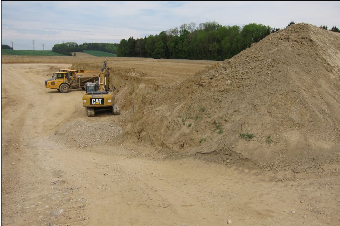
Abb. 2.3.1.22: Baufahrzeuge der FA Bernegger Bau (Molln, Foto: M. Peresson)
