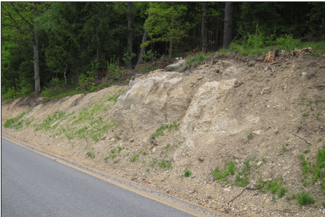
Abb. 2.1.2.8: Hanganschnitt am Güterweg Pehersdorf in geklüftetem, stark verwittertem, vergrustem Weinsberger Granit (Foto: M. Peresson).
