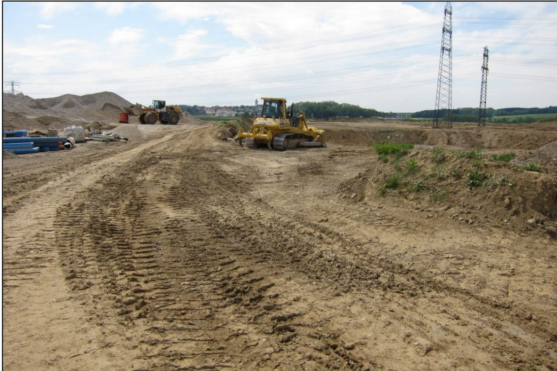
Abb.2.3.1.30: In Betrieb stehende Kiesgrube mit Radladern an der B309 Steyrer Bundesstraße im Mai 2012 (Foto: M. Peresson)
