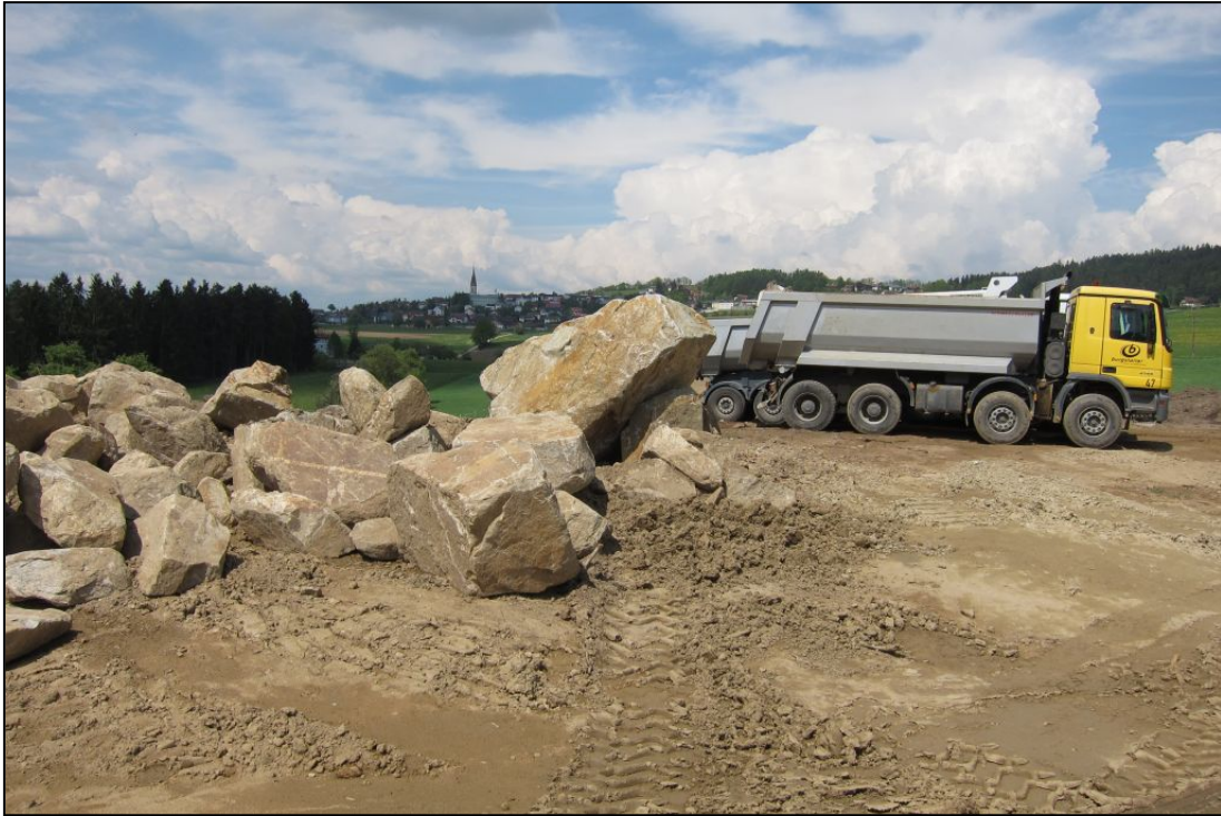
Abb. 2.1.1.6: Blöcke aus verwittertem Weinsberger Granit im Bereich des Nordportals des Tunnels Götschka (Foto: M. Peresson).
