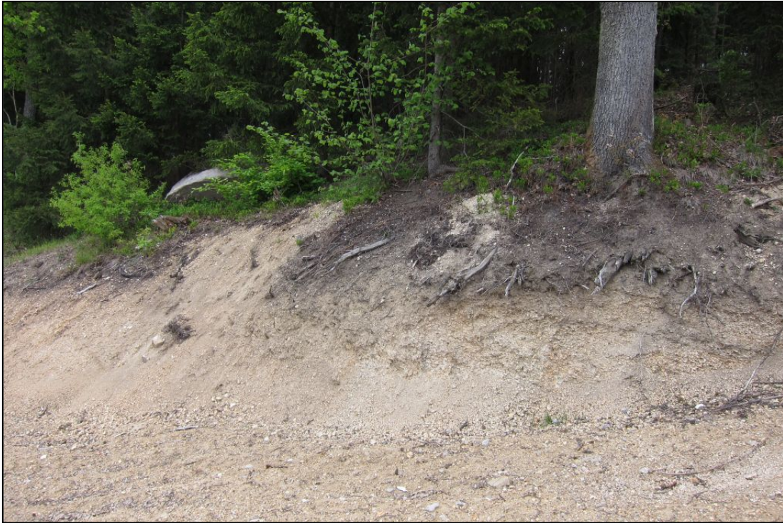
Abb. 2.1.2.9: Hanganschnitt am Güterweg Pehersdorf in vergrustem, kaolinitisierten Weinsberger Granit (Foto: M. Peresson).
