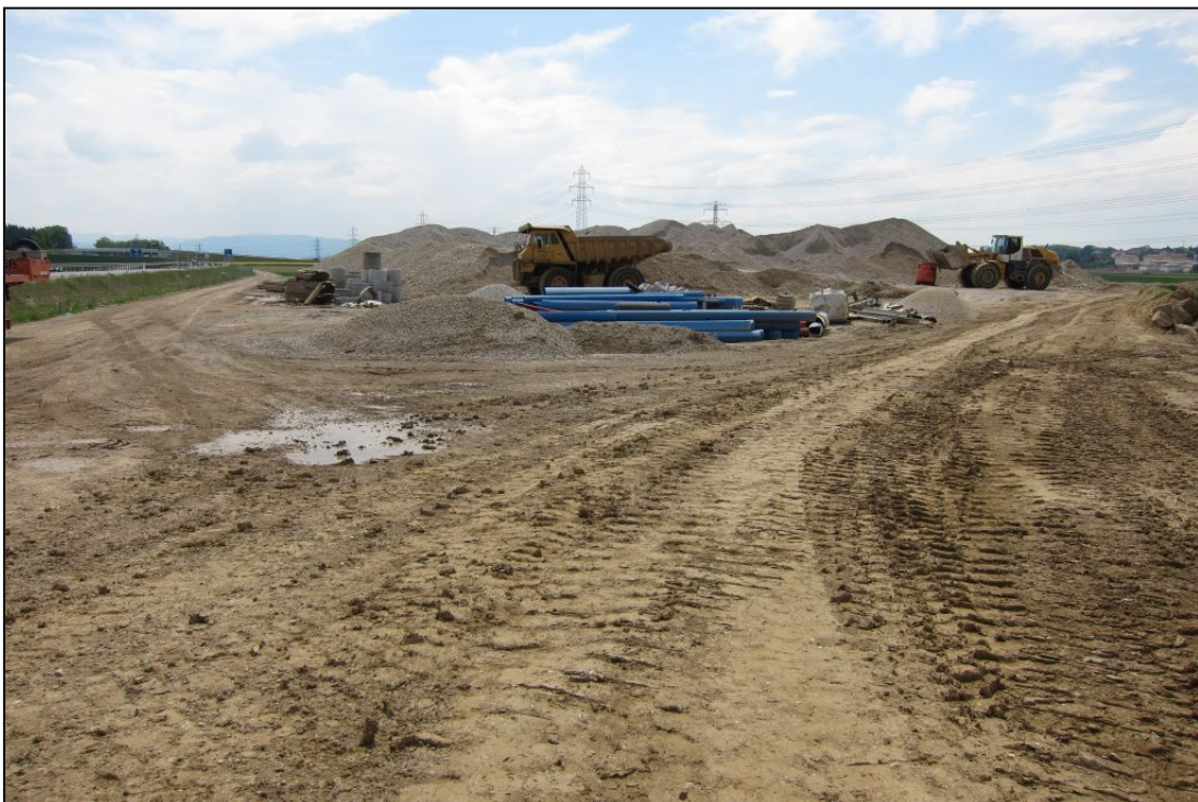
Abb.2.3.1.29: Bautätigkeit in der Kiesgrube mit drei Radladern und einem LKW-Kipper an der B309 Steyrer Bundesstraße im Mai 2012 (Foto: M. Peresson)
