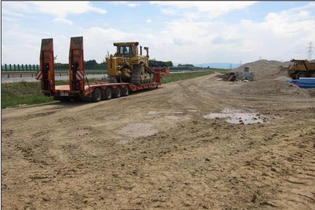
Abb. 2.3.1.28: Lage der Kiesgrube an der B309 Steyrer Bundesstraße im Mai 2012 (Foto: M. Peresson)
