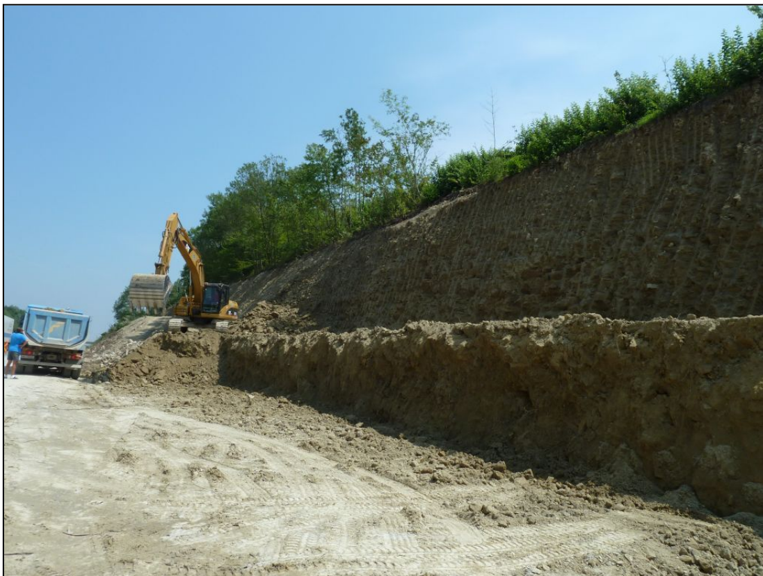
Abb. 2.2.1.16: Böschungsanschnitt aus rhythmisch gebankter Otttnang-Formation südlich der Raststätte Aistersheim (Foto: M. Peresson).
