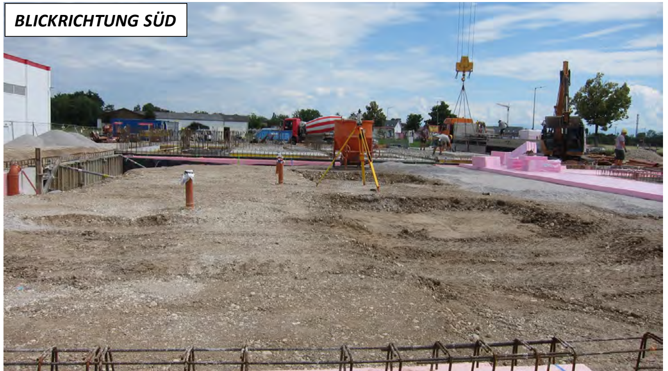
Abb. 2.2.4.5.: Baugrube in Wels, Wallerer Straße: Überblick - Bauaushub für einen Baumarkt: Kiese der Niederterrasse in sandiger Matrix (Foto: M. Peresson).
