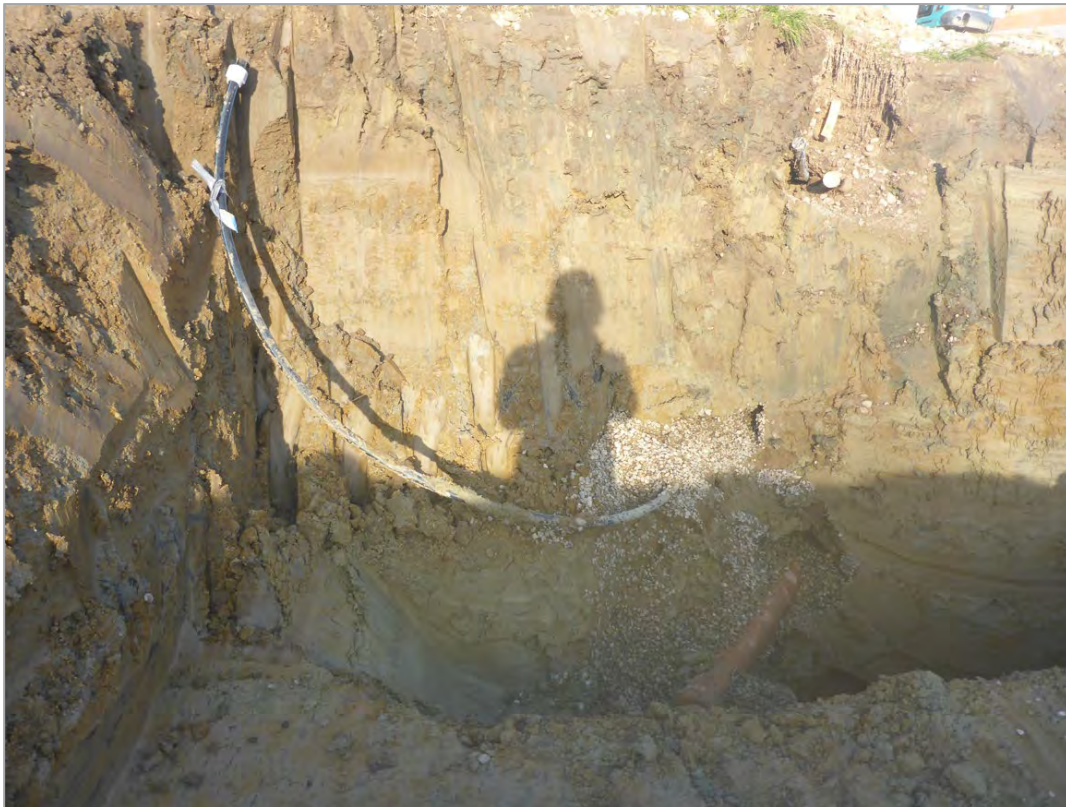
Abb. 2.1.4.6: Baugrube in Niedergrafing: Am Top des Hanganschnittes (bis 2m Mächtigkeit) sind tonige Silte zu erkennen, die als Löss-Lehm (bzw. Solifluktuationsablagerung) interpretiert werden (Foto: F. Hofmayer).
