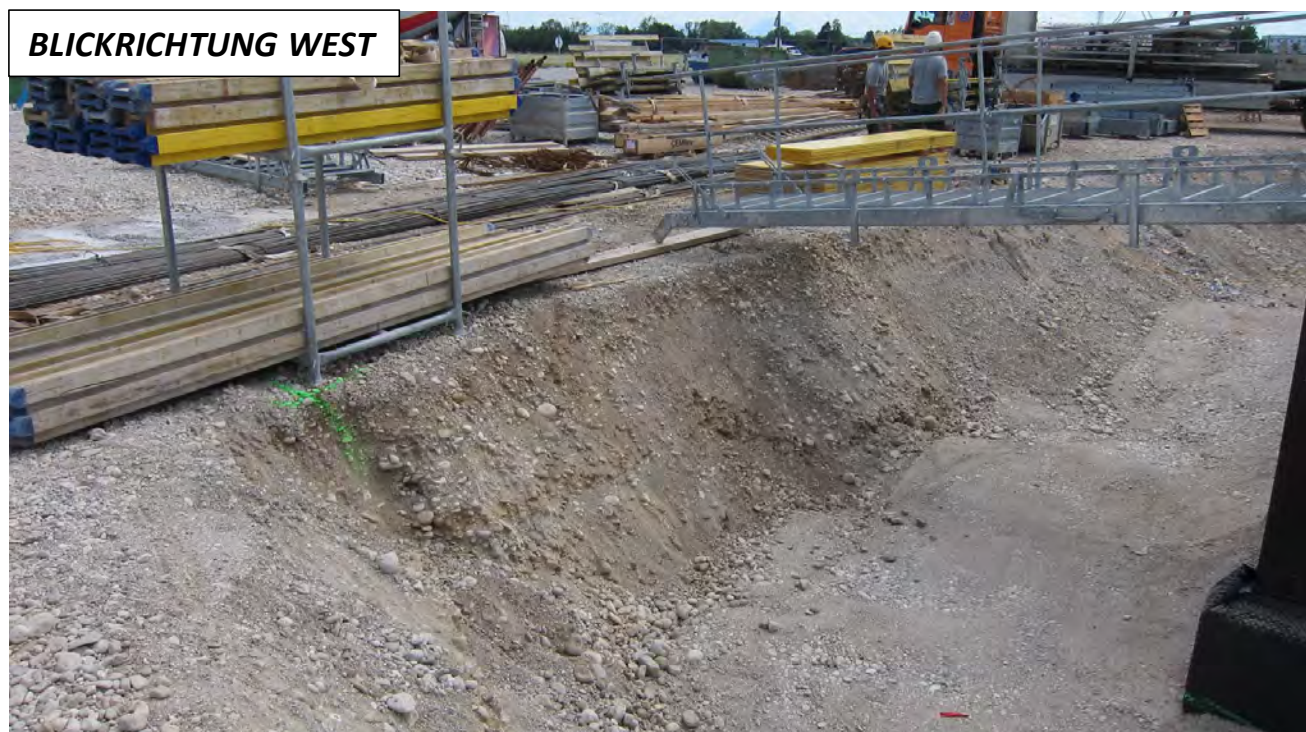
Abb. 2.2.4.7.: Baugrube in Wels, Wallerer Straße : Zwei Meter mächtige Grob- bis Mittelkiese der Niederterrasse in sandiger Matrix; nahezu unverwittert (Foto: M. Peresson).
