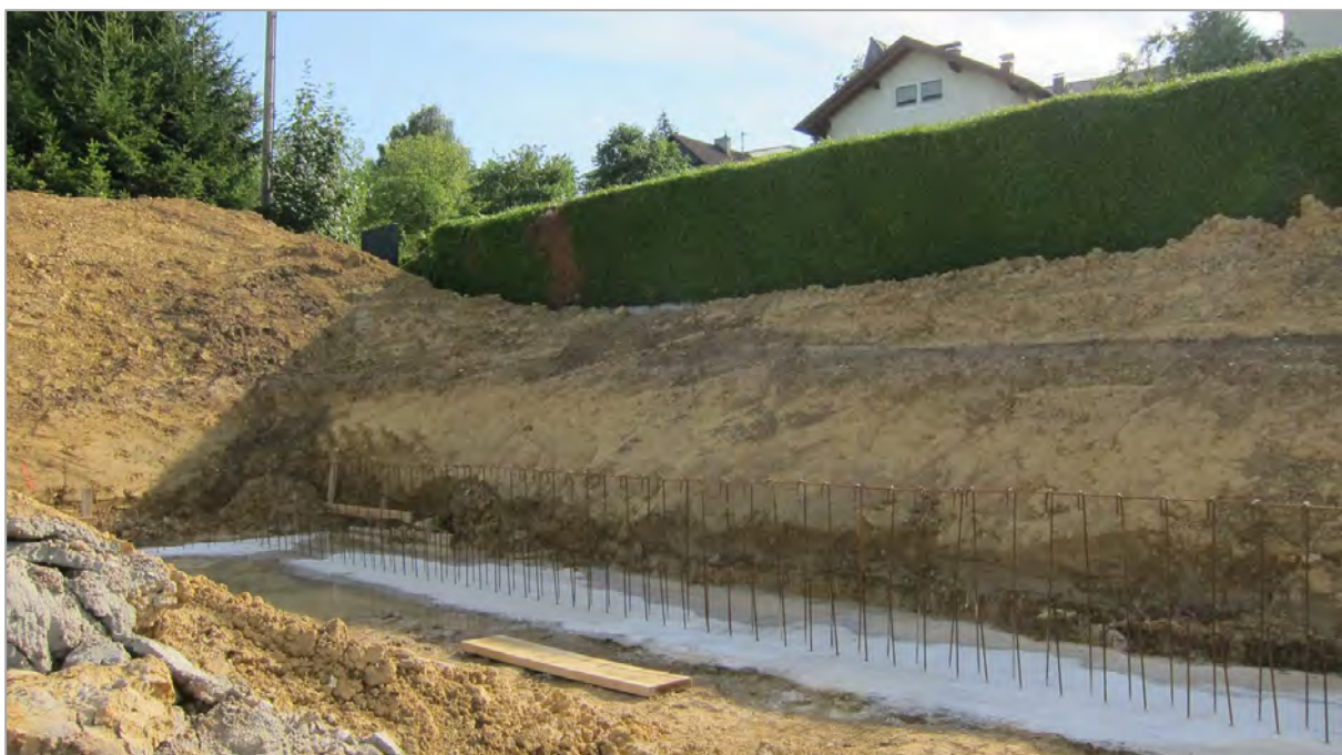
Abb. 2.1.1.23: Baustelle für ein Einfamilienhaus in Sierning: 2,5m hoher Hanganschnitt aus quartären karbonatfreien Deckschichten (Löss-Lehm) (Foto: M. Peresson).
