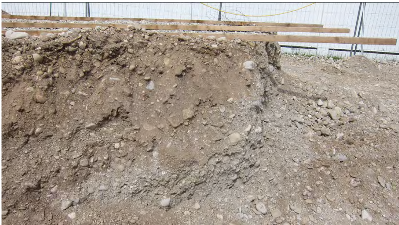
Abb. 2.2.4.10.: Baugrube in Wels, Wallerer Straße : Zwei Meter mächtige Grob- bis Mittelkiese der Niederterrasse in sandiger Matrix; Einregelung der Komponenten und lagiger Aufbau der Sedimentablagerungen erkennbar (Foto: M. Peresson).
