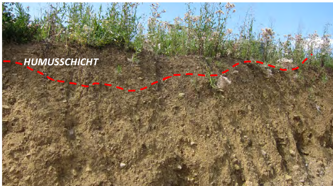
Abb. 2.2.3.10.: Baustelle „Reihenhaussiedlung in Kremsmünster: obere Etage; Gemisch aus Kies, Steinen und Blöcken in sandig, schluffiger Matrix; wellig ausgebildete Humusschicht (Foto: M. Peresson).
