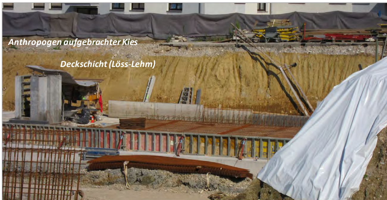
Abb. 2.1.1.6: Baustelle für eine Wohnhausanlage in Sierning; Hanganschnitt Ostseite: am Top gelbliche schluffig, sandige Deckschicht, ca. 3m mächtig (Foto: M. Peresson).
