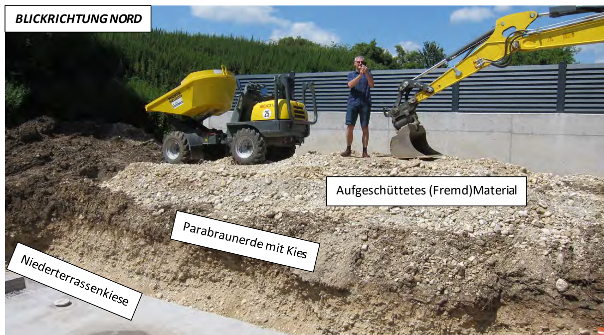
Abb. 2.2.2.5.: Baustellengelände in Wels, Oberhaid: am Top Parabraunerde, gefolgt von Niederterrassenkiesen (Foto: M. Peresson).
