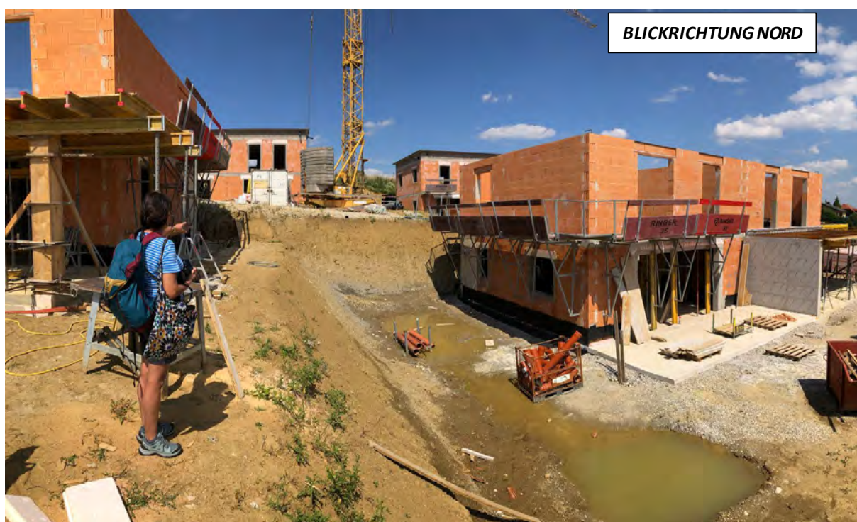
Abb. 2.2.3.7.: Überblick über das Baustellengelände (Reihenhaussiedlung) in Kremsmünster (Foto: H. Peresson).
