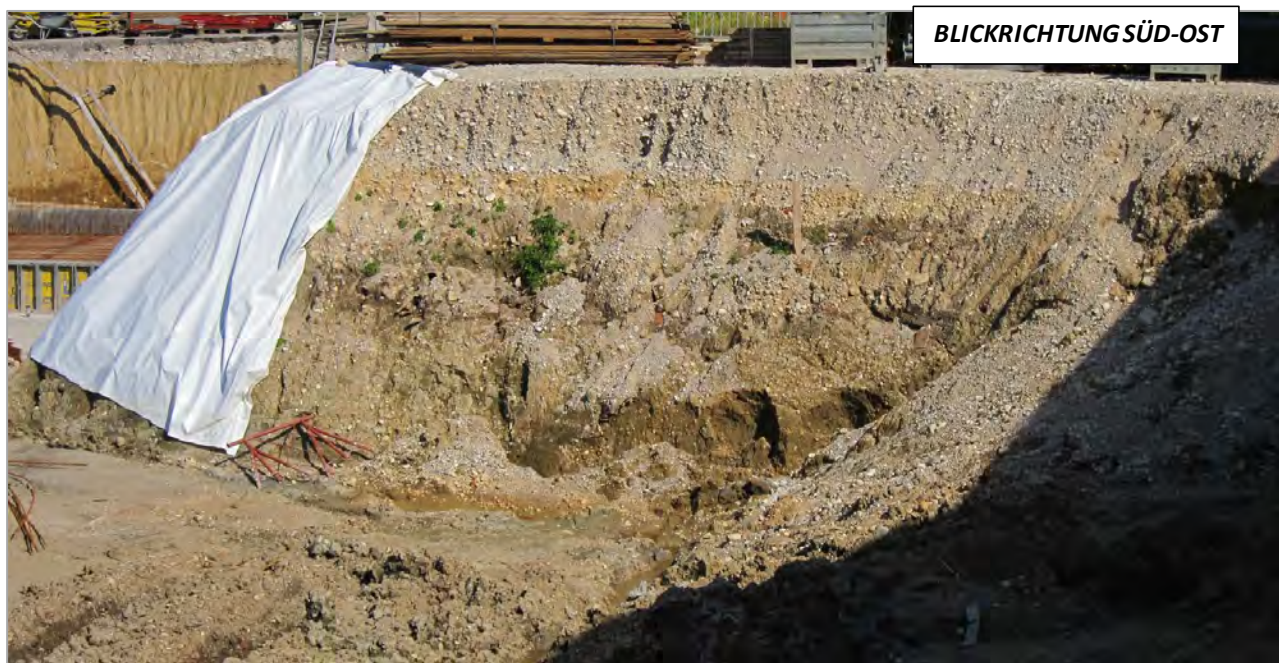
Abb. 2.1.1.7.: Baustelle für eine Wohnhausanlage in Sierning: schlecht sortierte Mittel-Feinkiese in sandiger Matrix (Ältere Deckenschotter) (Foto: M. Peresson).
