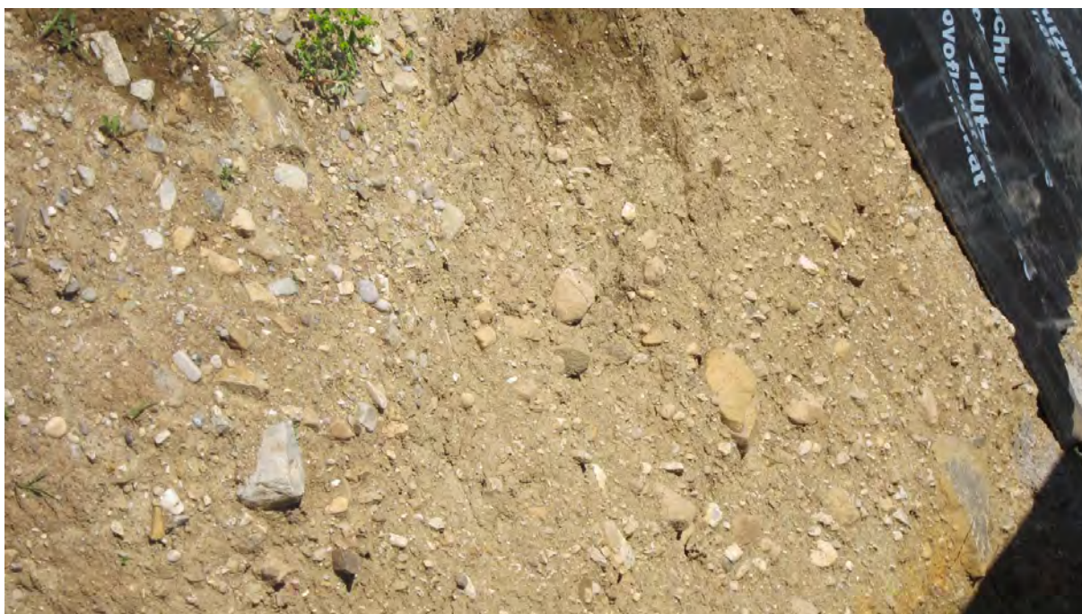
Abb. 2.2.3.25.: Baustelle „Wohnhausanlage in Kremsmünster“: Südseite des ersten Wohnhauskomplexes: Gemisch aus Kies, Steinen und Blöcken in sandig, schluffiger Matrix; Driftblöcke aus Flyschsandstein (Foto: M. Peresson).
