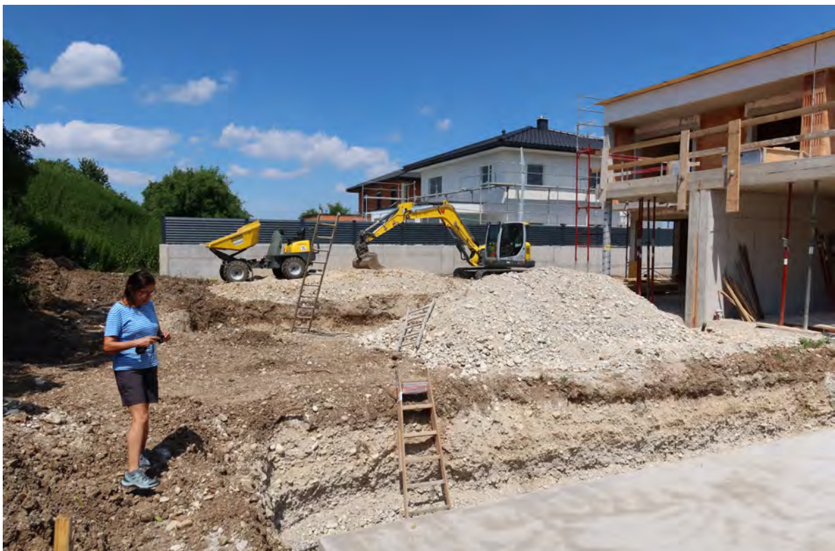
Abb. 2.2.2.11: Baustellengelände in Wels, Oberhaid: Parabraunerdehorizont am Top; die Niederterrassenkiesen zeigen im Hangenden chaotische Ablagerungen (Foto: H. Peresson).
