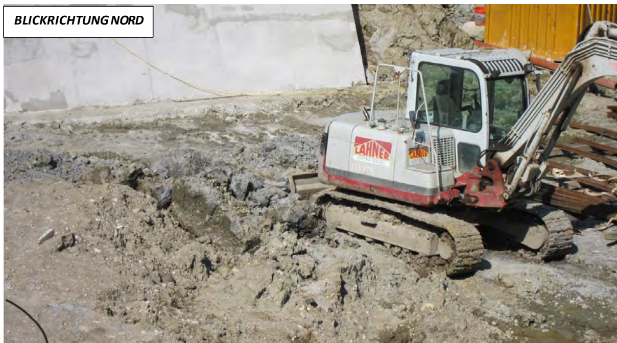
Abb. 2.1.1.8: Baustelle für eine Wohnhausanlage in Sierning: dunkelgrauer Schluff (Robulusschlier) anstehend in der Baugrube und an der Nordwand (Foto: M. Peresson).
