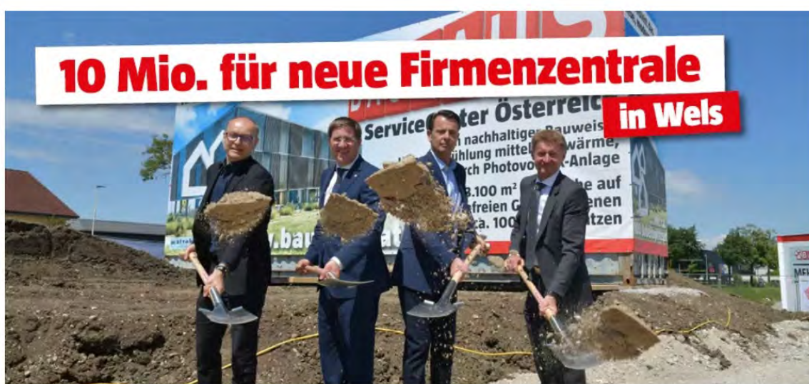
Abb. 2.2.4.1. Neues Servicecenter für das Bauhaus in Wels.
