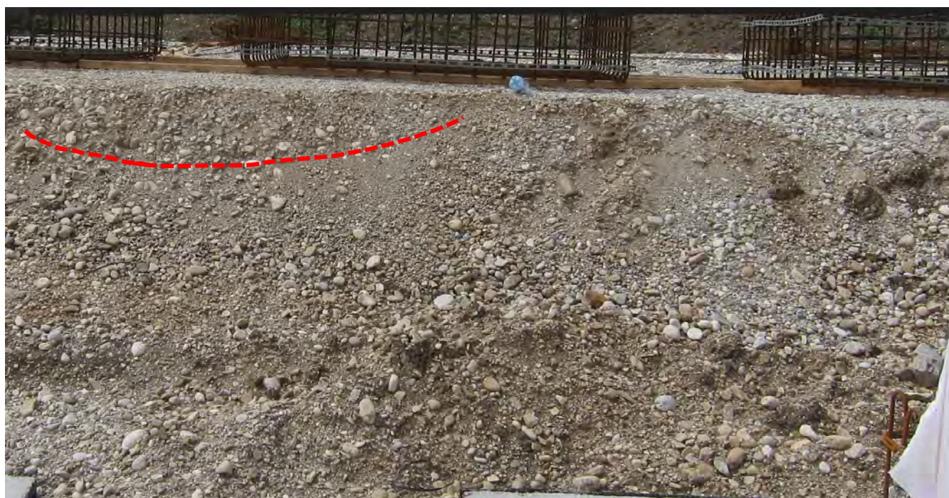
Abb. 2.2.4.9.: Baugrube in Wels, Wallerer Straße : Zwei Meter mächtige Grob- bis Mittelkiese der Niederterrasse in sandiger Matrix; Rollkieslage mit weitgehend fehlender Matrix in der Mitte des Hanganschnittes; am Top eventuell auch Rinnenbildung (Foto: M. Peresson).
