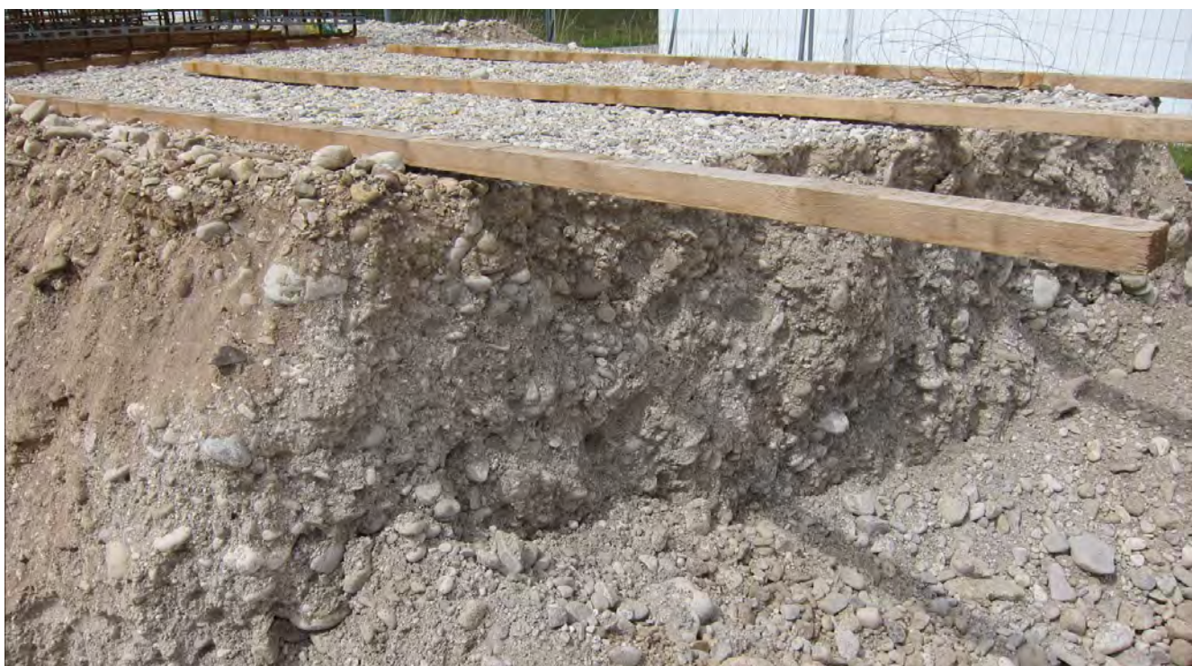
Abb. 2.2.4.11.: Baugrube in Wels, Wallerer Straße : Zwei Meter mächtige Grob- bis Mittelkiese der Niederterrasse in sandiger Matrix; lagiger Aufbau der überwiegend karbonatischen Komponenten erkennbar (Foto: M. Peresson).
