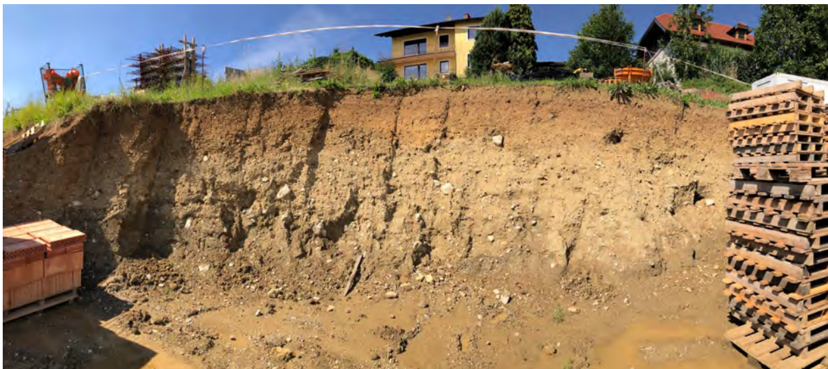
Abb. 2.2.3.28.: Baustelle „Wohnhausanlage in Kremsmünster“: Ostseite im hinteren Teil des Baugeländes Wohnhauskomplexes: am Top ein rötlicher Verlehmungshorizont; im hangenden Gemisch aus Kies, Steinen und Blöcken in sandig, schluffiger Matrix; einzelne Driftblöcke (Foto: M. Peresson).
