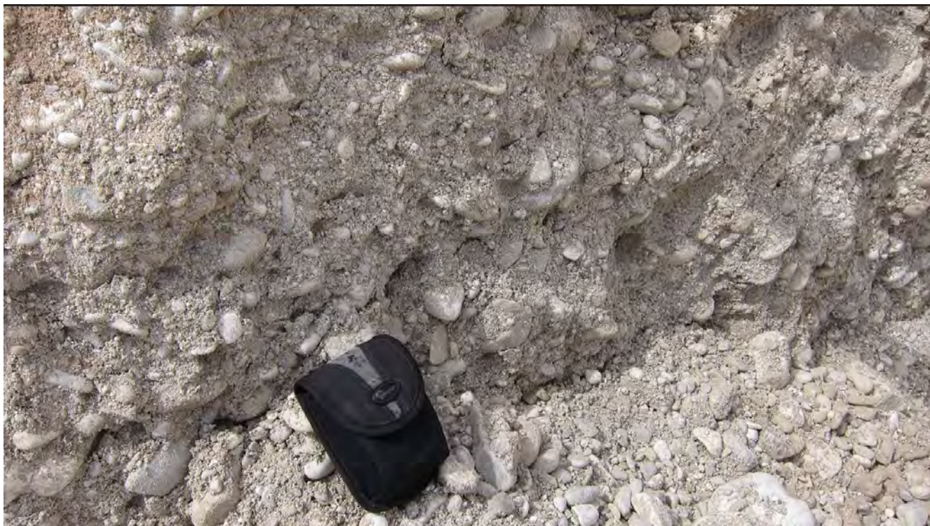
Abb. 2.2.4.12.: Baugrube in Wels, Wallerer Straße : Zwei Meter mächtige Grob- bis Mittelkiese der Niederterrasse in sandiger Matrix; überwiegend karbonatische Komponenten mit Durchmessern bis zu 10 cm (Foto: M. Peresson).
