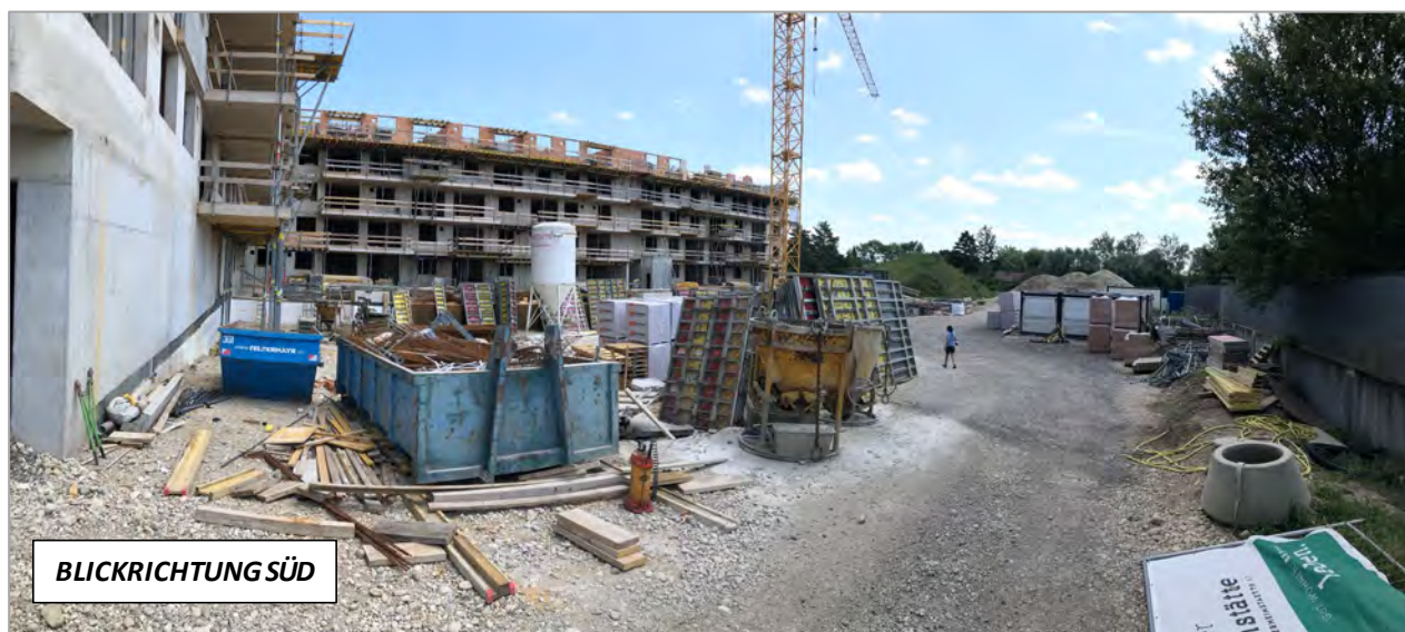
Abb. 2.2.4.16.: Baustelle „Welser Heimatstätte“: Überblicksaufnahme (Foto: H. Peresson).
