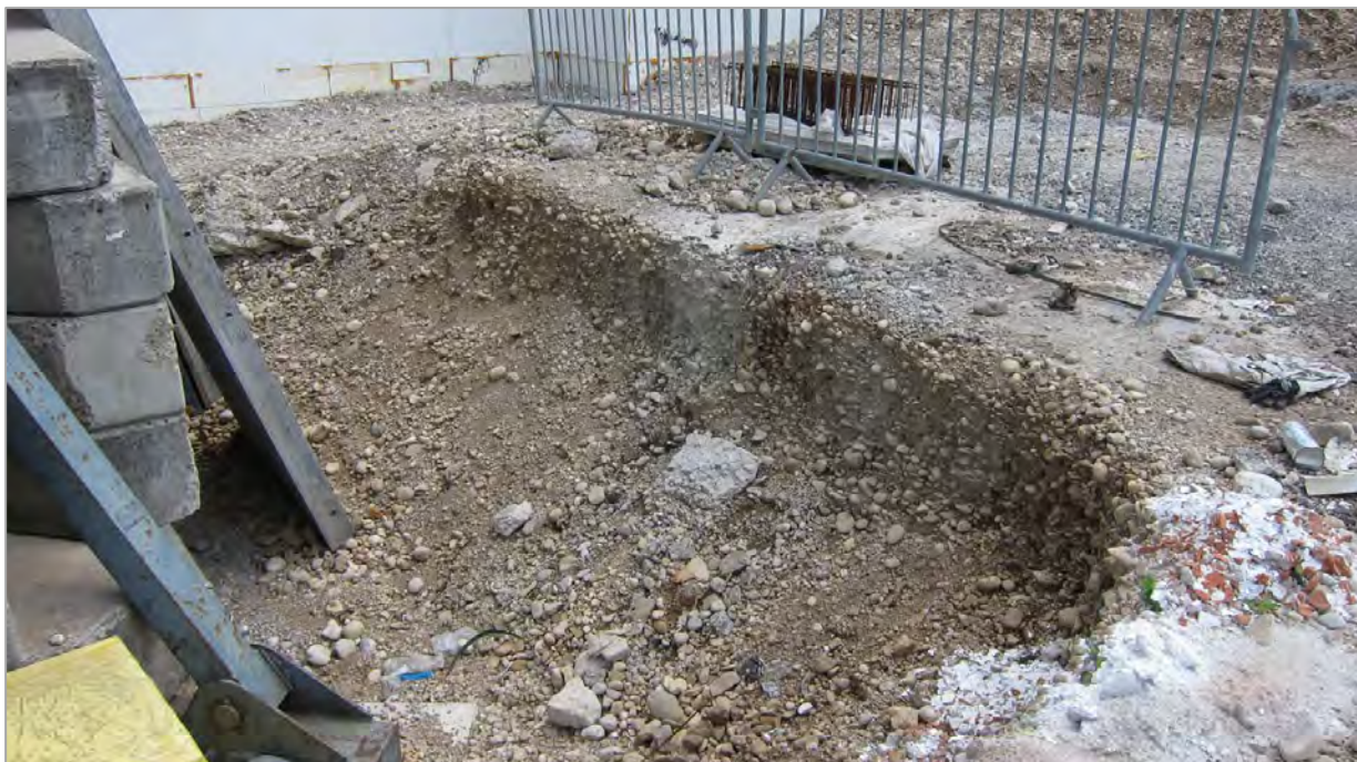
Abb. 2.2.4.17.: Baustelle „Welser Heimatstätte“: grau-braune, stark sandige Kiese der Niederterrasse (Foto: M. Peresson).
