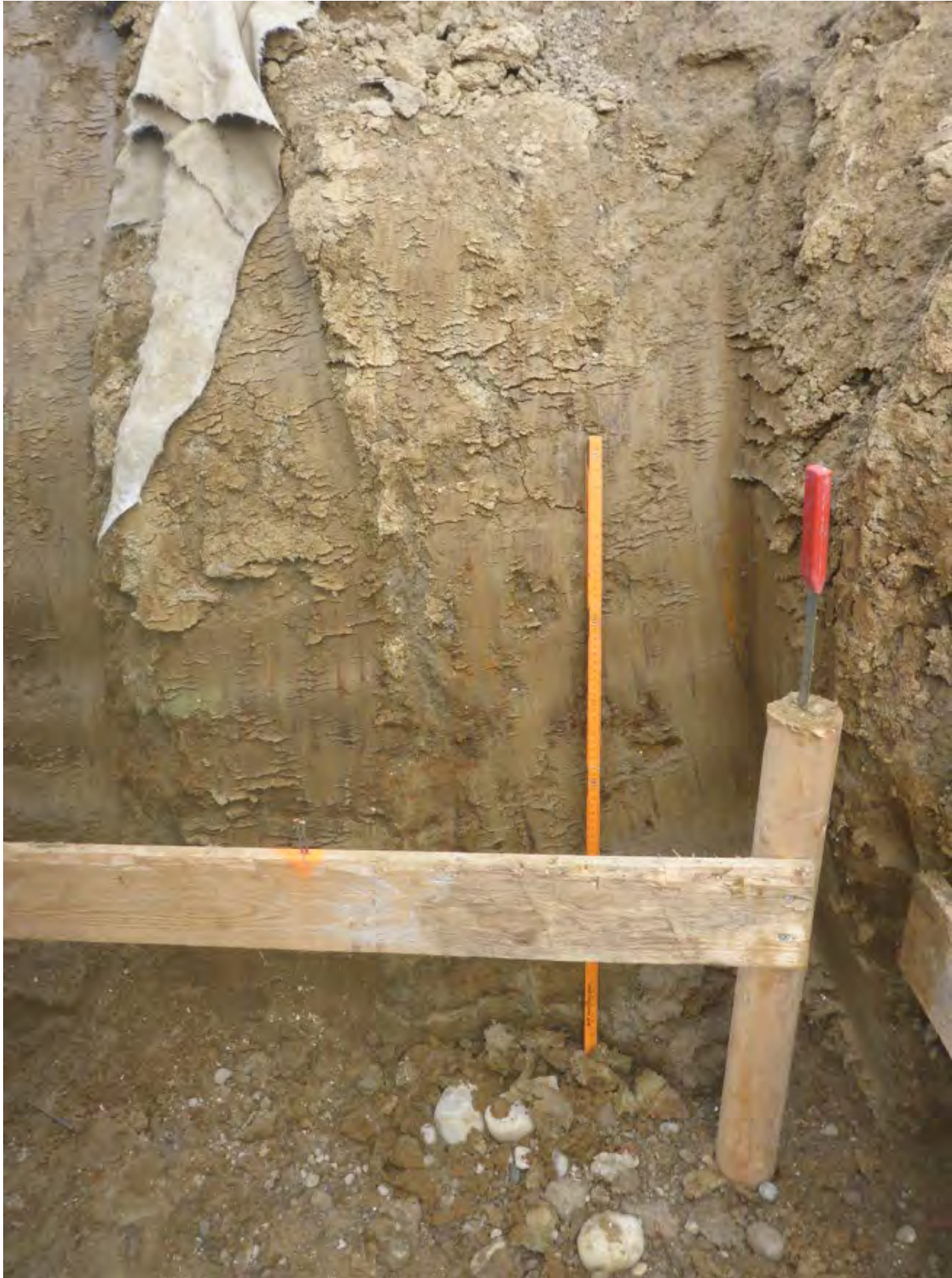
Abb. 2.1.3.9: Baugrube in Sommerfeld, Schlatten: Tiefgründig verwitterte Kletzenmarkt-Glaukonitsand-Formation im Hanganschnitt, Südostseite (Foto: F. Hofmayer).
