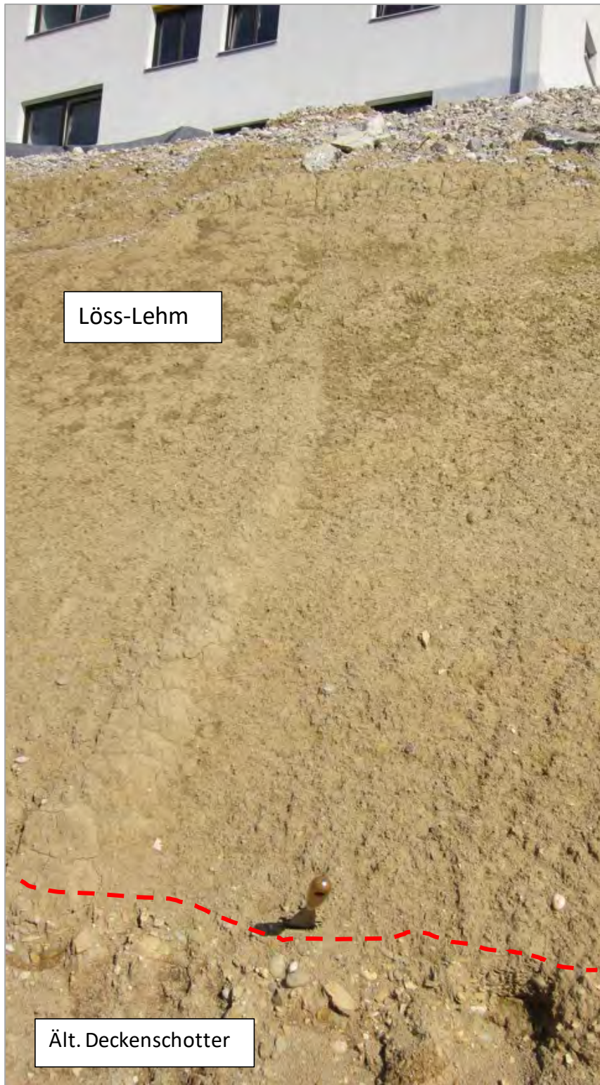
Abb. 2.1.1.12: Baustelle für eine Wohnhausanlage in Sierning: im Hangenden gelblicher Löss-Lehm (komplett strukturlos) mit Übergangsbereich zu Älteren Deckenschottern (Foto: M. Peresson).
