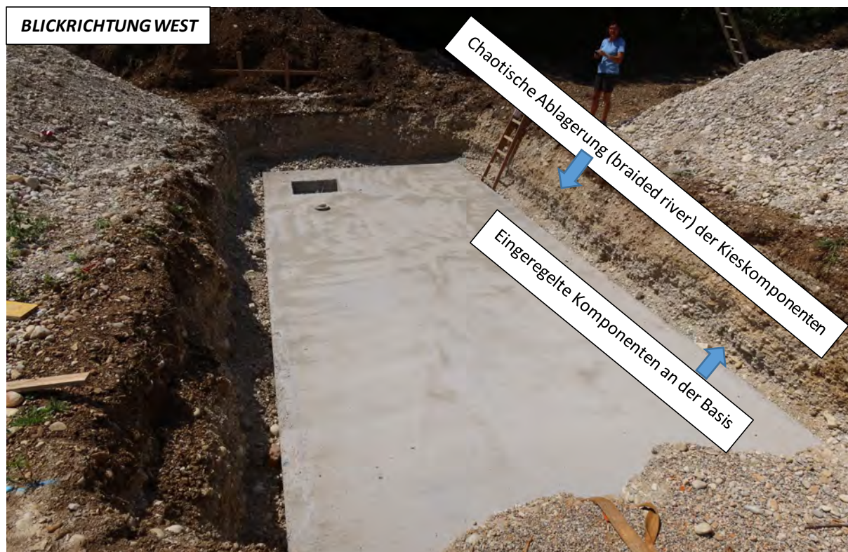
Abb. 2.2.2.6: Baustellengelände in Wels, Oberhaid: die Niederterrassenkiesen zeigen eine Gliederung in zwei Abschnitte; an der Basis eingeregelt Komponenten, im Hangenden chaotische Ablagerungen (Foto: M. Peresson).
