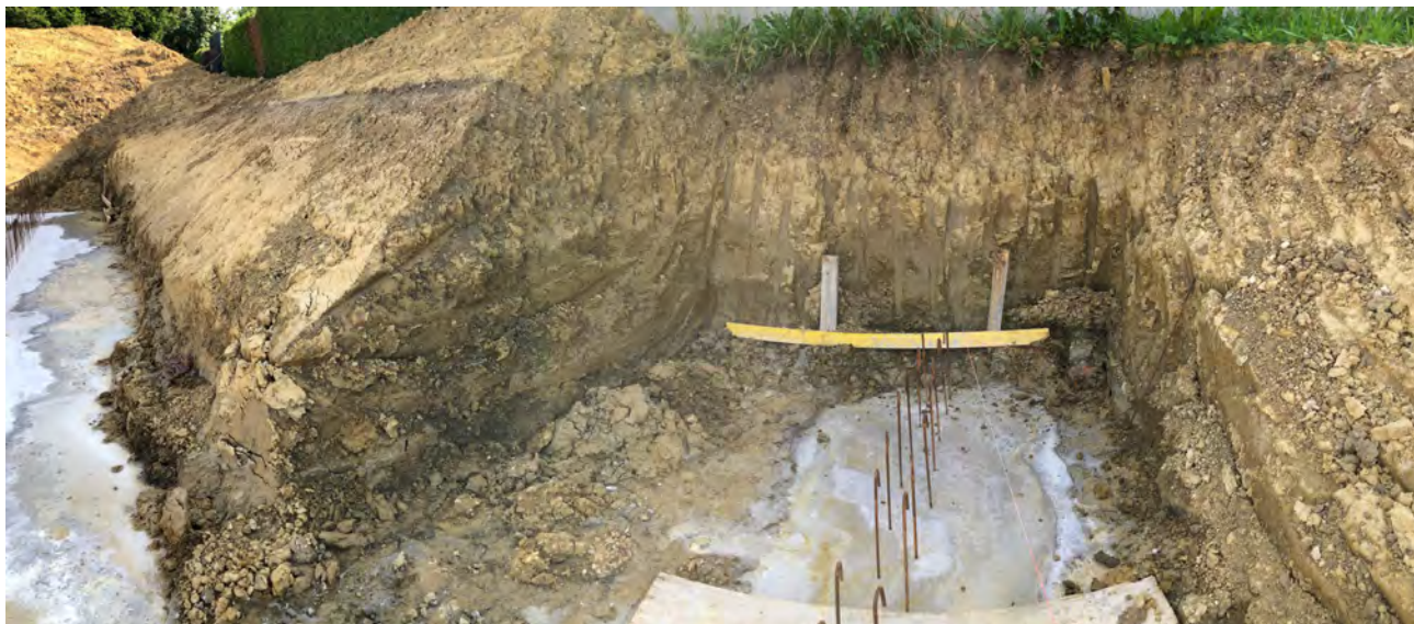
Abb. 2.1.1.24: Baustelle für ein Einfamilienhaus in Sierning: 2,5m hoher Hanganschnitt aus quartären karbonatfreien Deckschichten (Löss-Lehm); am Top ein dunkelbrauner Bodenhorizont (Foto: M. Peresson).
