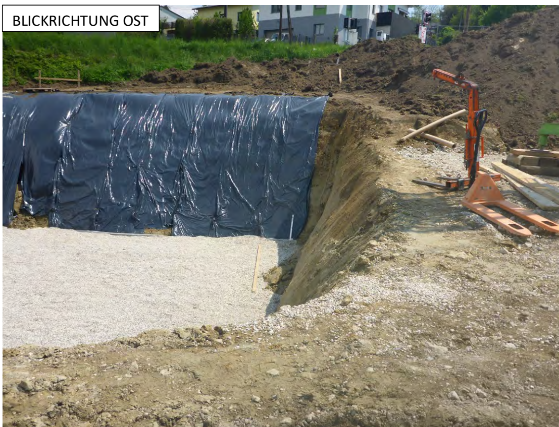
Abb. 2.2.1.7.: Überblicksaufnahme Baugrube in Straßham (F. Hofmayer).
