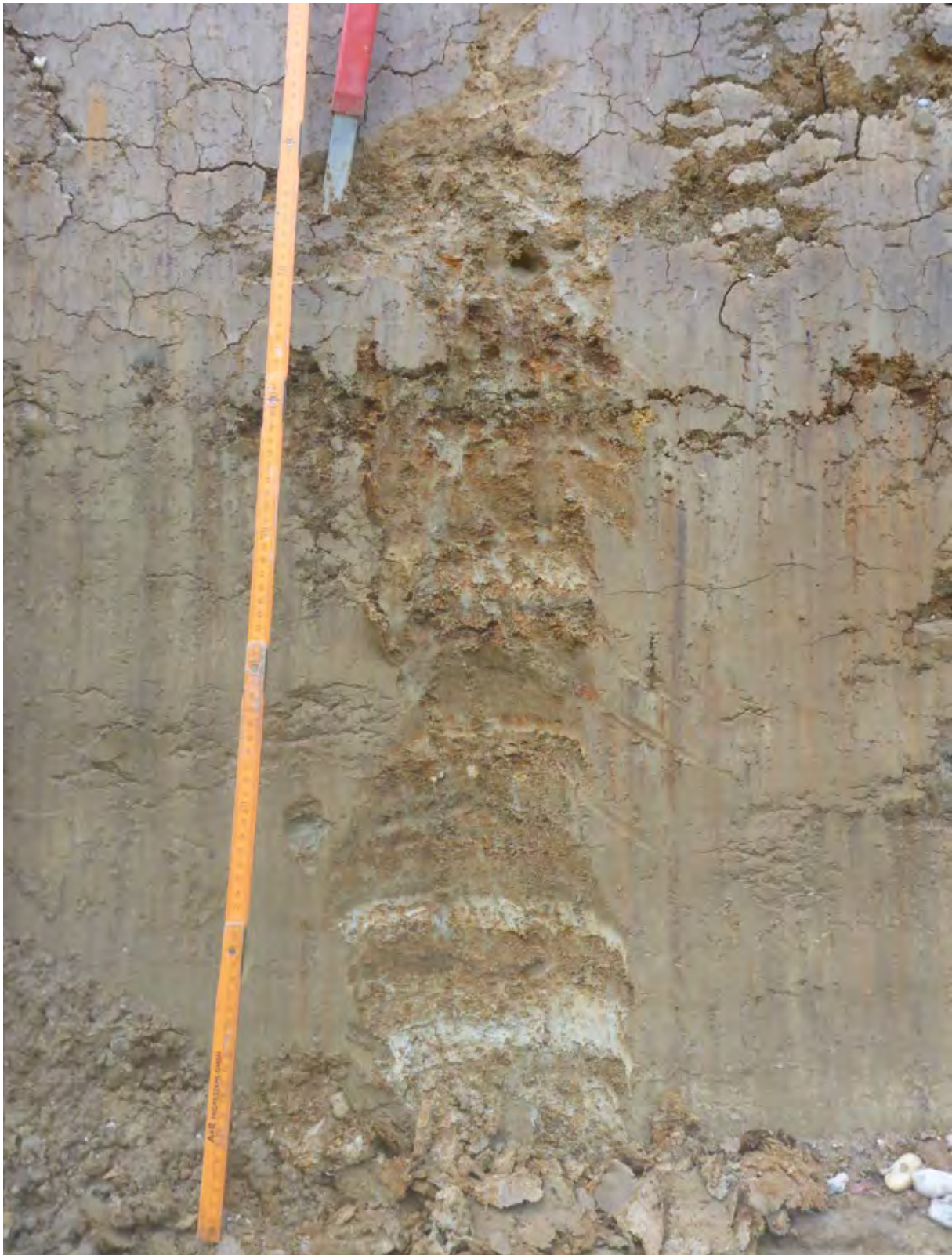
Abb. 2.1.3.10.: Baugrube in Sommerfeld, Schlatten: Tiefgründig verwitterte Kletzenmarkt-Glaukonitsand-Formation im Hanganschnitt, Südostseite (Foto: F. Hofmayer).
