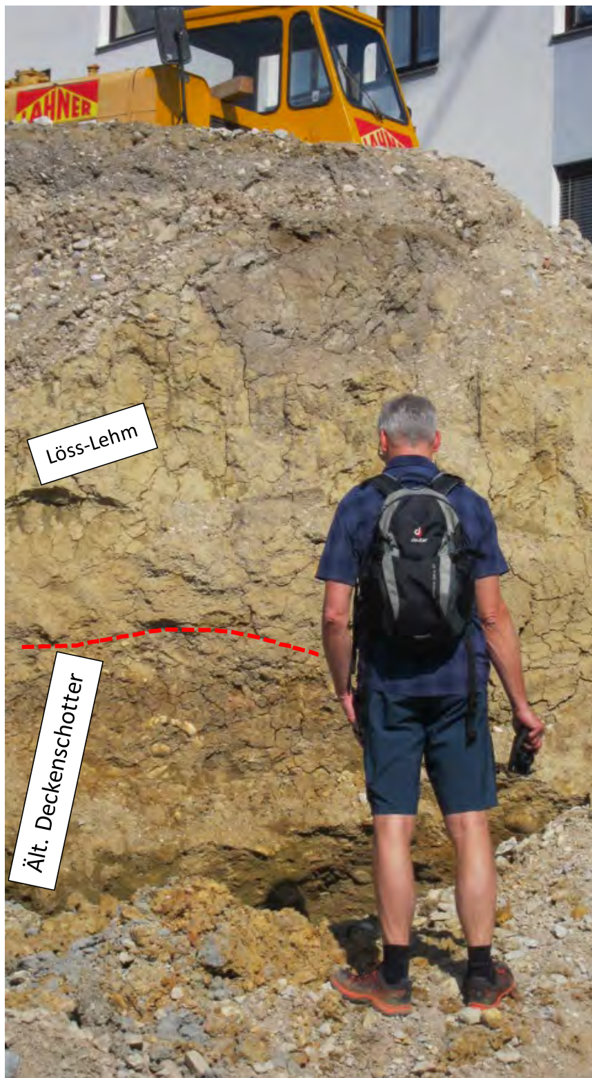
Abb. 2.1.1.10.: Baustelle für eine Wohnhausanlage in Sierning: im Hangenden gelblicher Löss-Lehm mit Übergangsbereich zu Älteren Deckenschottern (stark verkittet und verfestigt mit Matrix); Grenze diffus ausgebildet (Foto: M. Peresson).
