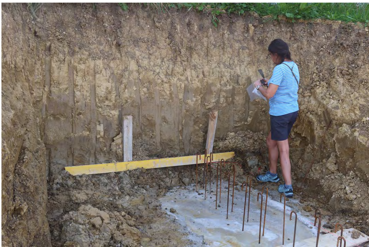
Abb. 2.1.1.25: Baustelle für ein Einfamilienhaus in Sierning: 2,5m hoher Hanganschnitt aus quartären karbonatfreien Deckschichten (Löss-Lehm); am Top ein dunkelbrauner Bodenhorizont (Foto: M. Peresson).
