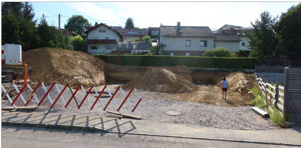
Abb. 2.1.1.22: Baustelle für ein Einfamilienhaus in Sierning: Überblicksaufnahme (Foto: H. Peresson).
