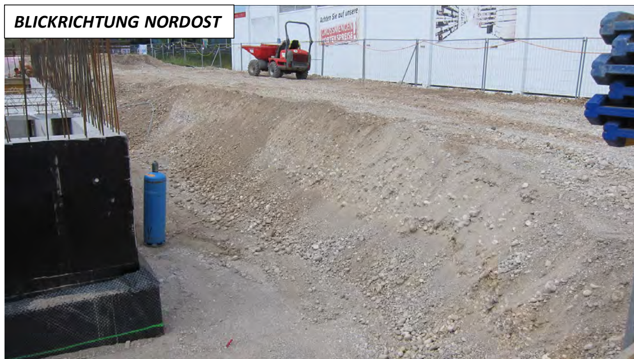
Abb. 2.2.4.6. : Baugrube in Wels, Wallerer Straße : Zwei Meter mächtige Grob- bis Mittelkiese der Niederterrasse in sandiger Matrix (Foto: M. Peresson).
