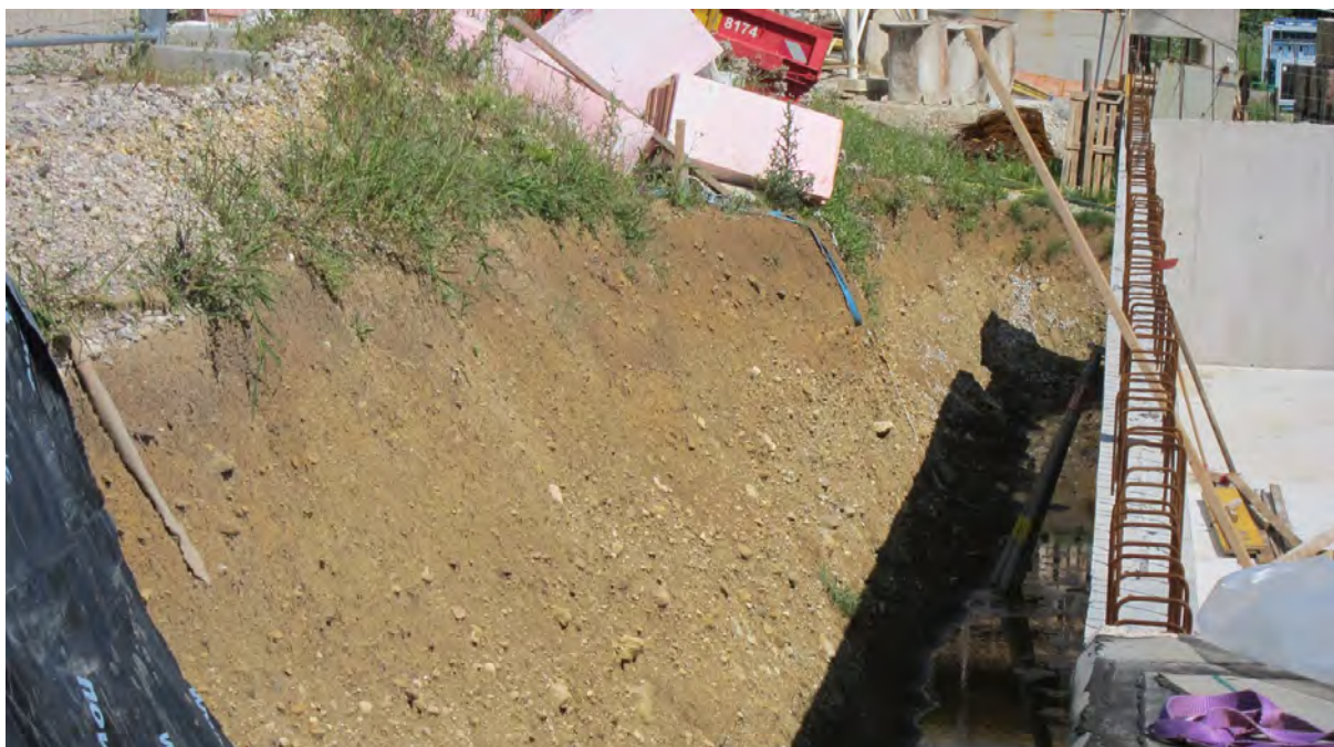
Abb. 2.2.3.24.: Baustelle „Wohnhausanlage in Kremsmünster: Südseite des ersten Wohnhauskomplexes: Gemisch aus Kies, Steinen und Blöcken in sandig, schluffiger Matrix; (Foto: M. Peresson).
