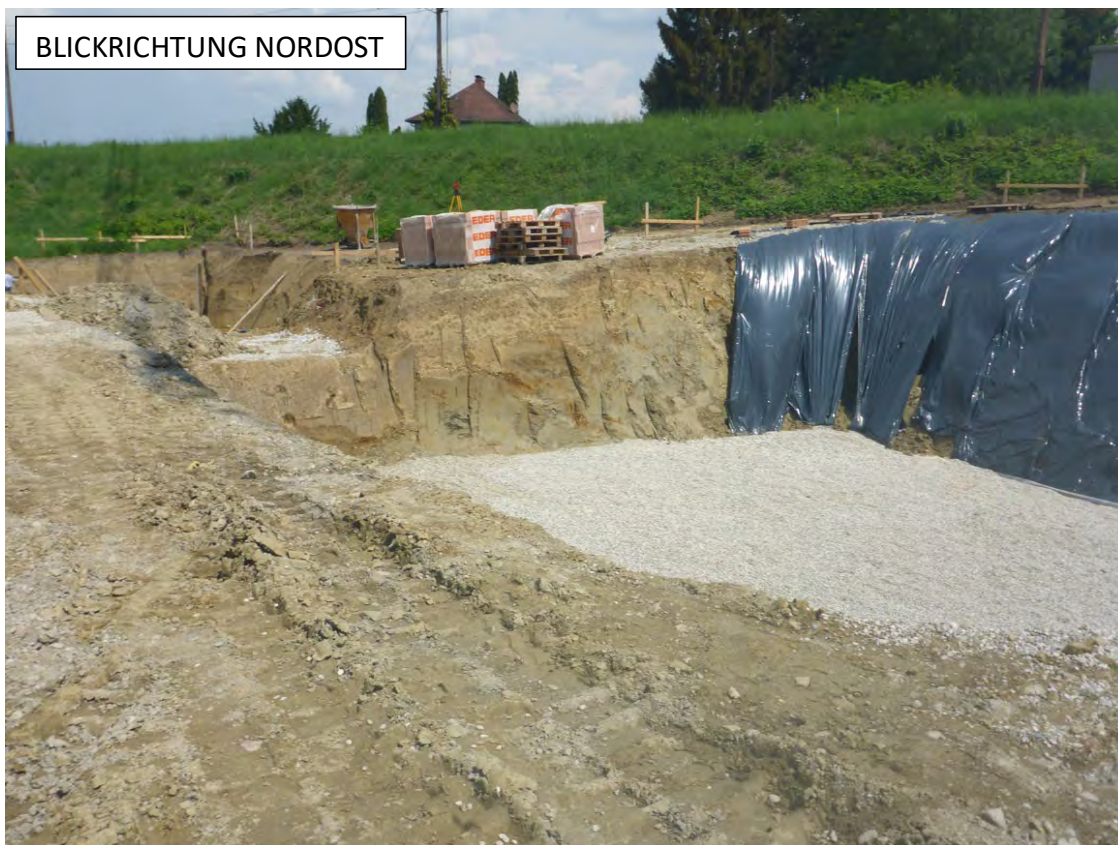
Abb. 2.2.1.6.: Überblicksaufnahme Baugrube in Straßham (F. Hofmayer).
