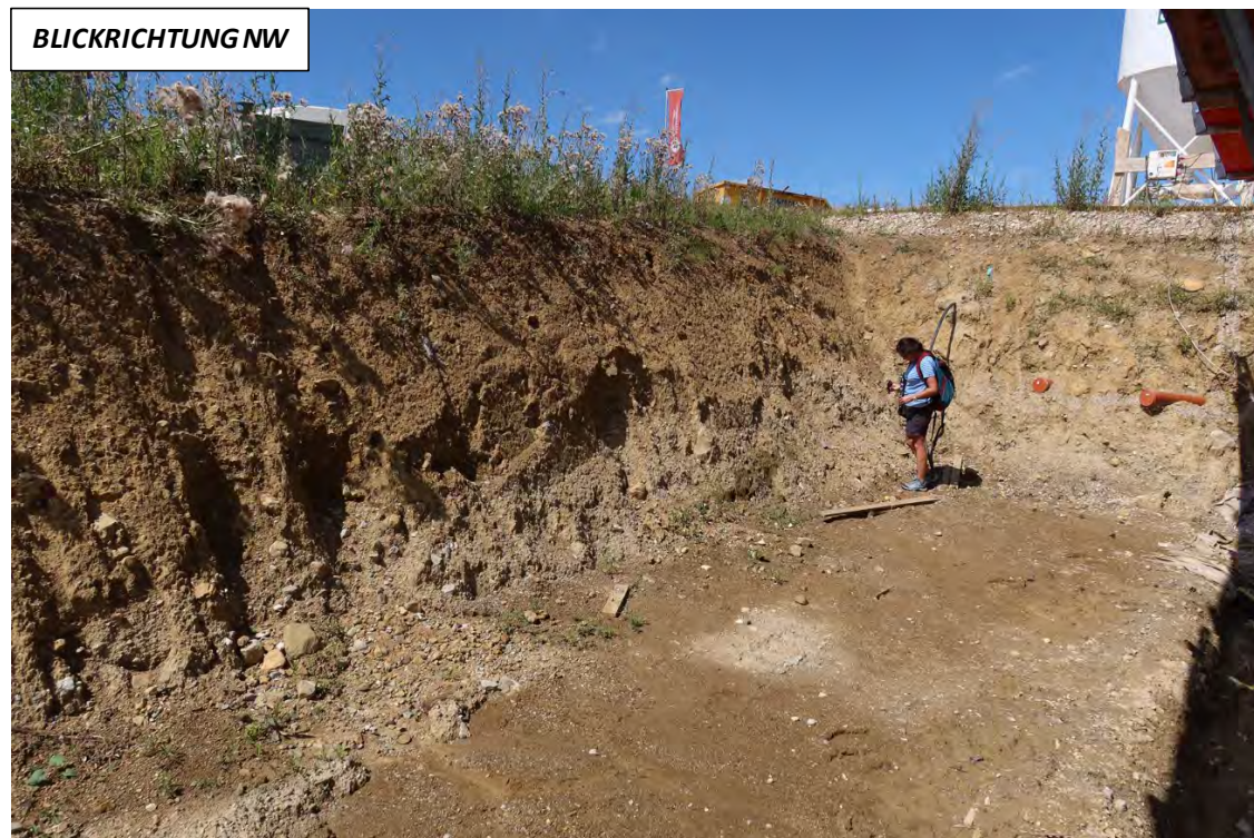
Abb. 2.2.3.8: Baustelle „Reihenhaussiedlung in Kremsmünster: obere Etage; Gemisch aus Kies, Steinen und Blöcken in sandig, schluffiger Matrix; rotbraune Farbgebung (Foto: H. Peresson).
