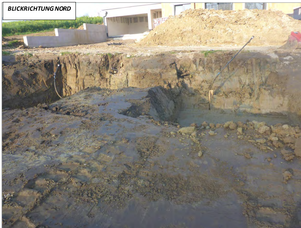
Abb. 2.1.4.4: Baugrube in Niedergraving: Überblicksaufnahme der bis zur 4m tiefen Baugrube (Foto: F. Hofmayer).
