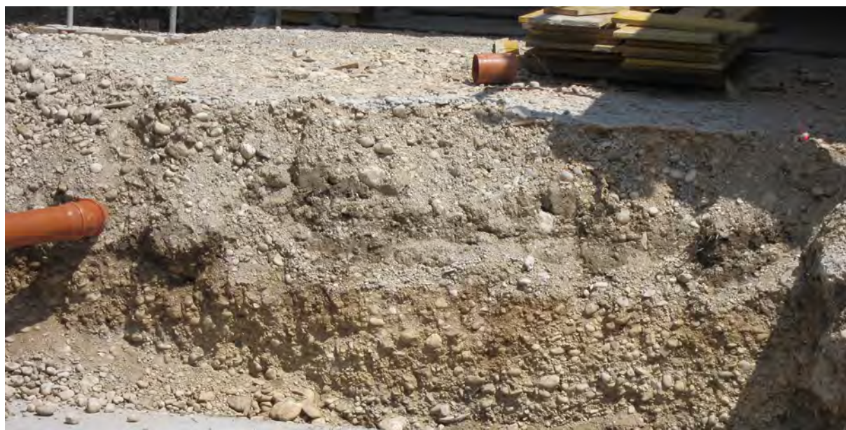
Abb. 2.2.2.7.: Baustellengelände in Wels, Oberhaid: Detailaufnahme der Niederterrassenkiesen mit chaotischen Gefüge; sandige Matrix zeigt Bereichsweise rötlich-braune Verfärbung (Foto: M. Peresson).
