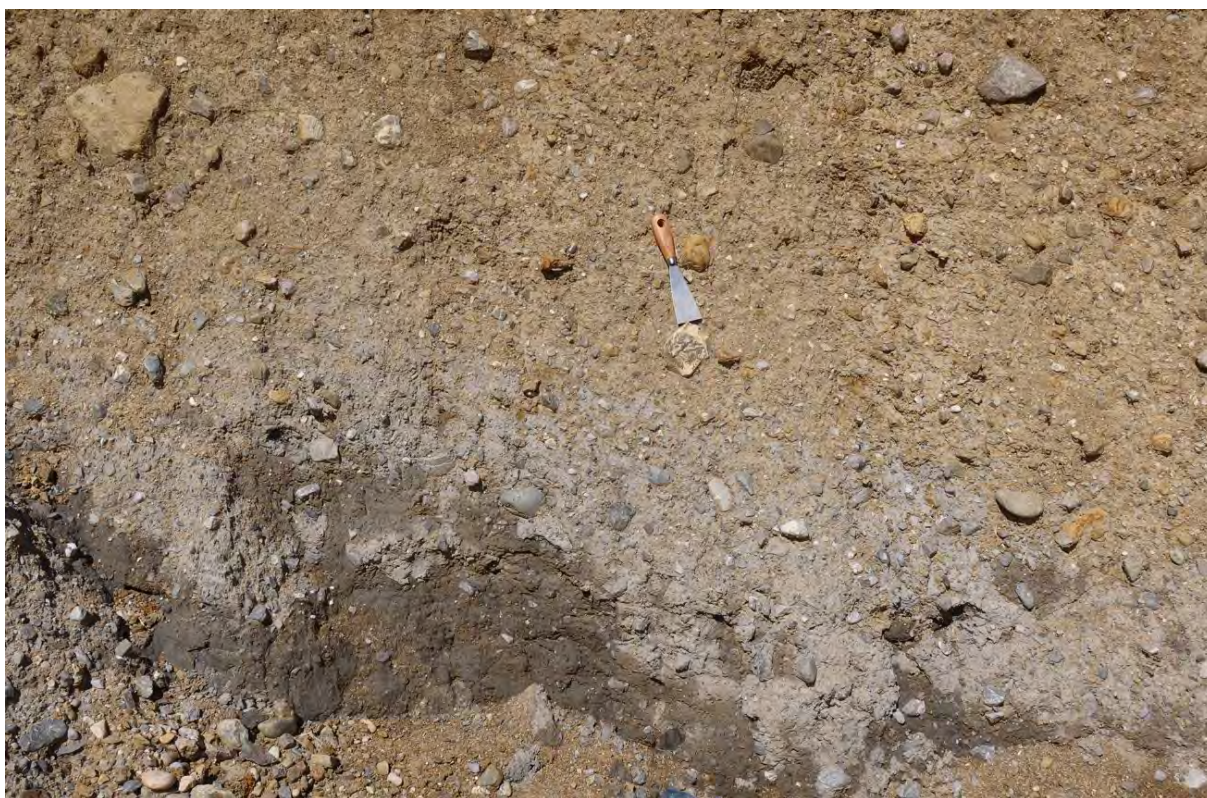
Abb. 2.2.3.17.: Baustelle „Reihenhaussiedlung in Kremsmünster: untere Etage; Detailaufnahme der Schlierbasis (Staunässe); erkennbar sind aufgearbeitete Flyschkomponenten im hangenden Abschnitt; (Foto: M. Peresson).
