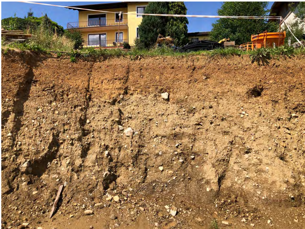
Abb. 2.2.3.30: Baustelle „Wohnhausanlage in Kremsmünster“: Ostseite im hinteren Teil des Baugeländes Wohnhauskomplexes: am Top ein rötlicher Verlehmungshorizont; im hangenden Gemisch aus Kies, Steinen und Blöcken in sandig, schluffiger Matrix; einzelne Driftblöcke (Foto: M. Peresson).
