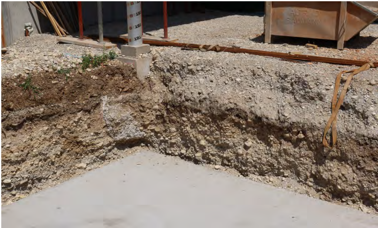
Abb. 2.2.2.10: Baustellengelände in Wels, Oberhaid: Parabraunerdehorizont am Top; die Niederterrassenkiesen zeigen im Hangenden chaotische Ablagerungen; an der Basis Einregelung der Komponenten (Foto: M. Peresson).
