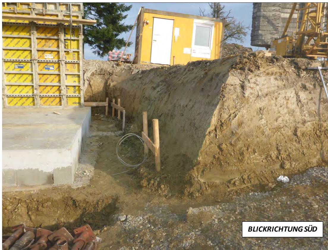
Abb. 2.1.3.8.: Baugrube in Sommerfeld, Schlatten: Überblicksaufnahme; 2m hoher Hanganchnitt aus verwitterter Kletzenmarkt-Glaukonitsand-Formation (Foto: F. Hofmayer).
