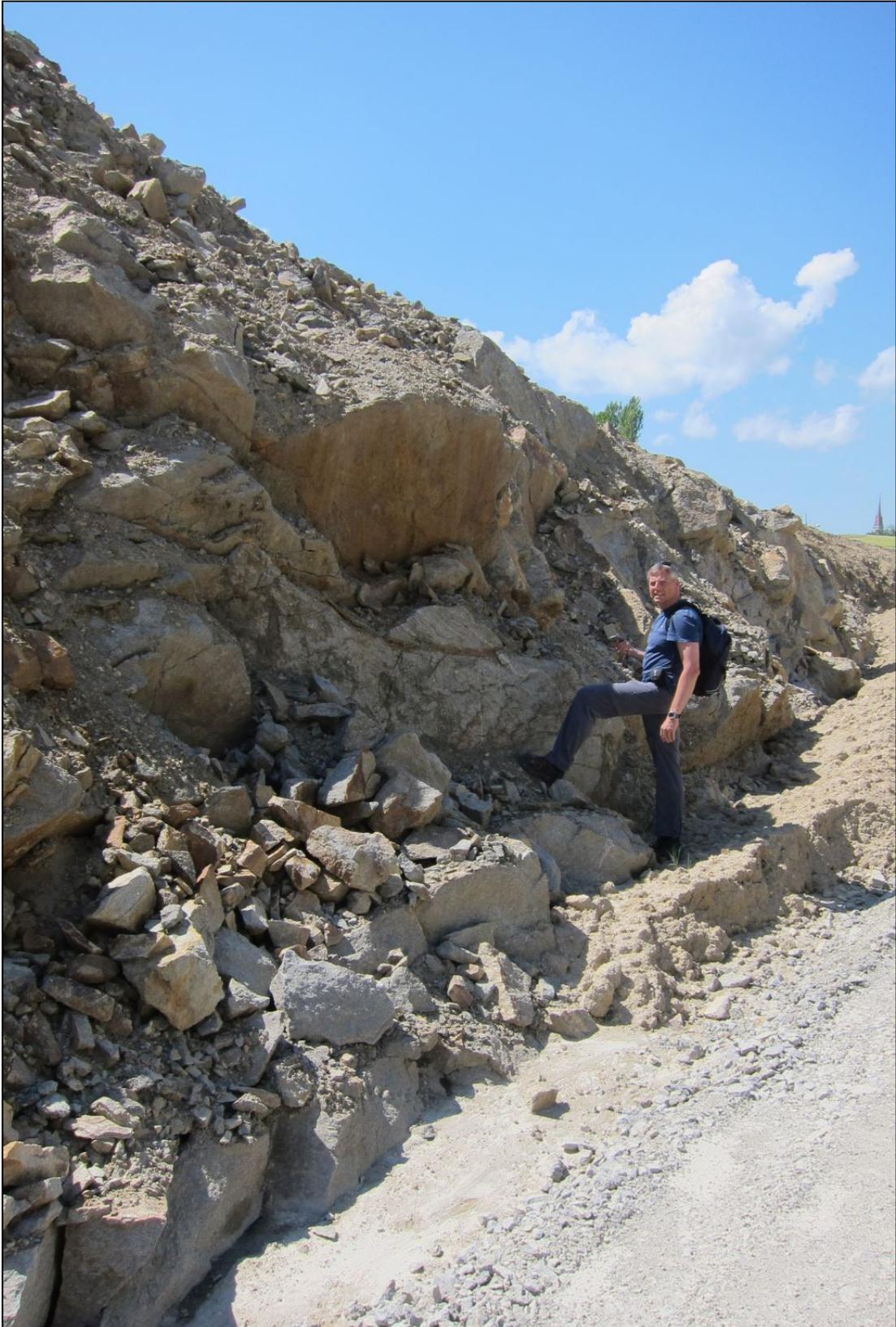
Abb. 2.1.1.5: Engständiger geklüfteter und tektonisierter „Altenberger Granit“ im Bereich des Südportals beim Tunnel Neumarkt (Foto: M. Peresson).
