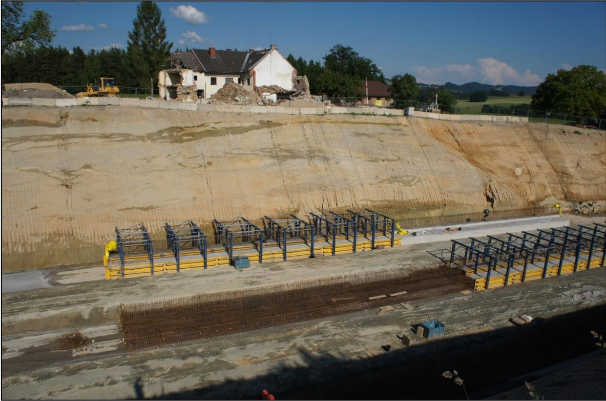
Abb. 2.1.1.42: Aufschlusspunkt 4 im Bereich der Unterflurtrasse Ganglsiedlung bei Lest: Fluviale Sedimente des Freistädter Tertiärs – graue kiesdominierte Fazies (Foto: H. Peresson).
