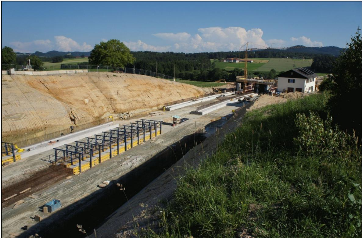
Abb. 2.1.1.41: Aufschlusspunkt 4 im Bereich der Unterflurtrasse Ganglsiedlung bei Lest: Fluviale Sedimente des Freistädter Tertiärs – rostbraune sanddominierte Fazies (Foto: H. Peresson).
