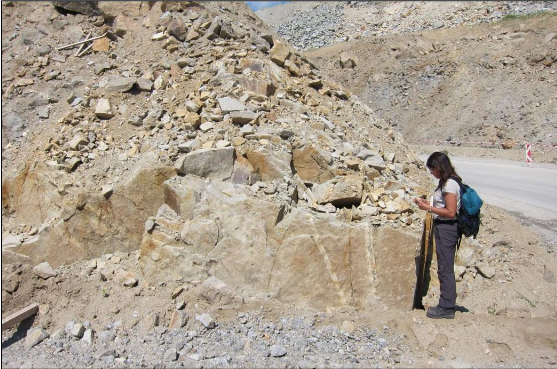
Abb. 2.1.1.6: „Altenberger Granit“ im Bereich des Südportals beim Tunnel Neumarkt mit Pegmatitgängen und Klüften (Foto: H. Peresson).
