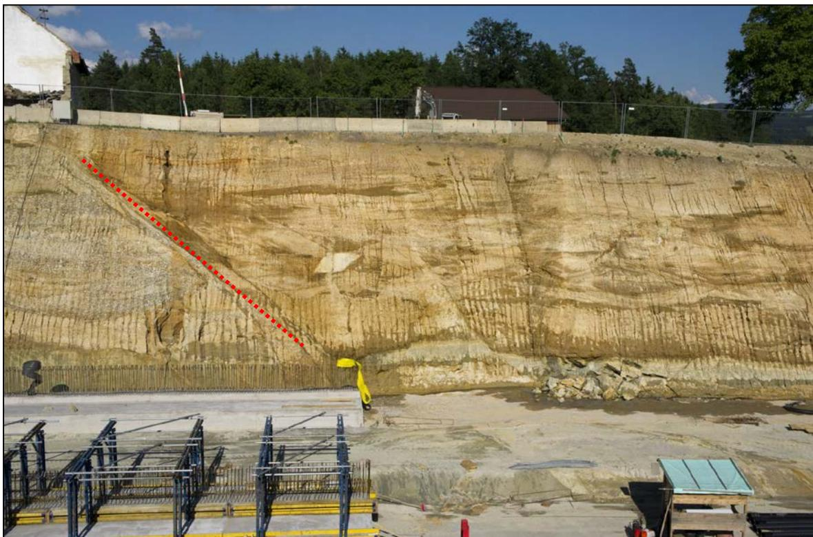
Abb. 2.1.1.47: Aufschlusspunkt 4 im Bereich der Unterflurtrasse Ganglsiedlung bei Lest: Fluviale Sedimente des Freistädter Tertiärs – Detailaufnahme der sandreichen Fazies mit weißem Tonklast und SE einfallender Störungszone (Foto: H. Peresson).
