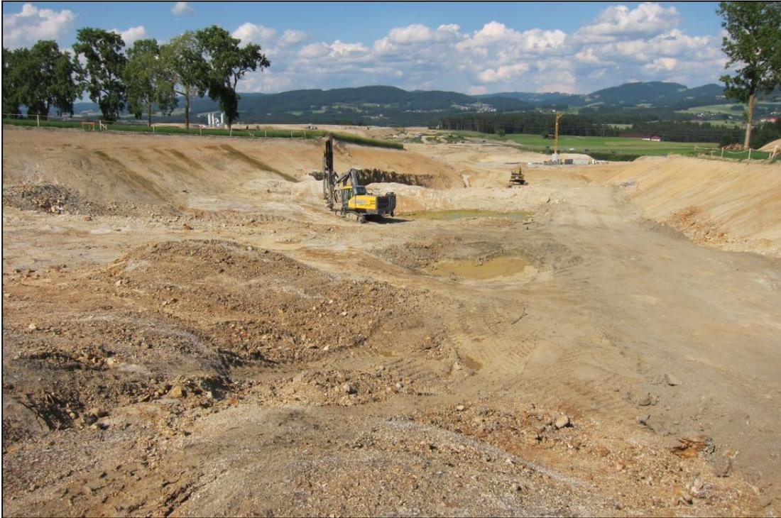
Abb. 2.1.1.26: Aufschlusspunkt 3 westlich von Pernau: Überblick über den Trassenverlauf im Altenberger Granit mit mächtiger Verwitterungsdecke (Foto: M. Peresson).
