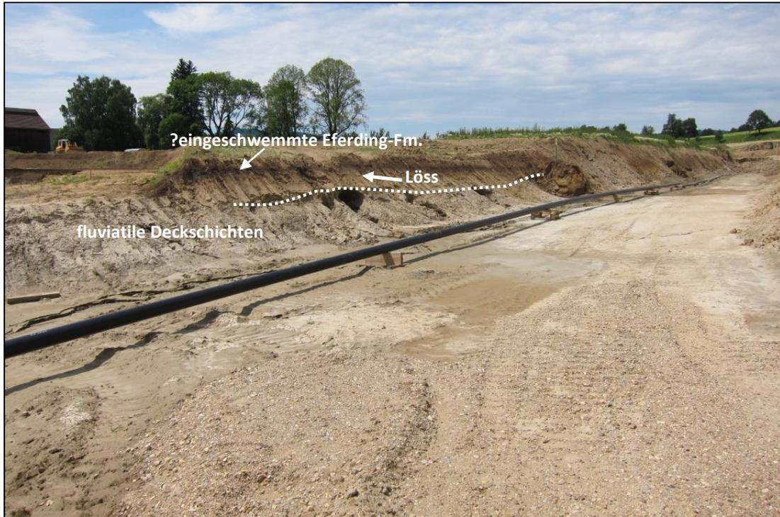
Abb. 2.2.2.11: Verlegungsarbeiten der Gashochdruckleitung innerhalb fluviatiler Deckschichten; Im Hangenden Löss und eingeschwemmte ?Eferding-Formation (Foto: M. Peresson).
