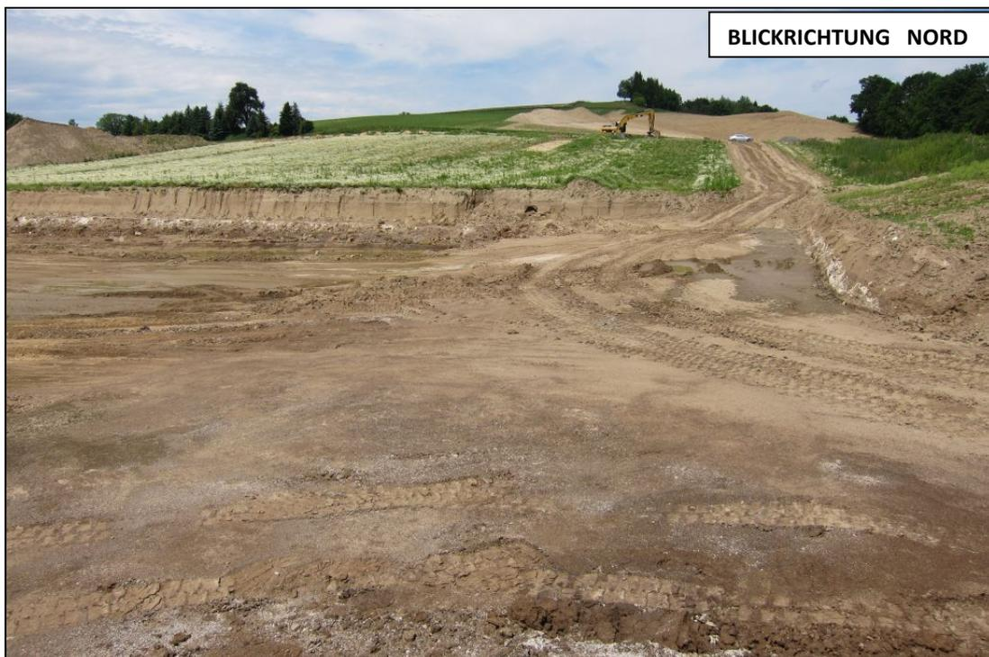
Abb. 2.2.2.4: Erdbauarbeiten für das Hochwasserrückhaltebecken Unterrudling (Foto: M. Peresson).
