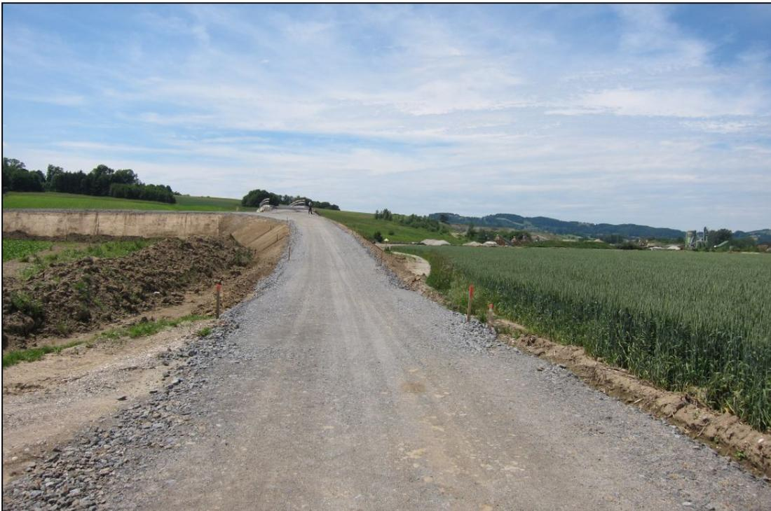
Abb. 2.2.1.29.: Dammschüttung im Bereich „Überführung Feldweg 106“ mit anstehenden (?) Deckschichten (Lösslehm) an den Seitenbereichen des Weges (Foto: M. Peresson).
