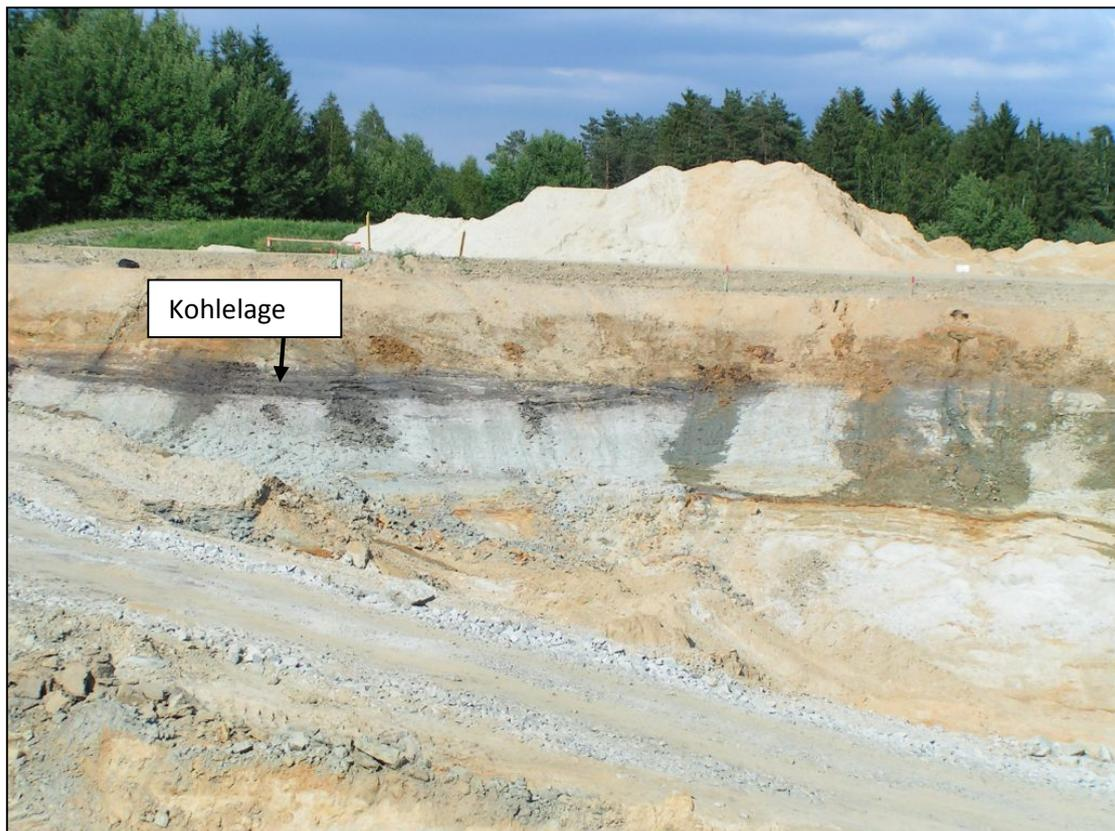
Abb. 2.1.1.49: Aufschlusspunkt 4 im Bereich der Unterflurtrasse Ganglsiedlung bei Lest: Fluviale Sedimente des Freistädter Tertiärs – Detailaufnahme der tonreichen Fazies (Foto: M. Rockenschaub).
