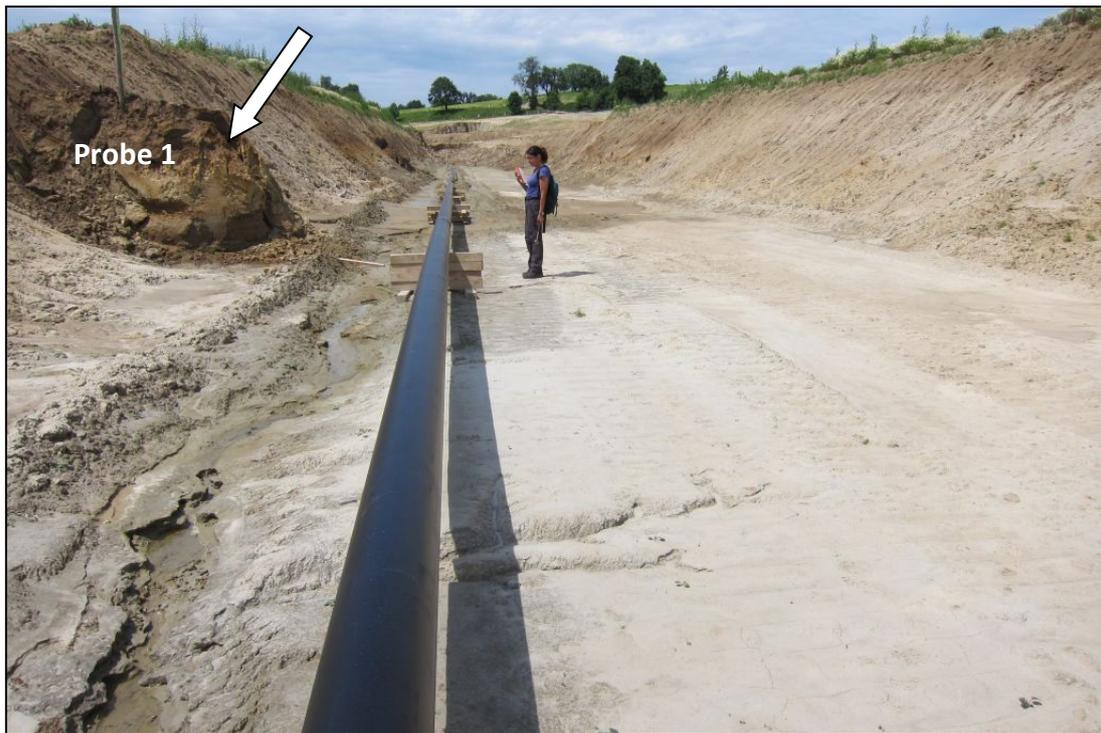
Abb. 2.2.2.13: Überblicksfoto der fluviatil abgelagerten Deckschichten mit Verlauf der Erdgashochdruckleitung; Probenahmepunkt „Unterrudling Probe1“ (Foto: H. Peresson).
