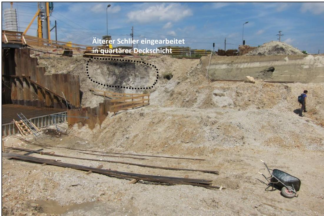
Abb. 2.2.1.9: Überblicksfoto der Sedimentabfolge vom Aufschlussbereich 1 im Nahbereich der Brückenkonstruktion mit eingeschwemmten „Älterem Schlier“ innerhalb der Deckschicht (Foto: H. Peresson).
