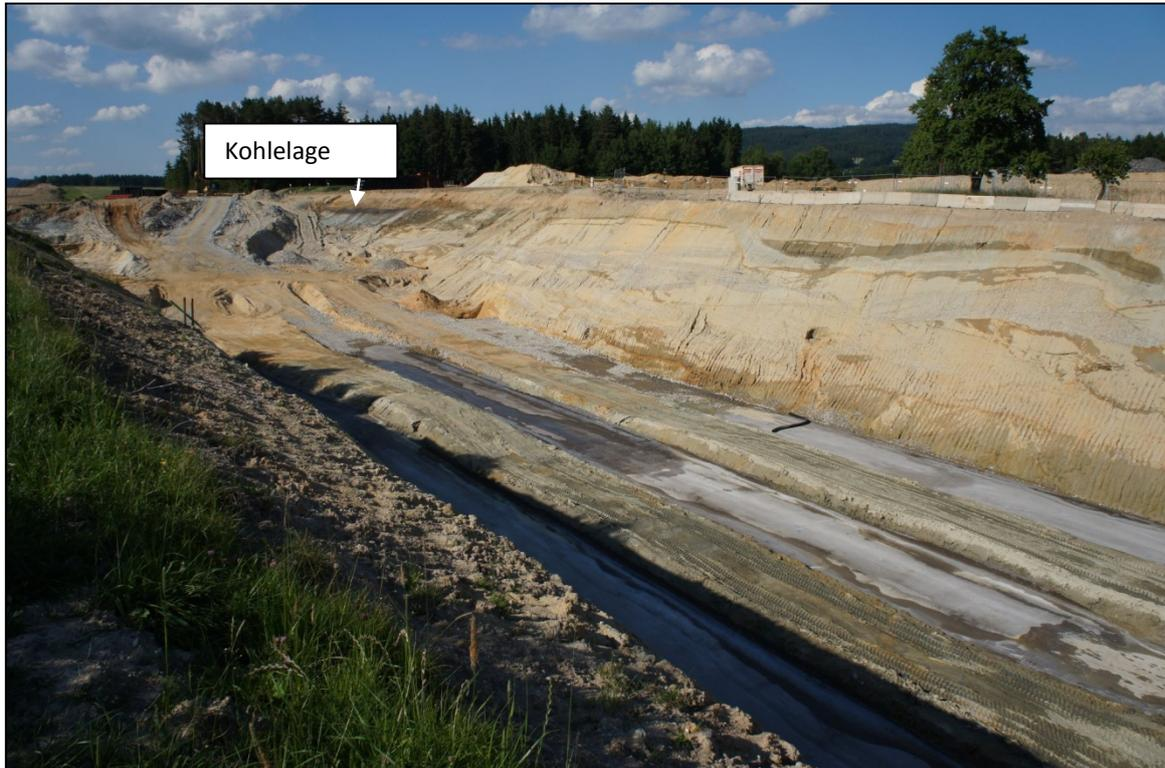
Abb. 2.1.1.46: Aufschlusspunkt 4 im Bereich der Unterflurtrasse Ganglsiedlung bei Lest: Fluviale Sedimente des Freistädter Tertiärs – graue Rinnenfazies im Übergang zu toniger Fazies (ganz links) (Foto: H. Peresson).
