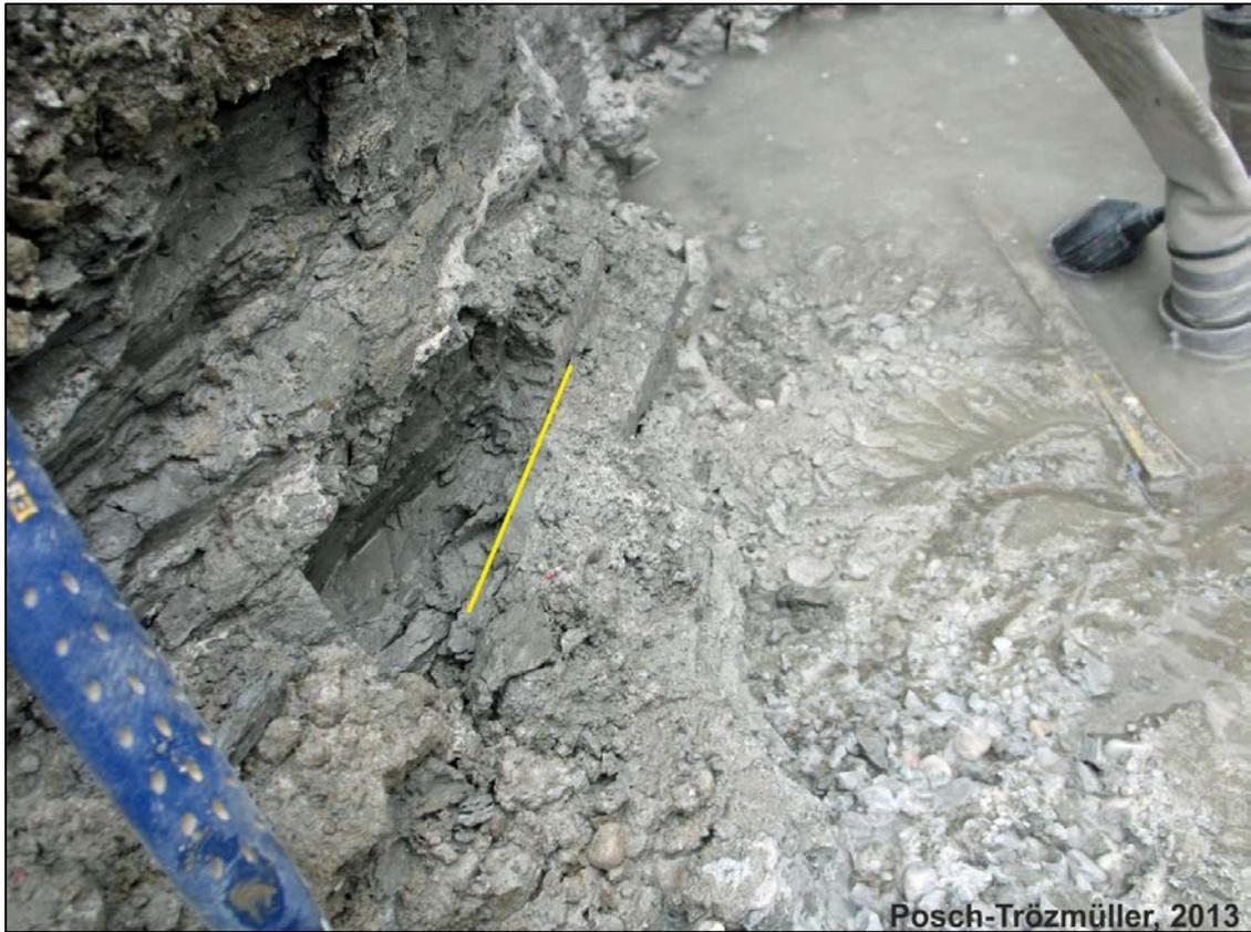
Abb. 2.2.4.15: Grundwasserpumpe (rechts oben) und auffällige Klüftung mit glatten Klüftflächen in Detailbereich C.
