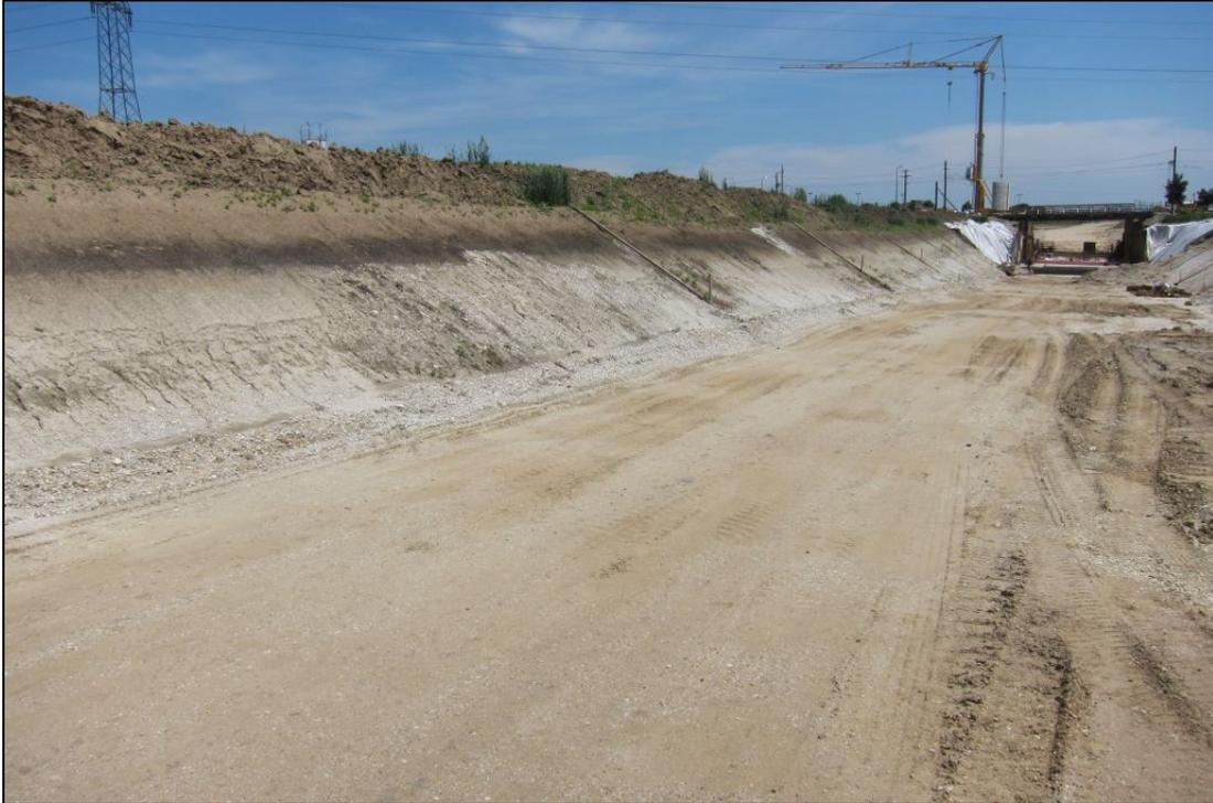
Abb. 2.2.1.21.: Mächtige Deckschichten (Lehme) mit solifluidal umgelagerter Eferding-Formation (schwarzbraun) und Kiesen der Niederterrasse im Aufschlussbereich 2 (Foto: M. Peresson).
