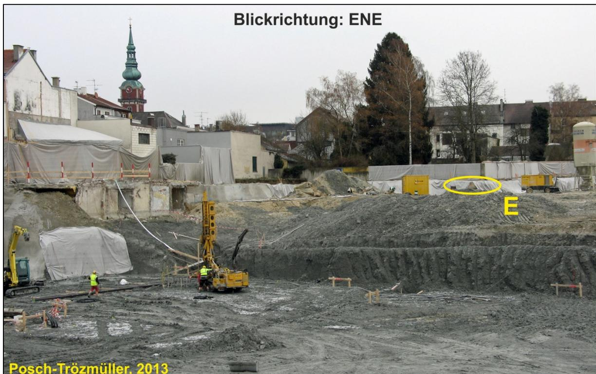
Abb. 2.2.4.10: Blick von der Dr. Franz Berger Straße Richtung ENE, in der Baugrube ist der graue Schlier der Ried-Fm. zu sehen, im Hintergrund sieht man Detailbereich E, wo Kiese der Hochterrasse aufgeschlossen waren.
