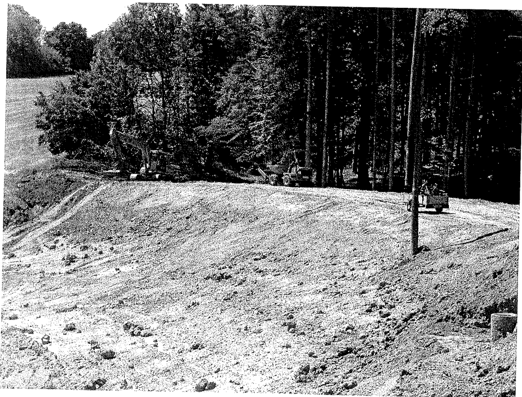
Einbringen und Verdichten des Dammschüttmaterials
