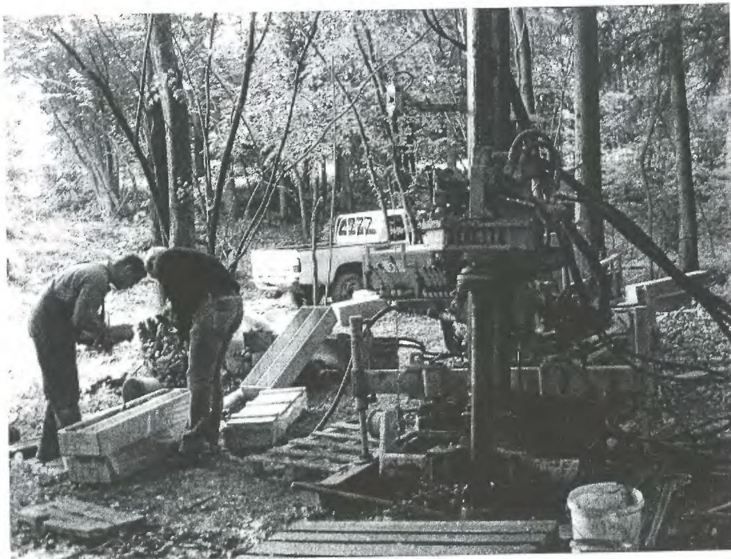
Tiefbohrung durch Fa. Reisinger Brunnenbau und Bohrtechnik.
