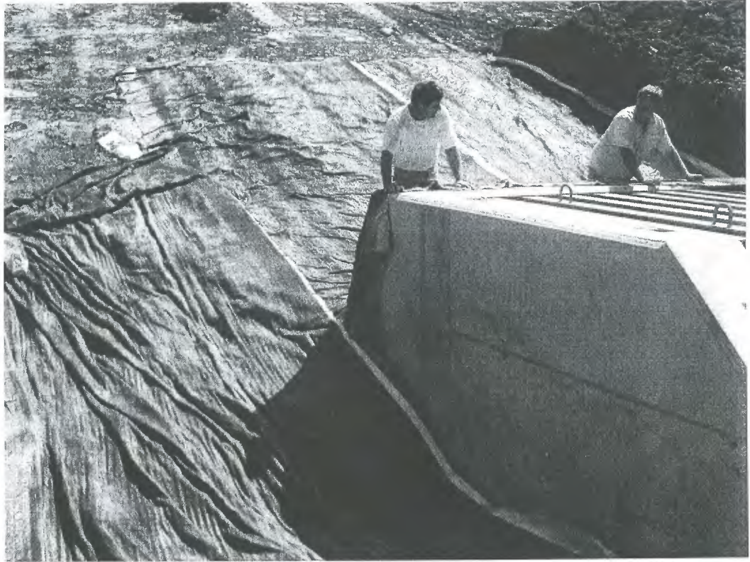
Einbau Bentonitmatten wasserseitig im Bereich des Einlaufbauwerkes und des Bypass.
