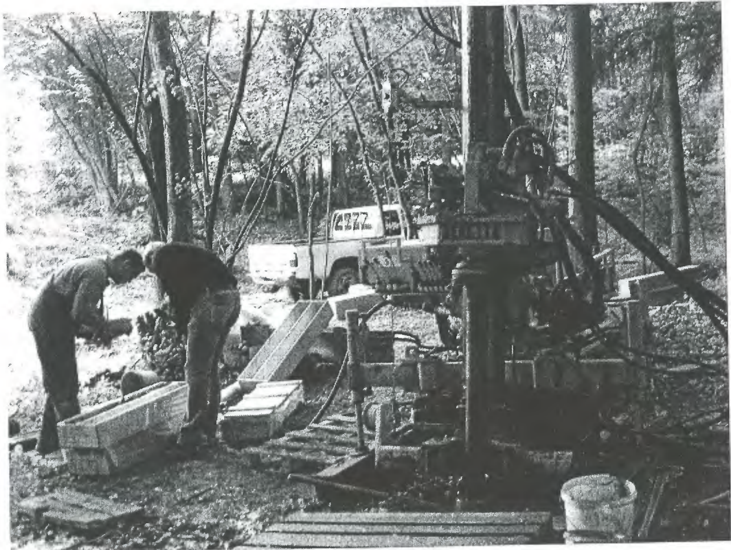
Tiefbohrung durch Fa. Reisinger Brunnenbau und Bohrtechnik.
