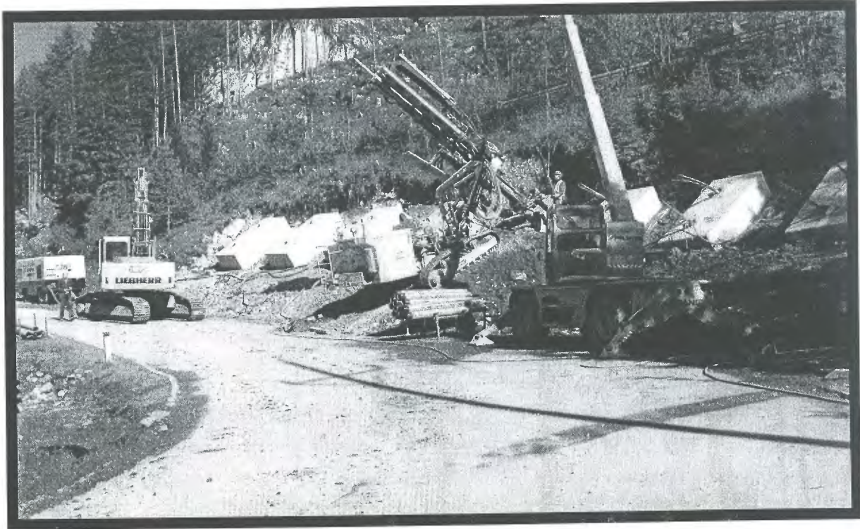
Abb.: Ankerbohrarbeiten an den vorab hergestellten Betonelementen
