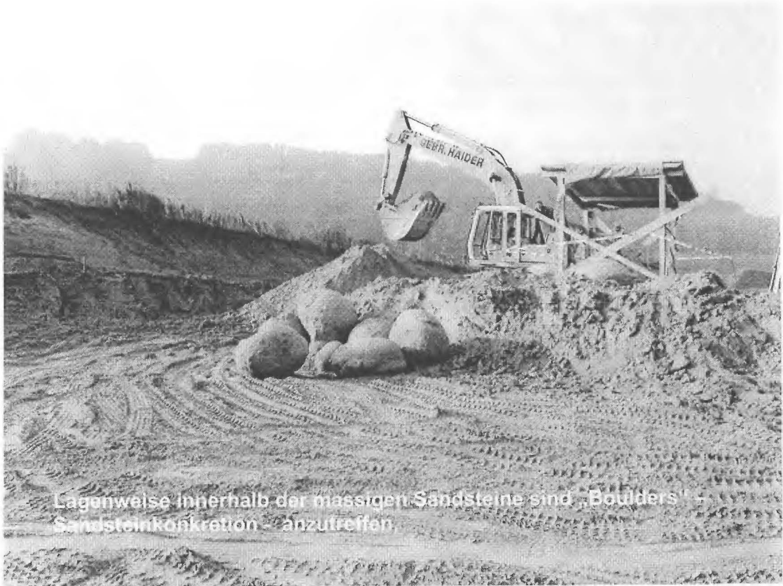
Foto 8: Boulders im Freilandbereich, hier innerhalb massiger, strukturloser mürber Sandsteinlagen im Bereich Portalvorplatz Reiserberg West.
