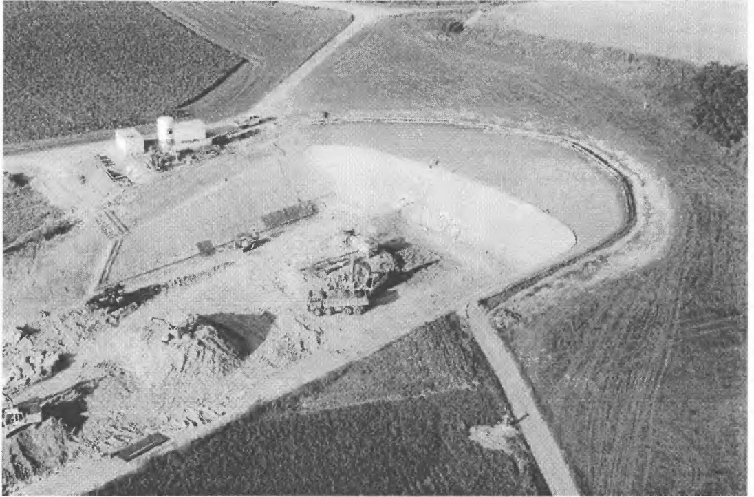
Foto 1: Abbohren des Rohrschirmes, Portalwand West des Reiserbergtunnels
