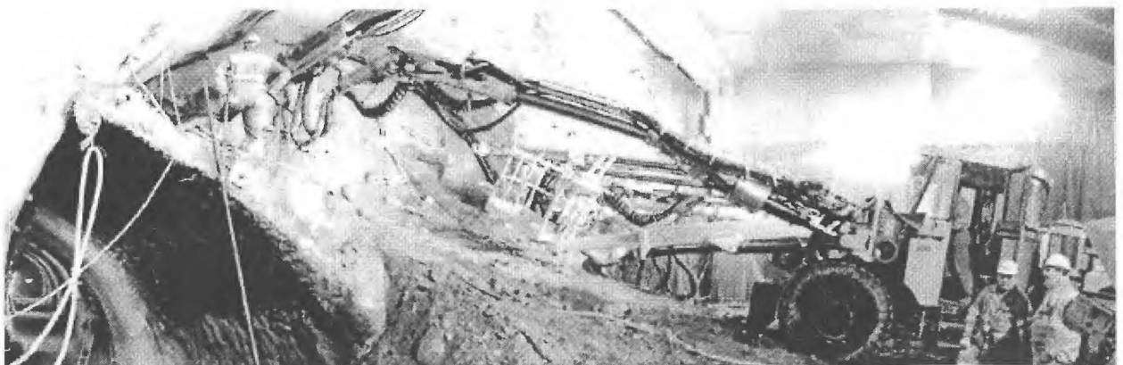
Vortrieb Ulmenstollenstrecke Ost-Vortrieb
