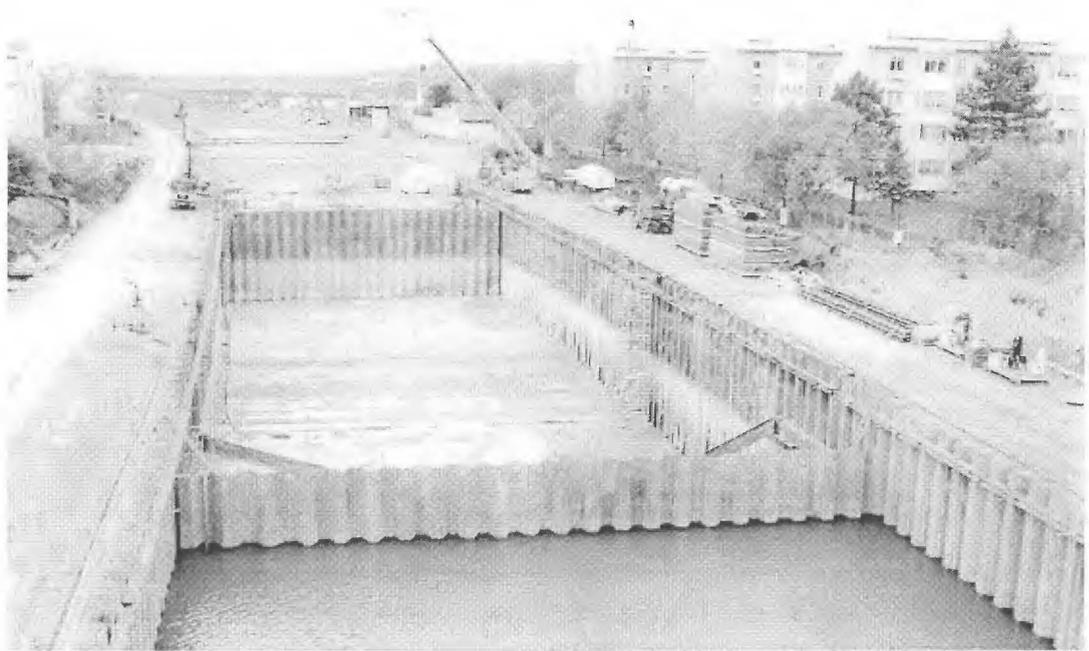
Abb. 5: Gelenzter Spundwandtrog mit verankerter Unterwasserbetonsohle
