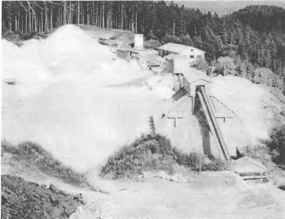
Als erste Brechstufe verwenden wir einen Einschwingenbackenbrecher mit einer Maulweite von 110 x 80 cm, der eine grobe Zerkleinerung bis 150 mm durchführt. Anschließend wird das gebrochene Material mittels zweier Doppeldeckersiebe auf die Körnungen 0/16, 16/32, 32/45 und 45/63 aufgesiebt.
