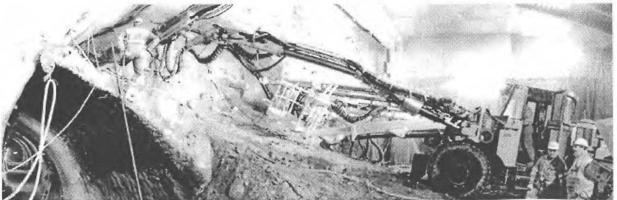
Vortrieb Ulmenstollenstrecke Ost-Vortrieb
