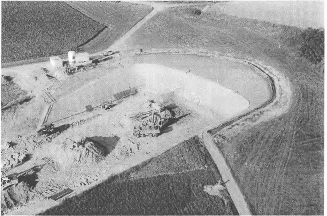
Foto 1: Abbohren des Rohrschirmes, Portalwand West des Reiserbergtunnels
