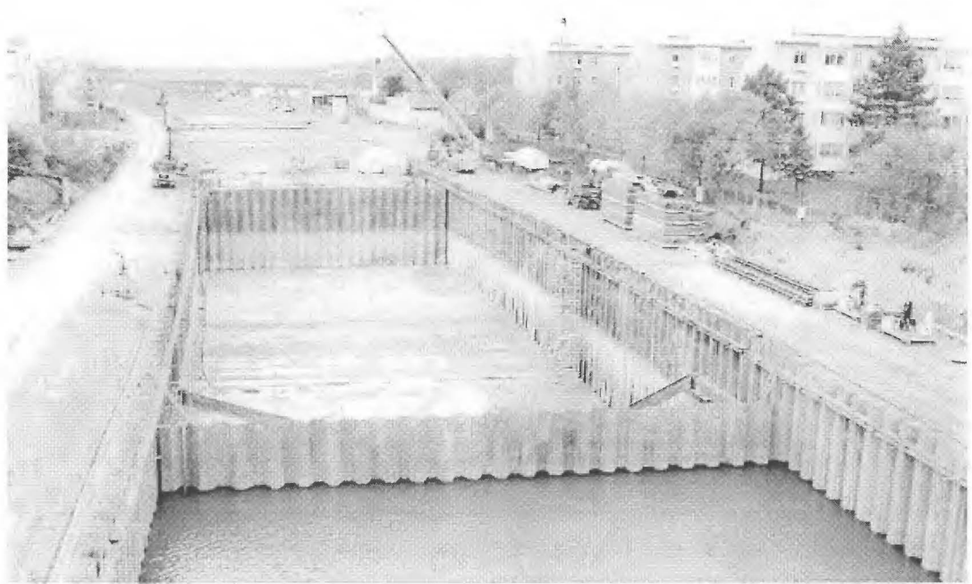
Abb. 5: Gelenzter Spundwandtrog mit verankerter Unterwasserbetonsohle
