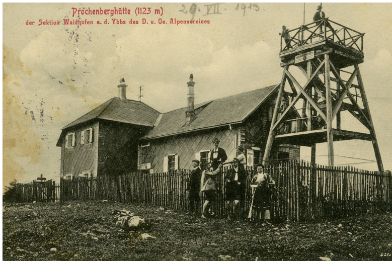
Prochenberghütte: Ansicht von Südosten, Fotografie, 1913
