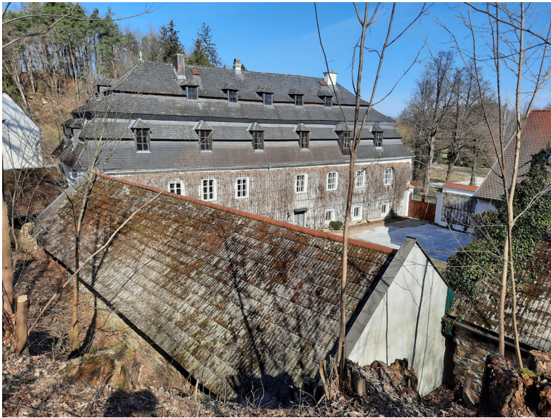
Das zu Beginn des 19. Jahrhunderts zu einem Herrenhaus umgestaltete Gebäude an der Lainsitz bei Weitra zeigt mit seinem mächtigen, mehrgeschoßigen Walmdach typische Bauelemente der vorindustriellen Papiererwerkstätten.
