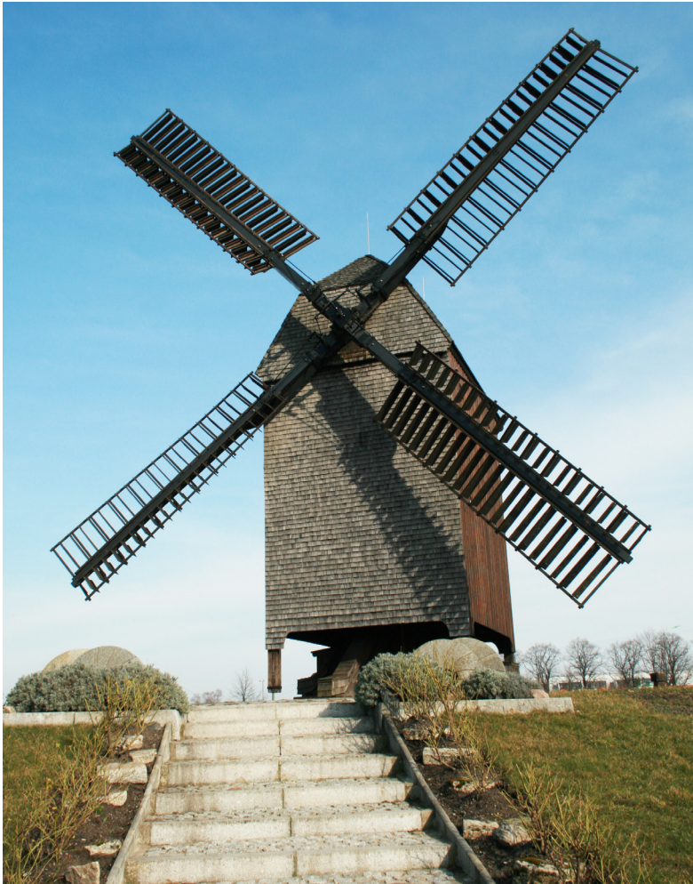
Bockwindmühle Berlin-Marzahn mit Jalousieklappenflügeln (Volljalousie)
