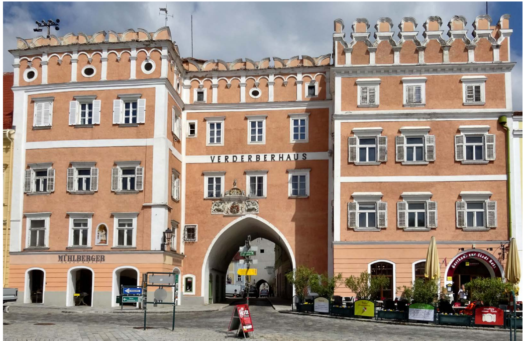
Retz Hauptplatz 2, Verderberhaus, Fassade im veneziani- schen Renaissancestil
