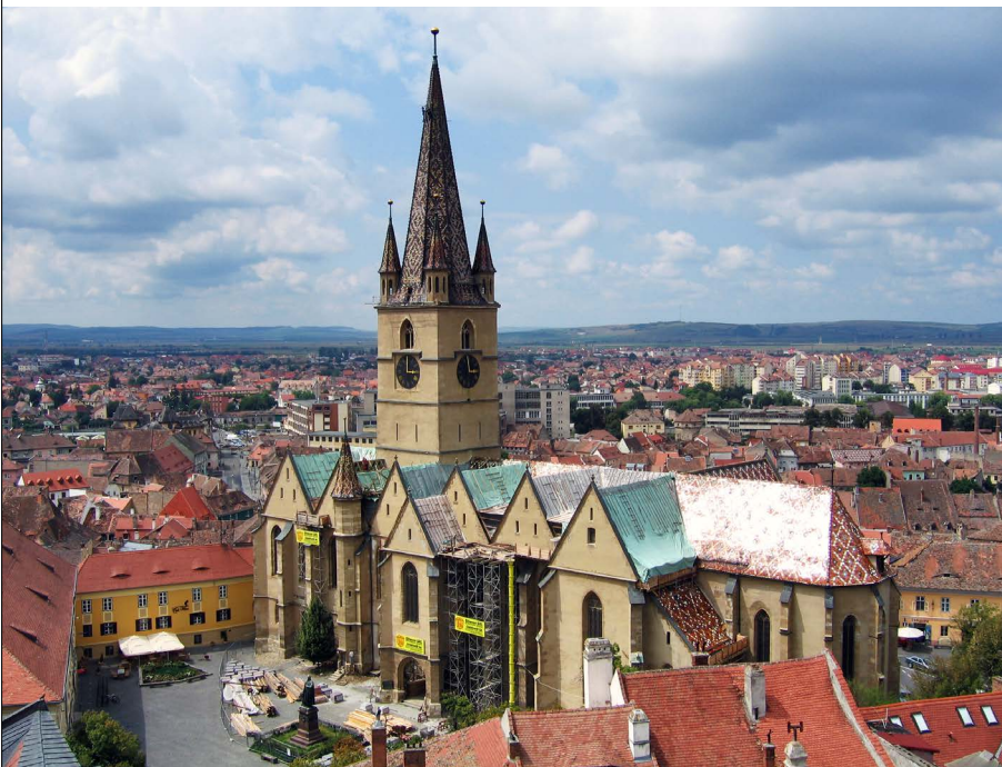
Die evangelisch-lutherische (A.B.) Marien-Kirche, Gesamtansicht Richtung Unterstadt
