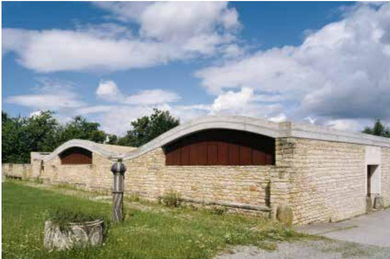
Die Fundamente, den Stahlbetonbalken und die Verlegung der Dachbalken führte die Sommereiner Firma Hermann Hums aus. Das Steinmauerwerk wurde von drei türkischen Maurern errichtet – 60 cm stark. Alle Öffnungen, Türen, Tore und Fenster können mit Stahlblechen verschlossen werden. Wir heizen nicht. Die Luft kann durch die Halle streichen. Die Fenster haben bewegliche Stege, bei Schließung sind sie zugleich Einbruchschutz. Alle Details wurden mit den Handwerkern entwickelt.
