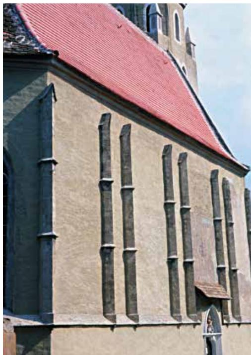
an die Mauerkanten erfolgte und eine vorkragende Traufe zur Regenabführung vermieden wurde, bildete sich danach an den Dachkanten massiver Pflanzenbewuchs, durch den die ursprüngliche Putzfassade von oben nach unten (statt wie normal umgekehrt) abwitterte.
