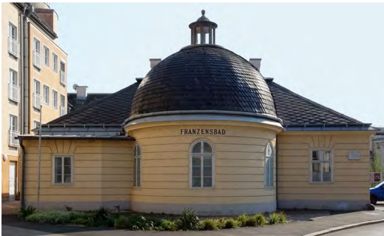
Das 1827 erbaute Franzensbad in Baden bei Wien dient heute als Hamam.
