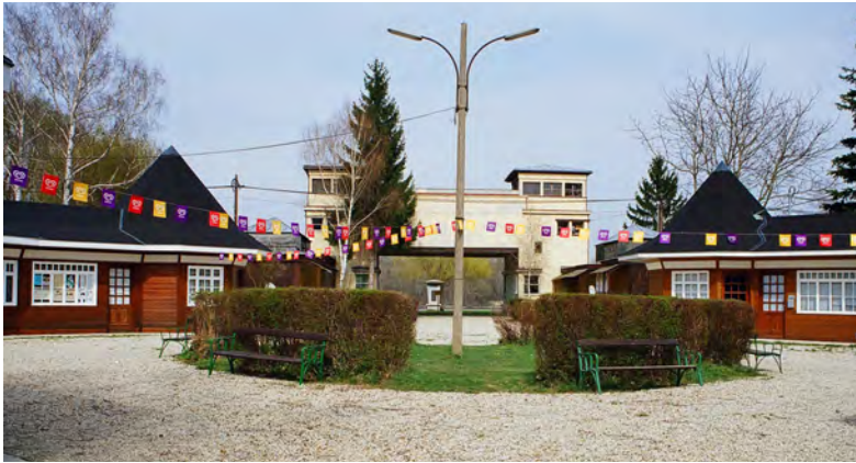
Das Rondeau und dahinter der Turmbau im Zentrum des Strombades von Kritzensdorf – Planung durch Heinz Rollig und Julius Wohlmuth, 1927/28.
