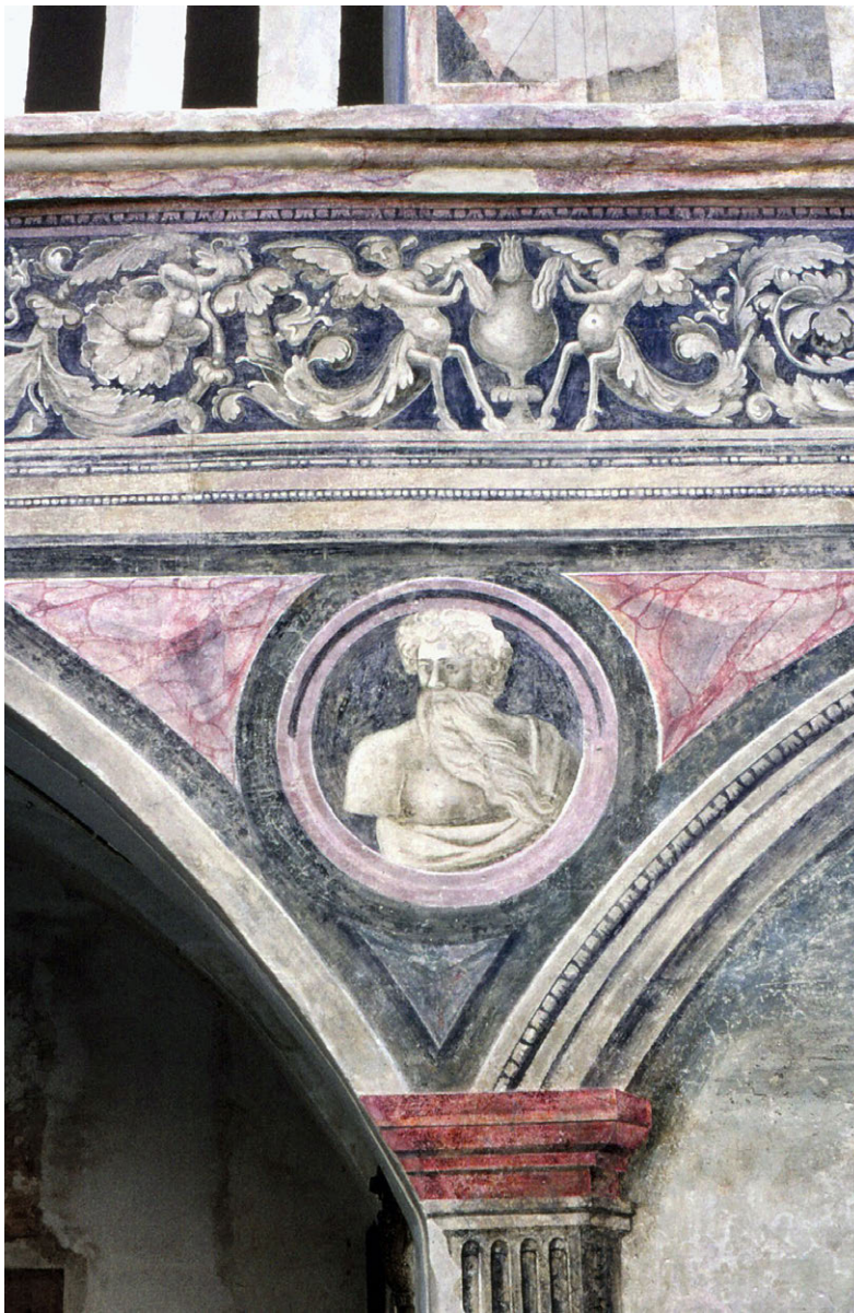
Pöggstall, Schloss Rogendorf, Hofarkaden, Fassadenmalerei 1540/50, nach Freilegung und Restaurierung der Fassadenmalerei 1996
