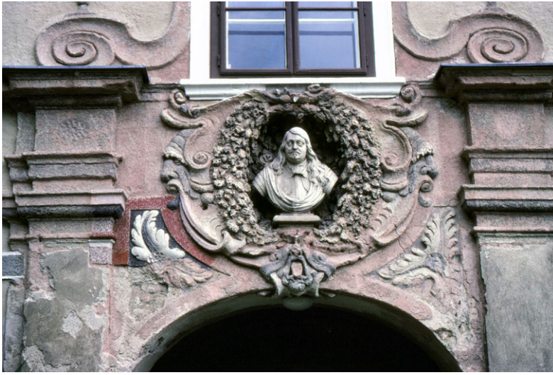
Kirschschlag in der Buckligen Welt, Hofhaus, Frühbarockportal mit Inkrustation, während Restaurierung 1985
