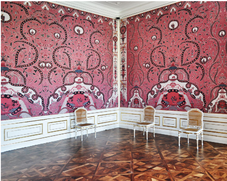
Schloss Hof, Witwenappartement, 18. Jh.: leimgebundene weißgold gefasste Wandverkleidung und Stühle
