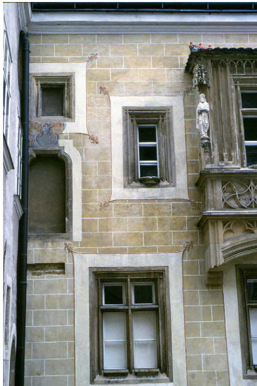
Klosterneuburg, Altitift, Hoffassade nach Restaurierung 1990 (Steinerker ohne Befund)
