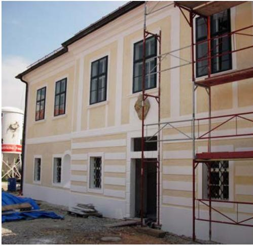
Neben den Interventionen am Neuen Schloß wurden das Gerichtsstöckl neu in Kalktechnik verputzt und im Erdgeschoß zu einem Aufenthaltsbereich für Mitarbeiter umgebaut sowie anschließende Mauerabdeckungen wiederhergestellt, um so weiterem Verfall durch eindringendes Regenwasser entgegenzuwirken. (C.T.)
