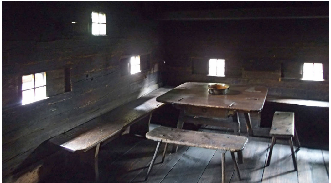
Blockbaufenster mit einfachen Holzschubern, Freilichtmuseum Stübing
