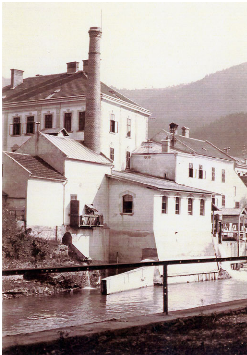
Kraftwerk Mühlhof um 1925 mit Schornstein und Kesselhaus zum Betrieb einer Dampfturbine.
