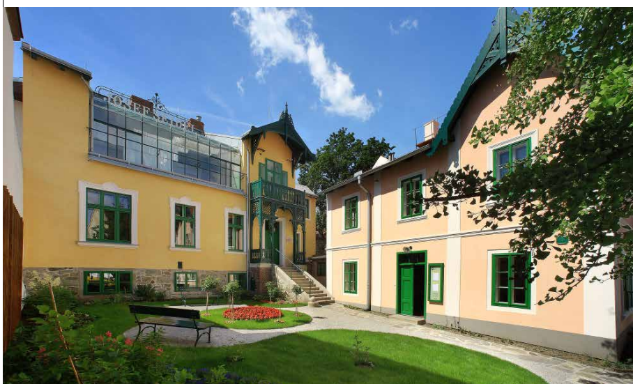
Atelier Seidel nach der Renovierung 2006-2008
