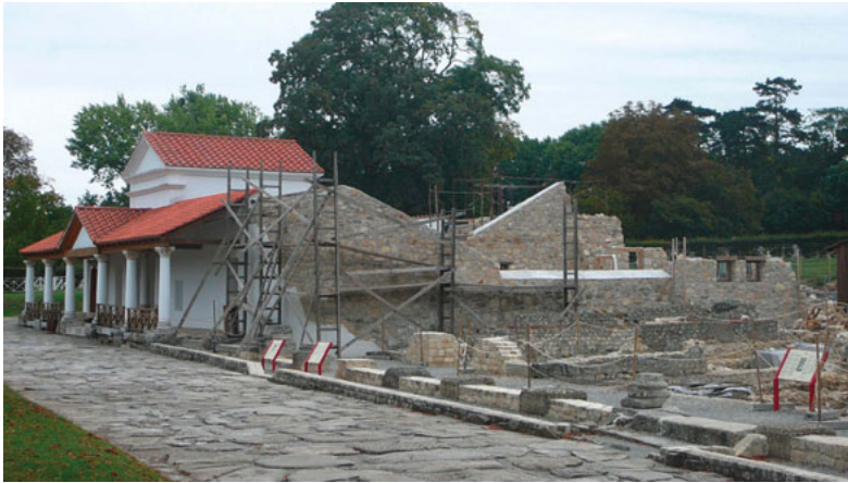
Petronell-Carnuntum, Freilichtmuseum, Steinmauerung in antiker Handwerkstechnik beim Bau der villa urbana, Ansicht von Nordwesten (2007)
