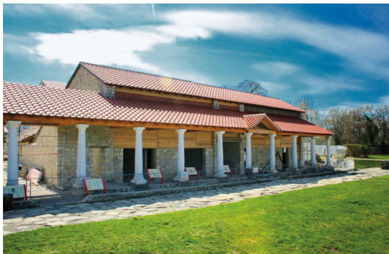
Petronell-Carnuntum, Freilichtmuseum, Rekonstruktion einer römischen Therme des beginnenden 4. Jahrhunderts, Ansicht von Osten (2010)
