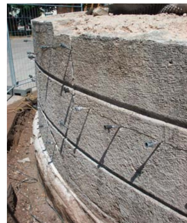
Gestockte Sockelmauer während der Verpressung 2009
