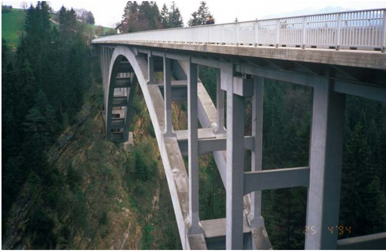
Echelsbach, Bayern, Melanbrücke über die Ammer, erbaut 1929
