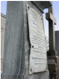
Wien, Zentralfriedhof, thermisch bedingt irreversibel verformte Inschrifttafel aus feinkristallinem Marmor
