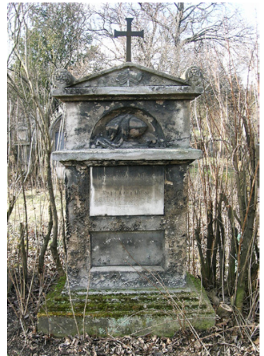
Wien, Friedhof St. Marx, unterschiedliche Verwitterungsformen im Regenschatten an porösen und saugfähigen Kalksandsteinen des Leithagebirges – Krustenbildung mit nachfolgender Abplatzung, Versalzung, biogene Besiedelung
