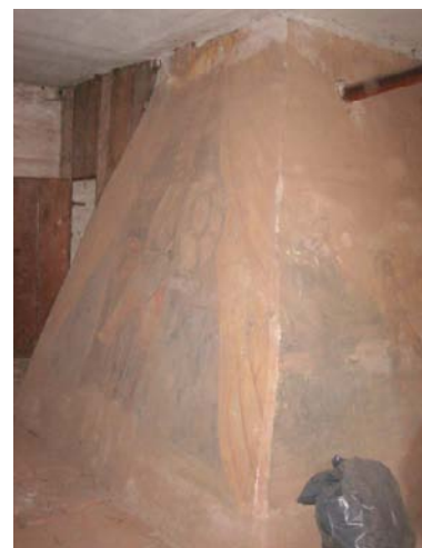
Kaminzimmer, Wandmalereien am Kamin, nach Restaurierung (unten)
