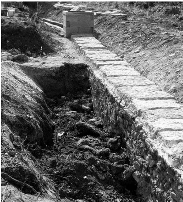
Petronell-Carnuntum, unversehrte römische Steinmauerung mit rückversetzter Steinplattenabdeckung, im Hintergrund ein neu angelegter Wartungsschacht
