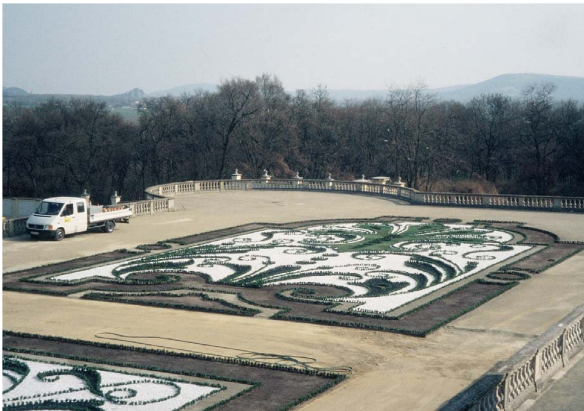
Hier sieht man die Rekonstruktionsarbeit auf der dritten Terrasse von Schlosshof kurz vor dem Abschluss im Jahr 2005.
