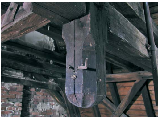
Jihlava, Haus Nr. 419, Hängesäule im Dachwerk aus dem Jahr 1589
