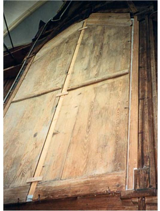
OÖ, für seine Altargemälde als bestes Mittel gegen feuchte Wände und Altarnischen rückseitigen Bretterschutz („hölzernes Taferlwerk“) und Lüftungslöcher („Zuchscheiben“) empfohlen hat: „... denn die Luft ist das Beste gegen Fäulnis und Vermorschen“ und so werden „die Bilder viele Jahre lang erhalten“. Dagegen sei „das Öl den Farben höchst schädlich und würden alle Farben absterben“.
