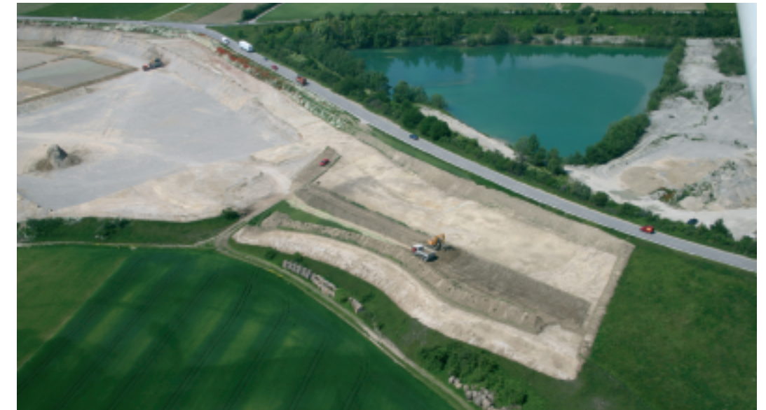
Rettungsgrabung auf der Bahntrasse im Tullnerfeld
