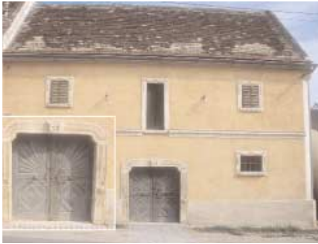
Straning bei Eggenburg, Presshaus, Fenster und Türgewände aus Zogelsdorfer Stein (links)
