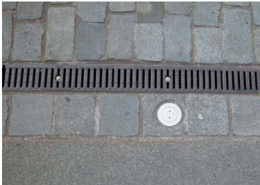
Die unscheinbare Infrastruktur: herausnehmbare Metalleinsätze für Stangen, Standln und andere temporäre Aufbauten, und die Abflussrinne, zugleich Schacht für Kabel und andere Leitungen
