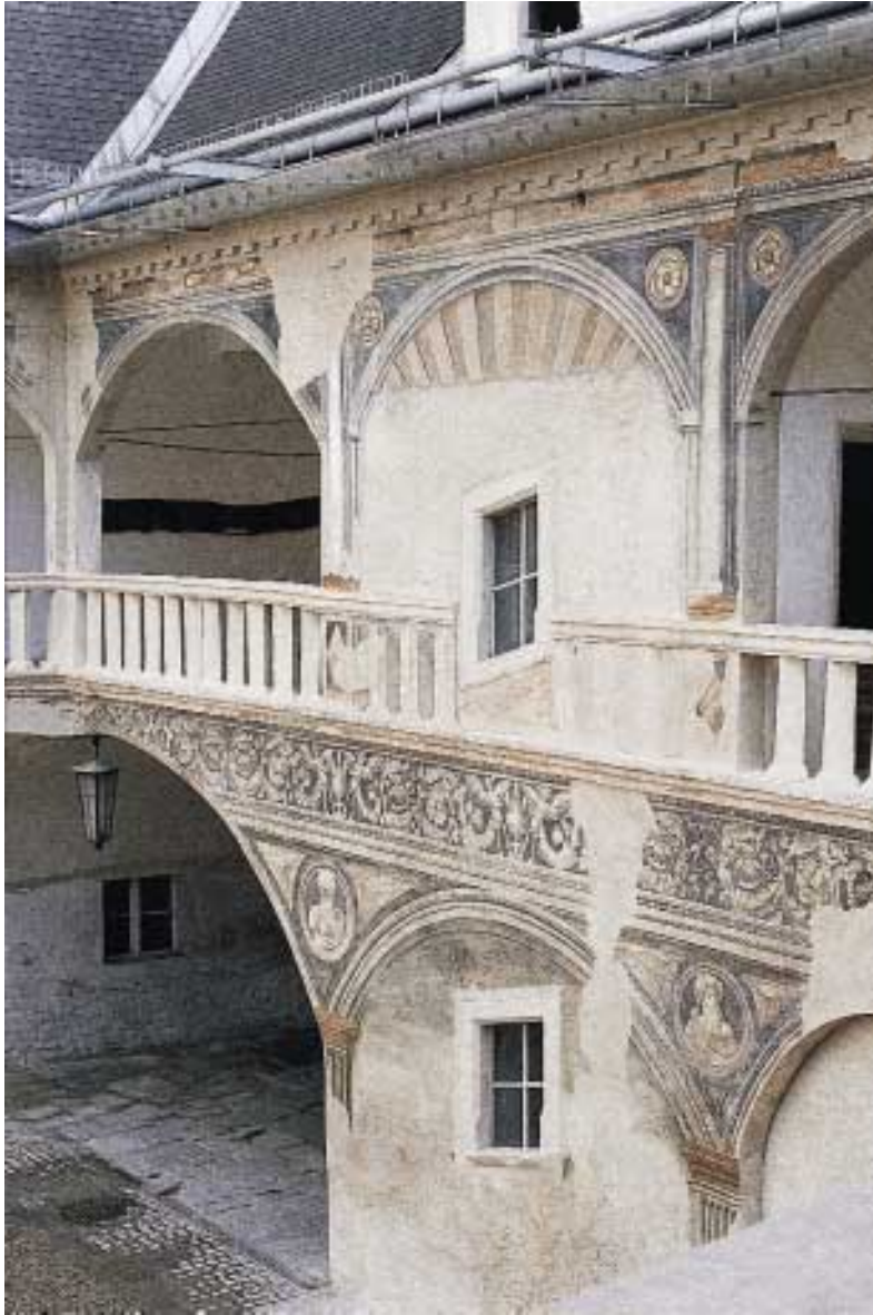
Schloss Rogendorf, Eingangsflügel 1997 nach Freilegung, Restaurierung und Schutzdachkonstruktion
