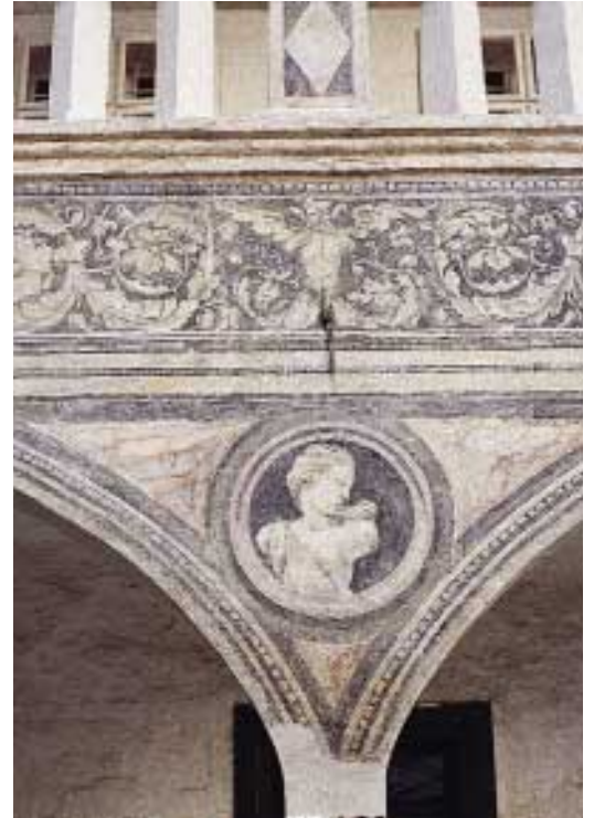
Schloss Rogendorf, Detail der restaurierten Fassadenmalerei um 1540.
