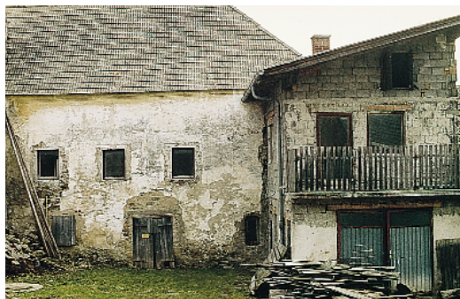
Zustand des Hauses vor der Renovierung. In diesem Gebäudeteil war die historische Bausubstanz noch fast unverändert erhalten. 1991 erwarben Hilde und Wilfried Brocks das Gebäude.
