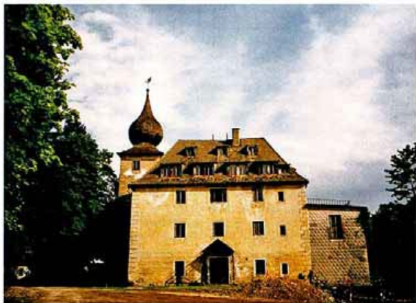
Zell/Ybbs, NO Schloss, vor Baubeginn, von Süden
