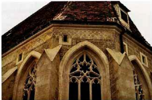
Stein, Chor der Pfarrkirche nach Restaurierung
