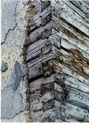
Käsmark (Kezmarok), Slowakei, alte Pfarrkirche, Blockkirche 18. Jhdt. mit eh. Lehm/Kalkverputz.
