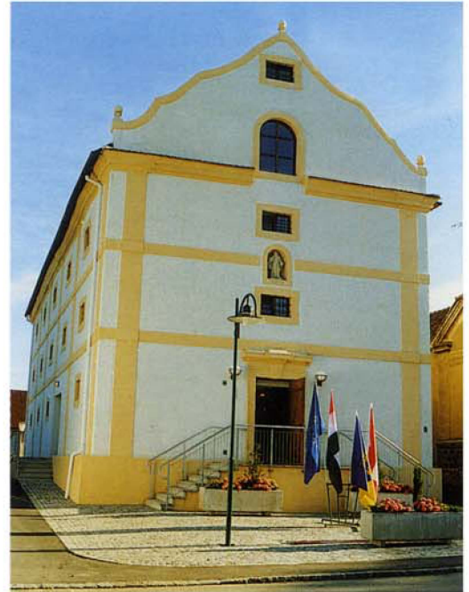
Schüttkasten in Haugsdorf, zur Zeit als Dorfzentrum genutzt
