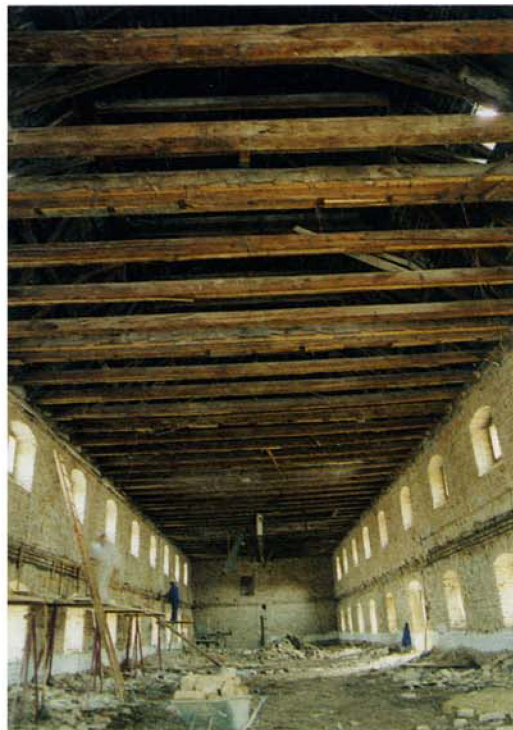
Schüttkasten Bisamberg während der Renovierungsarbeiten 1988
