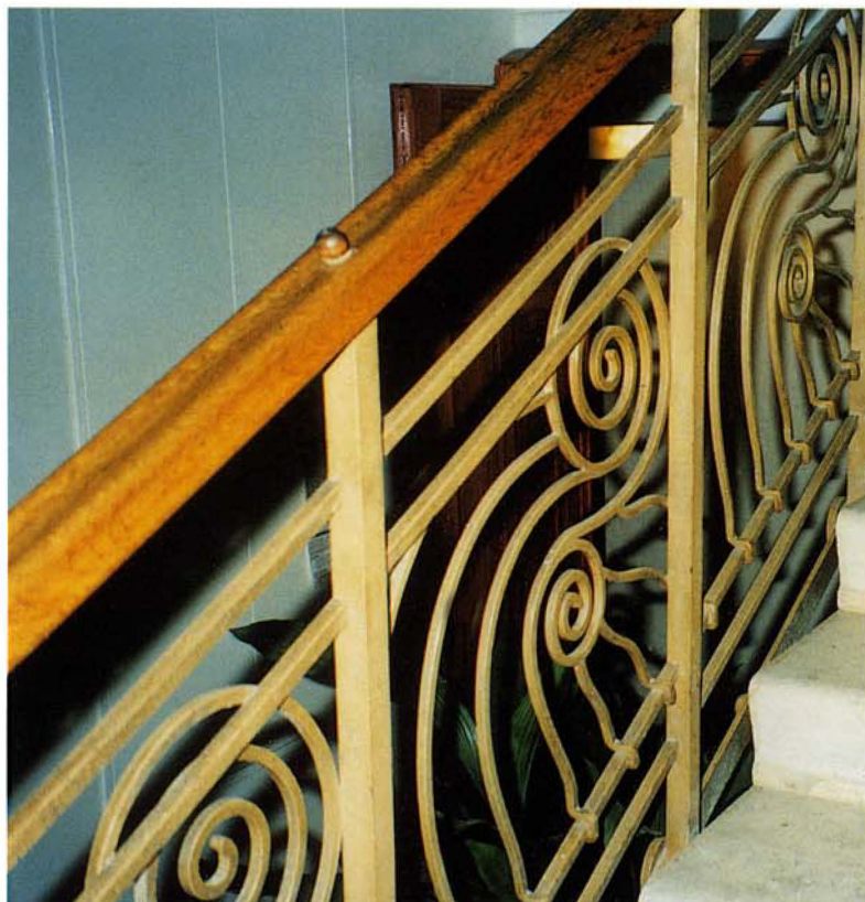
Villa Loos, Stiegenhaus, Geländerdetail
