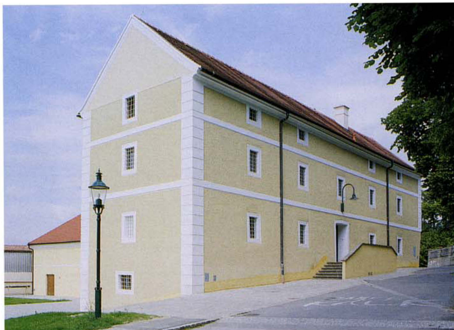
Schüttkasten in Ebenthal, Straßenseite nach der Renovierung
