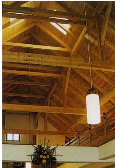
Haugsdorf Saalgalerie mit der offenen Dachkonstruktion
