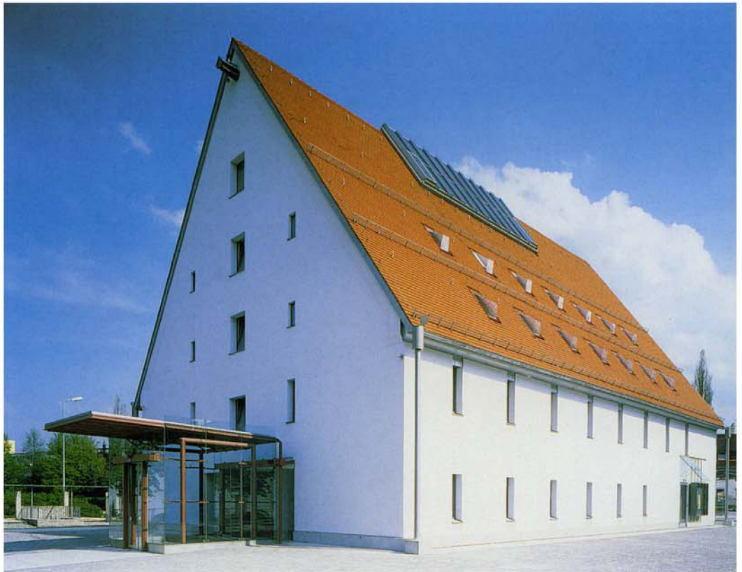
Biberach, Ansicht mit dem neuen Windfang
