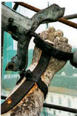
Abb. 7 Kopf des Engels Raffael nach der Rekonstruktion des Gesichtes mit Restauriermörtel, welcher in Farbe, Härte und Struktur dem Originalsandstein genau angepaßt wurde.
