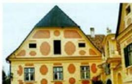
neu errichtet. Die zweigeschossige Vierflügelanlage wurde putzmäßig saniert bzw. ausgebessert; die Neufärbelung erfolgte mit Kalkanstrich.
