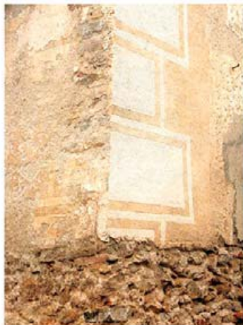
Ottenstein, Bergfried: aufgeputzte Quaderung mit Stuppsputz, Begleitband geritzt und geblättert, 2. Drittel 17. Jhdt.
