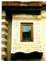
Herzogenburg, Krenmerstraße 5: spätgotisches Haus mit Erker, gemalte weiße und rote Fugenquaderung, voll gemalte Eckquaderung kontrastierend konturiert, Dekorbänder
