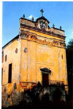
Stift Heiligenkreuz. Bibliotheksfassade um 1900: Zustand 1977 nach Sanierung der Baustatik
