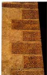
Ottenstein, Bergfried: aufgeputzte Quaderung mit Stuppsputz, Begleitband geritzt und geblättert, 2. Drittel 17. Jhdt.
