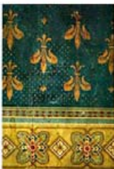
Die alte Schablonenmalerei des großen Sitzungssaales nach Abnahme der Tapeten aus den 50er Jahren
