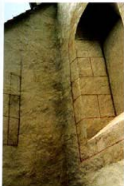
Weinsteig, Filialkirche: Quaderfugen an Fenster- laibungen und am Strebe- pfeiler geritzt und rot gemalt in der zweiten Putzschicht, 14. Jhdt.(?)
