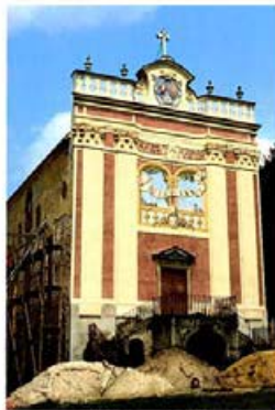
Stift Heiligenkreuz. Bibliotheksfassade, 1980 nach Wiederherstellung der ursprünglichen Farbgebung und Teilkonstruktion der zentralen Sonnenuhr
