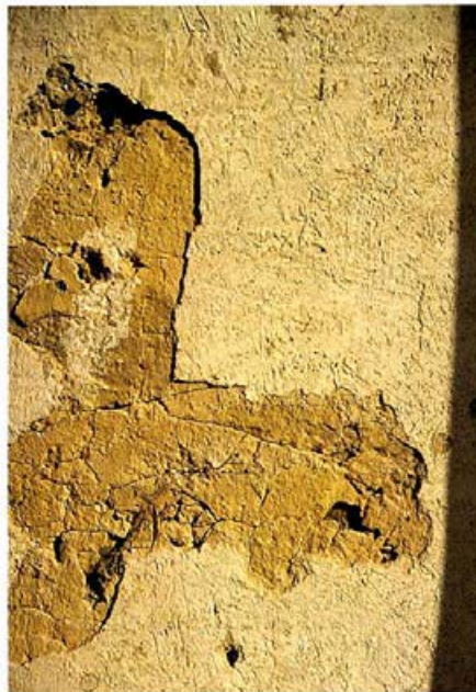
Kartause Mauerbach, NO, um 1650. Stark ausgereisener, lehmhaltiger Unterputz (Grubensand) mit ca. 2–3 mm Überzug mit kalkreichem Mörtel aus feinem Bachsand, mit der Tünchekehle verteilt
