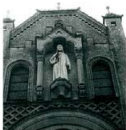
Katzeldorf (BH Mistelbach), Pfarrkirche von Karl Weinbrenner, 1905–08. Ungefärbter Putz. Stein und Ziegel sind gemäß dem Grundsatz der Materialgerechtigkeit verwendet
