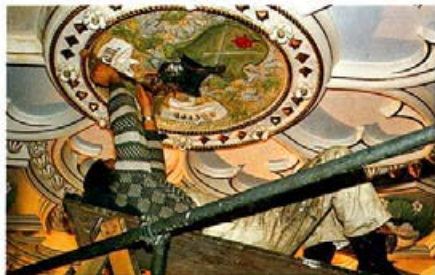
Restaurierungsarbeiten an der Wappendecke im Stiegenaufgang
