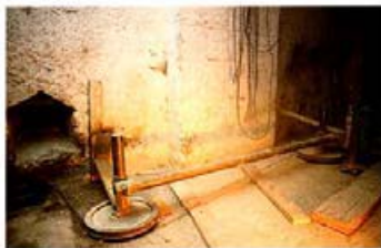
Horizontalisierung, Schnitt mit Kettensäge
