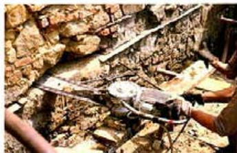
Horizontalisierung, Schnitt mit Kettensäge
