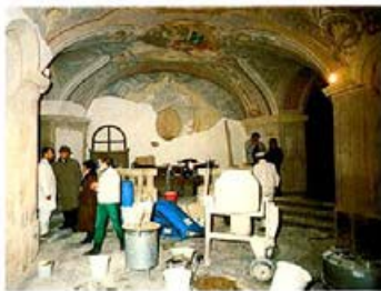
Salzreduktion mit Cellulosekompressen in Krypta von Dürstein
