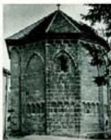
Tullner Karner, Ansicht von Westen, Zustand während Konservierung (Mittelachse und Sockelzone sind noch in Arbeit, das Platzniveau ist bereits angehoben)
