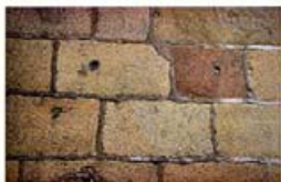
Detail mit der Stockhamerüberarbeitung und Zementkittung der Quaderfugen von 1885 und Resten der alten Steinmetzzeichen
