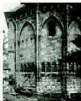
Tullner Karner, Ansicht von Westen, Zustand vor Konservierung 1975 mit dem alten Niveau des Kirchenplatzes
