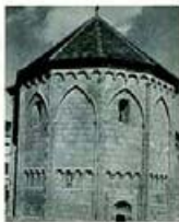
Tullner Karner, Ansicht von Südwesten mit der sogenannten Susterfigur und dem Abgang zum Beinhaus, nach Konservierung 1978, vor Hydrophobierung (erst 1982)
