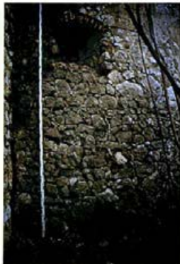
Burgruine Starhemberg, NO. Östliches Rondell des »Waffenplatzes«. Das spätmittelalterlich-frühneuzeitliche Mauerwerk zeigt in seiner Struktur den Übergang vom Schichtmauerwerk zum »Netzmauerwerk« mit Zwickelsteinen in den Stoß- und Lagerfugen. Die Fensterbögen sind nicht mehr in Bruchsteintechnik ausgeführt.
