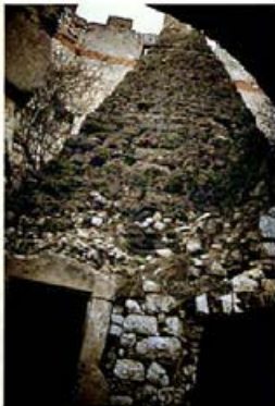
Burgruine Starhemberg, NO. Südfassade des Küchentrakts. Das Portal (links) in Werksteintechnik, das Fenster (rechts) in Bruchstein, der Mauerpfiler dazwischen in ausgebildeter »Netzmauerertechnik«. Die Schornsteinspyramide aus Kalktuff in Quadertechnik.
