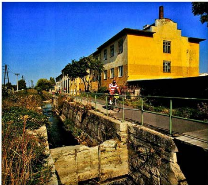
Von Lasenburg bis Kottlingbrunn wird der Kanal heute von einem sehr beliebten Radweg begleitet. Hier bei Tributwinkel sind die originalen Schleusenklammern erhalten.
