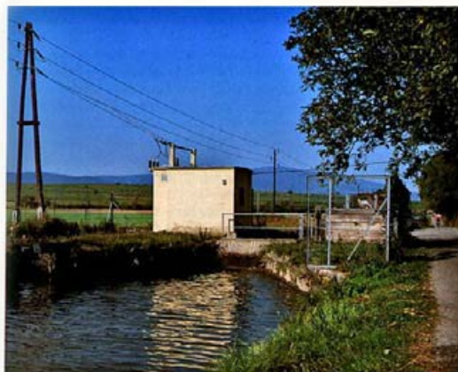
Eines der zahlreichen Kleinkraftwerke (bei Bad Vöslau), die sich entlang des Kanals etabliert haben.
