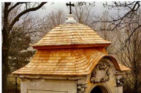
Heiligenkreuz, Dach der Kreuzwegkapellen vor und nach der Neueindeckung mit Holzschindeln
