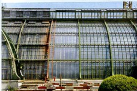
Während der Arbeiten am Palmenhaus in Schönbrunn. Am oben stehenden Bild sind deutlich die unterschiedlichen Verglasungen ersichtlich: die Alte, die ursprünglich Vorgesehene und die Neue.
