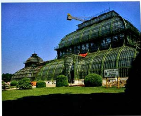
Während der Arbeiten am Palmenhaus in Schönbrunn. Am oben stehenden Bild sind deutlich die unterschiedlichen Verglasungen ersichtlich: die Alte, die ursprünglich Vorgesehene und die Neue.
