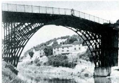
Ironbridge, England, die erste gußeiserne Brücke der Welt, 1777
