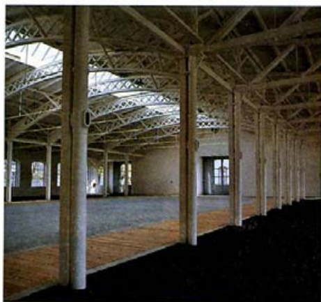
Innenraum der westlichen Halle mit den Stephanibindern
