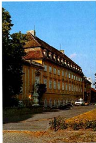
Ebreichsdorf, NÖ, Baumwollmanu- faktur der ehemaligen k.k. priv. Zitz- und Kattunfabrik, erbaut 1773
