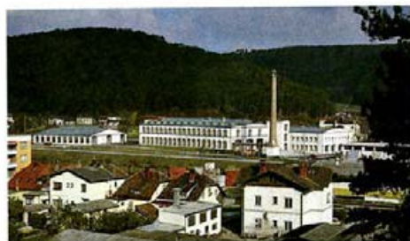
Die Anlage nach der Revitalisierung
