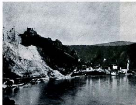
Der Bahnbau und die Sprengung des „Wächters“ bei Dürnstein
