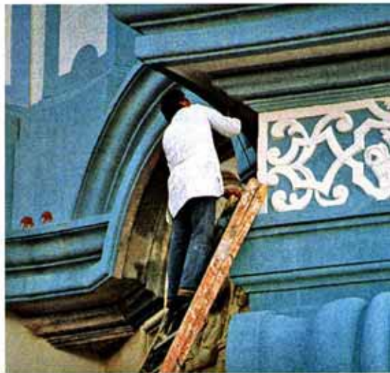
Turmnordseite — letzte Malerarbeiten, 20. Oktober 1986
