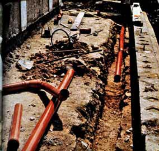
Terrasse, Juli 1986 — Kanalverlegung
