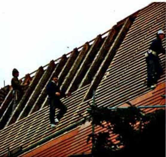
Kirchensüdseite — neue Lattung
