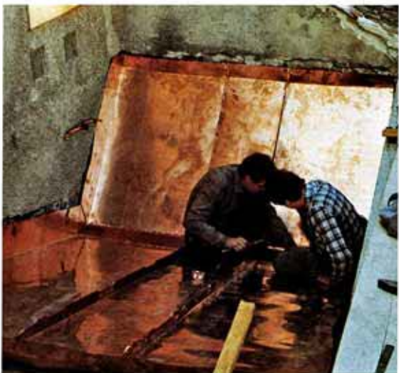
Sakristeistiege — Blechdeckung
