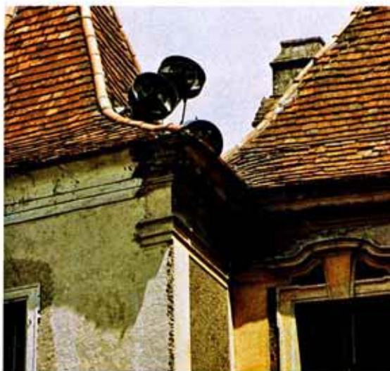
Baunaht „Salett“ (17. Jh.) — Saaltrakt (18. Jh.)
