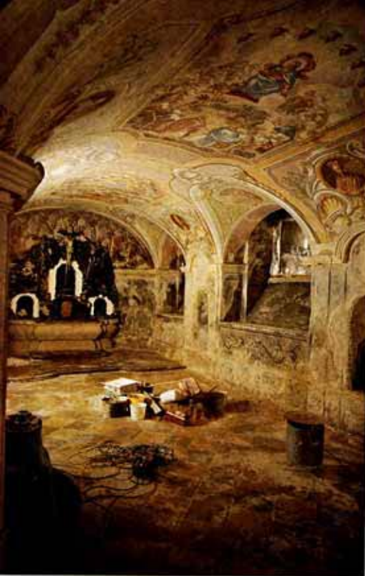
Krypta, Februar 1987, nach Entfernung der Kompressen und Reinigung
