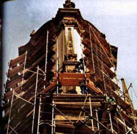
Eingerüstung des Turms, April 1986
