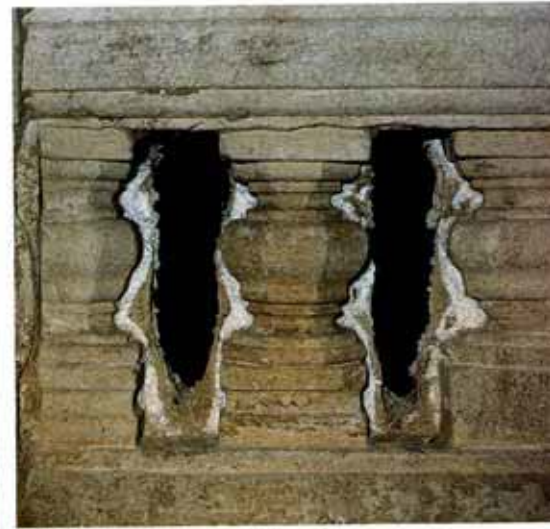
Krypta — Balustrade, Kompressen bei der Abnahme
