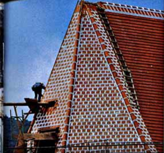
Presbyterium — Vermörtelung laut Original
