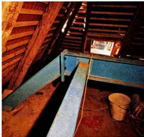
Saaldecke — statische Sicherung
