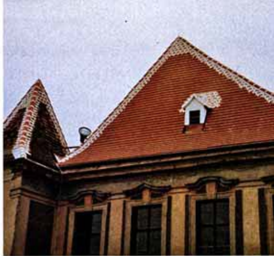
Saaldach, nach Fertigstellung, August 1986
