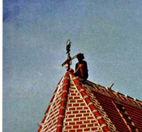
Anarbeiten der Walmkappe
