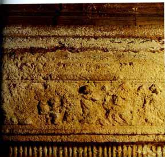
Krypta — Altarrelief (Sandstein), Schäden durch Feuchte und Mauersealze
